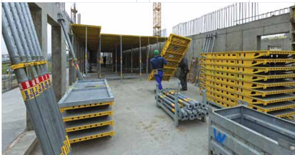
▲ Панели переносятся и монтируются двумя рабочими
