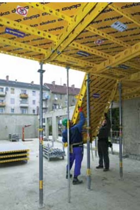
▼ Подъем панели в проектное положение
