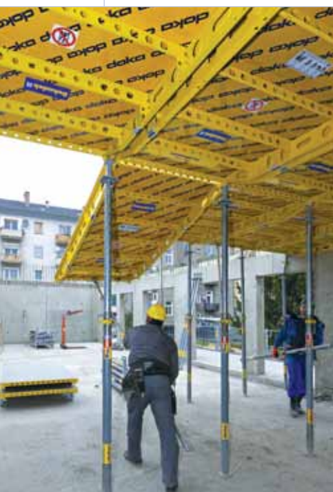
▼ Подъем панели в проектное положение
