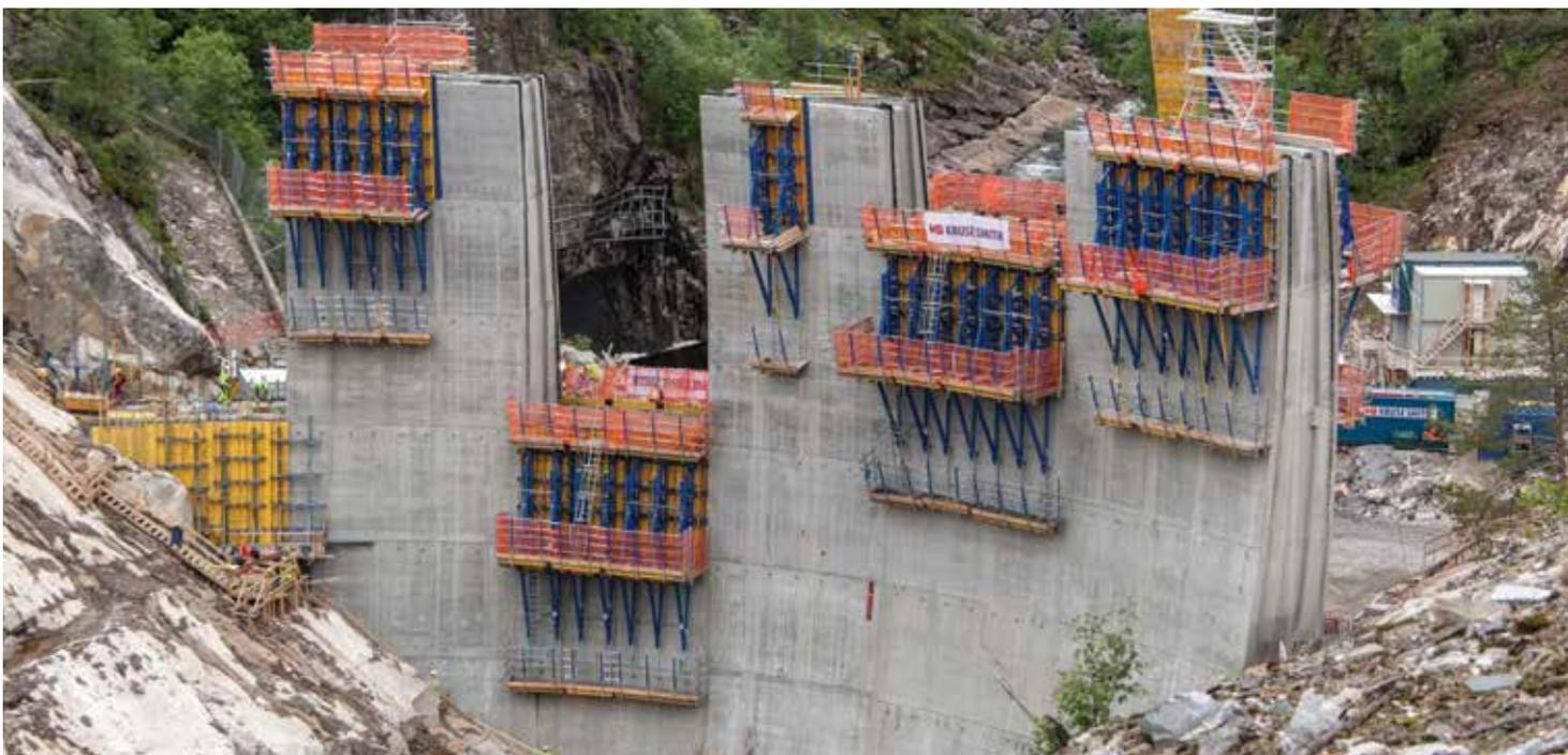
▲ Используя опалубку плотин D35, стало возможным бетонировать секции высотой 5 м. При помощи стандартной системы Doka удовлетворила требования проекта без дополнительных мероприятий на стройке и специальных решений.
