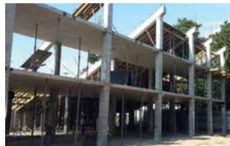
▲ На большой трибуне опорная часть для наклонных конструкций собрана из балок H20 и стоек Eurex системы балочной опалубки Dokaflex.
