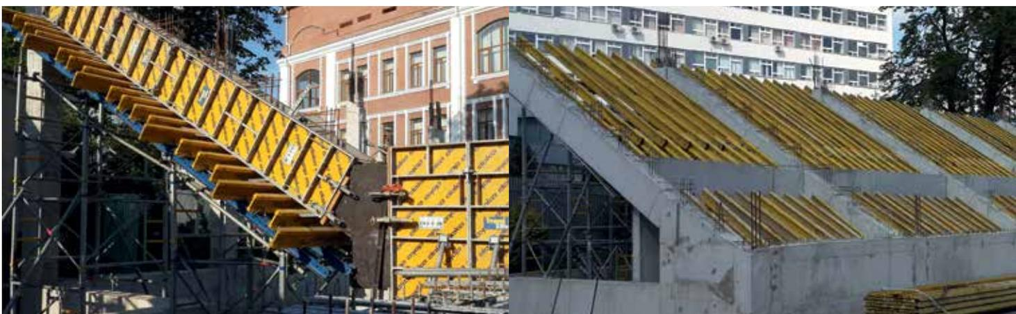
▲ Опорой для наклонных конструкций малой трибуны послужили опорные леса Staxo 100, элементы балочно-ригельной опалубки Top 50 и балки H20, ригели сформированы с использованием щитов рамной опалубки Frami Xlife.
