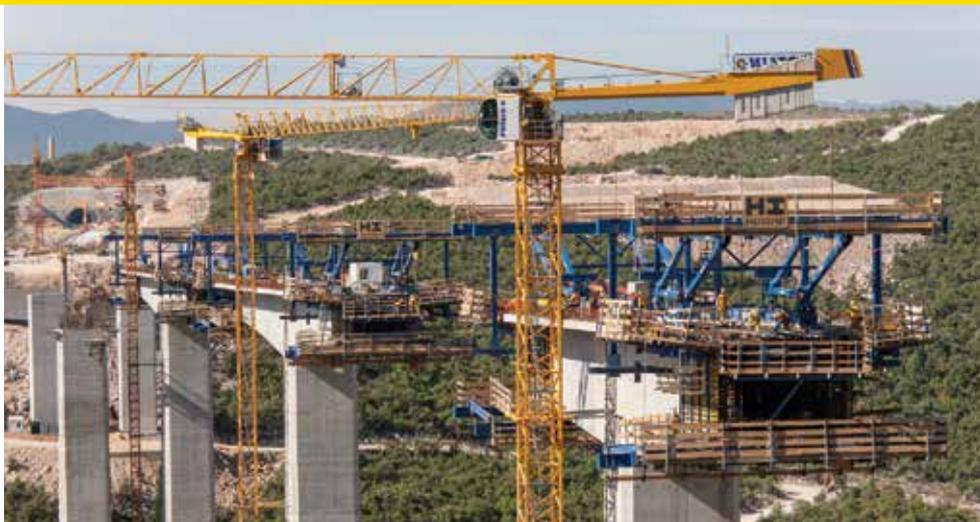
▲ Для строительства мостов длиной 555 и 365 м, Doka разработала решение на основе мостостроительных опалубочных тележек, которое сэкономило время и прочие ресурсы.
