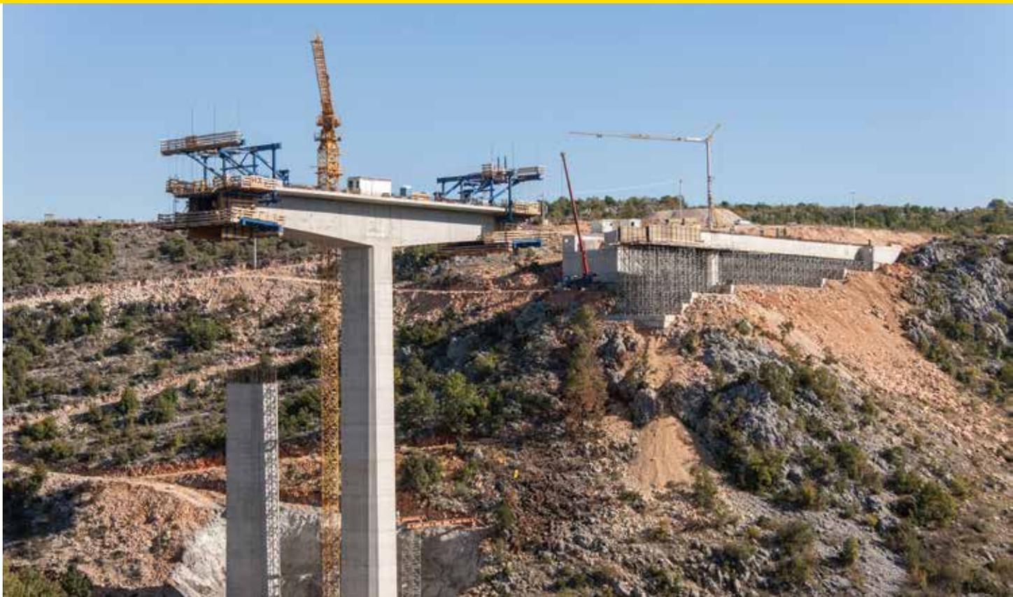
▲ Высокая производительность на большой высоте: десять опалубочных тележек Doka обеспечили быстрое и безопасное строительство двух мостов в коридоре Vc.
