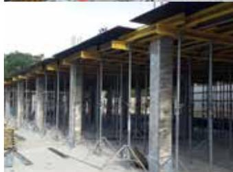
▲ Для возведения стен применена рамная щитовая опалубка Framax Xlife, для устройства перекрытий – балочная опалубка ручной сборки Dokaflex.
