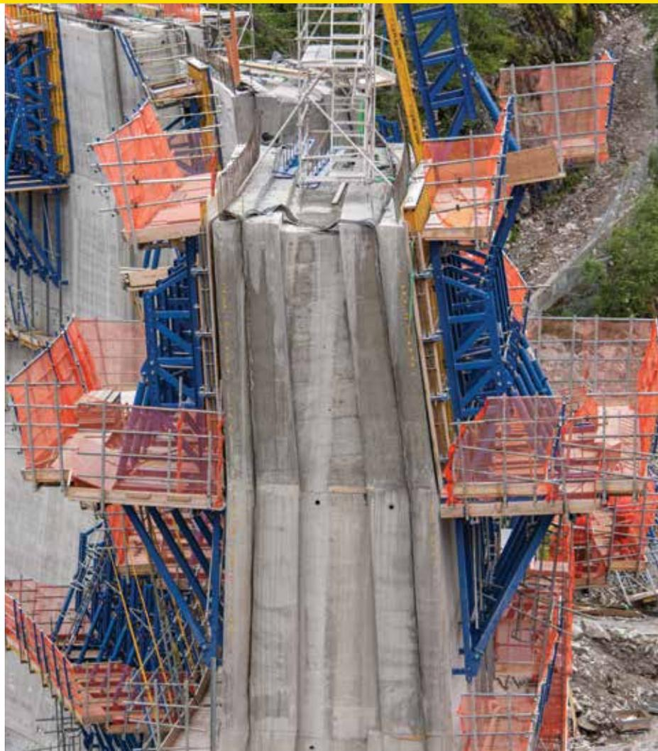
▲ Система опалубки плотин D35, с ее высокой допустимой силой растяжения, действующей на анкер, 350 кН, идеально подошла для строительства плотины Sarvsfossen. В основании плотина имеет в сечении от 6 до 7 м и сужается до 2,5 м на гребне.
