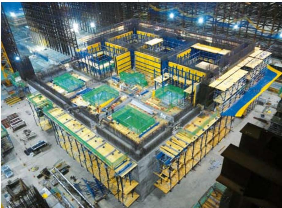
◀ A fôrma trepante SKE100 para o núcleo já chegou à obra. 117 mecanismos trepantes elevarão a fôrma e três bombas de concretagem.
