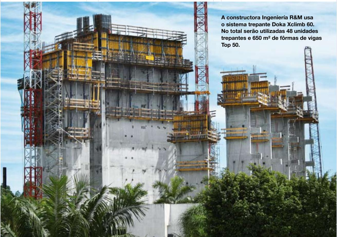
**A construtora Ingenieria R&M usa o sistema trepante Doka Xclimb 60. No total serão utilizadas 48 unidades trepantes e 650 m<sup>2</sup> de fôrmas de vigas Top 50.**
