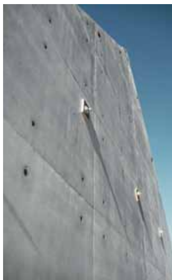
▲ Le résultat de béton dû au coffrage Top 50 est impeccable sur les voiles du bâtiment culturel.
