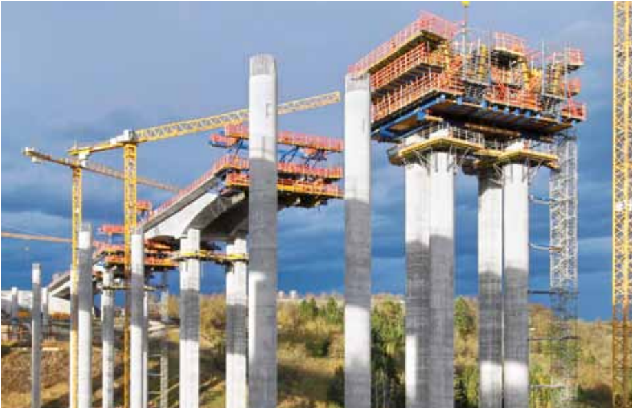
▲ Die Lahntalbrücke überspannt den Talgrund in bis zu 50 m Höhe.
