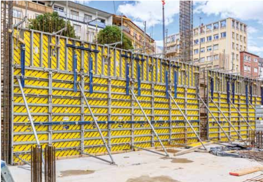
▲ Bei den geraden Wandscheiben sorgt Rahmenschalung Framax Xlife für einen schnellen Bauablauf.
