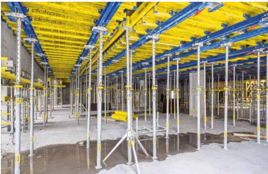
▲ Bei den Deckenflächen sind riesige Mengen Dokamatic-Deckentische im Einsatz.
