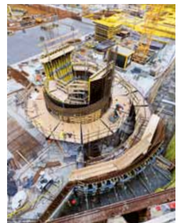
▲ An Sonderschalung hat der Doka-Fertigservice Top 50-Rundelemente und runde Aussparungskästen für die Ein- und Ausfahrtspindeln geliefert.
