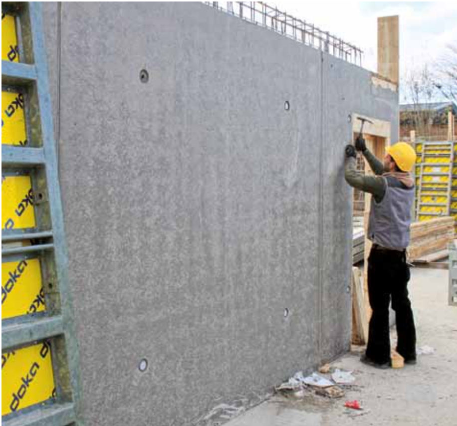
▲ Die abgestimmten Elementformate und die innenliegenden Ankerstellen ergeben immer ein geordnetes Anker- und Fugenbild.
