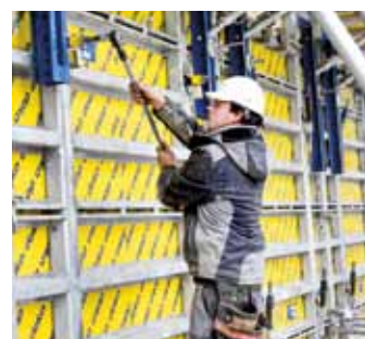
▲ Das Lösen der Framax Xlife plus-Anker geht mit der langen FXP-Knarre problemlos von der Hand.
