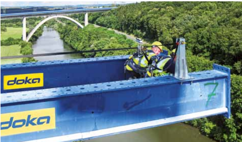
▲ Doka-Schalungsvormonteure beim Aufbau der Stahlträgerroste in schwindelerregender Höhe über der Lahn.
