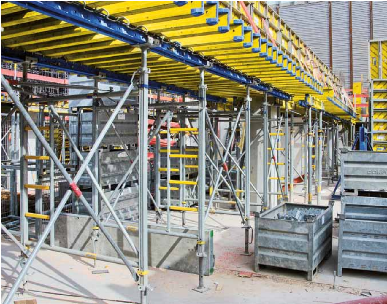
▲ Die massiven Stahlbetonträger im Übergang vom Erdgeschoss in die Untergeschosse werden mit Traggerüsten Staxo und Oberkonstruktion Top 50 erstellt.
