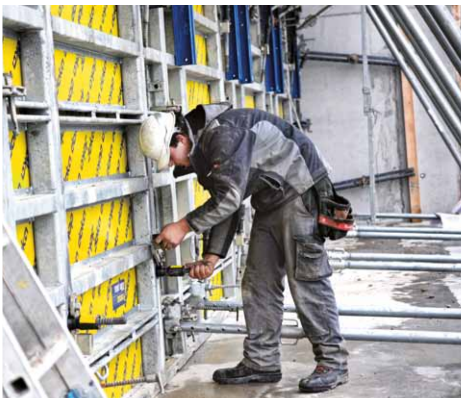
▲ Der Framax Xlife plus-Anker wird einseitig von einer Person bedient. Der Einbau von Hüllrohren und Kone entfällt.
