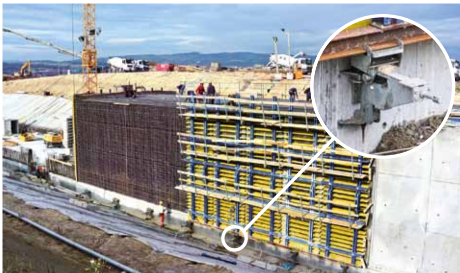
▲ Clevere Lösung: Konsolen sorgen für die sichere, leichtgängige Führung – angetrieben durch bloße Muskelkraft.
