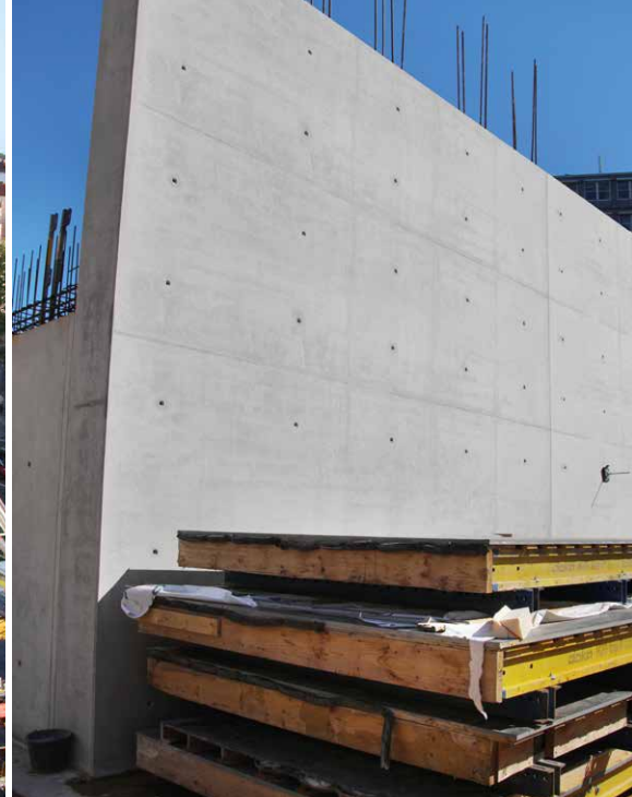
Das Ergebnis spricht für sich: Eine Sichtbetonwand, deren optimaler Ausschalzeitpunkt mit Concremote gemessen und terminiert wurde.
