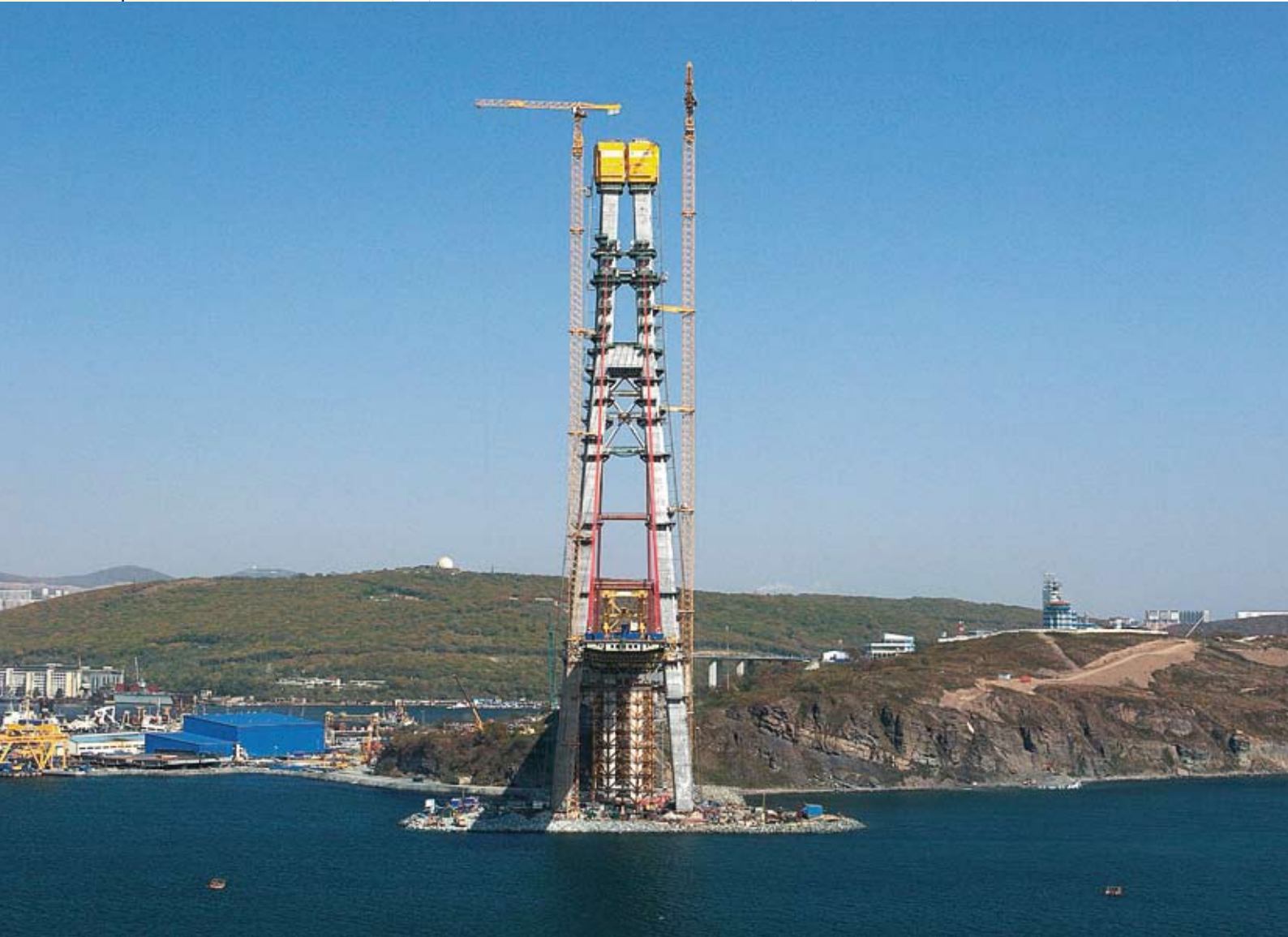
▲ Doka의 자동화 클라이밍 폼웍 솔루션은 주 시공업체 Mostovik에 의해 블라디보스톡의 320 m A형 현수형 주탑에 사용되었다.
