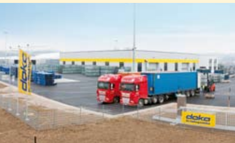
▲ 새로운 'iLOC'으로서, Doka는 새로운 장기적 차원의 실행 계획을 수행하였다.
