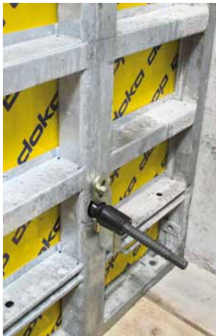
▲ Détail d'ancrage du nouveau Framax Xlife plus. Un seul opérateur est nécessaire pour le manipuler, ce qui économise d'importants coûts salariaux.
