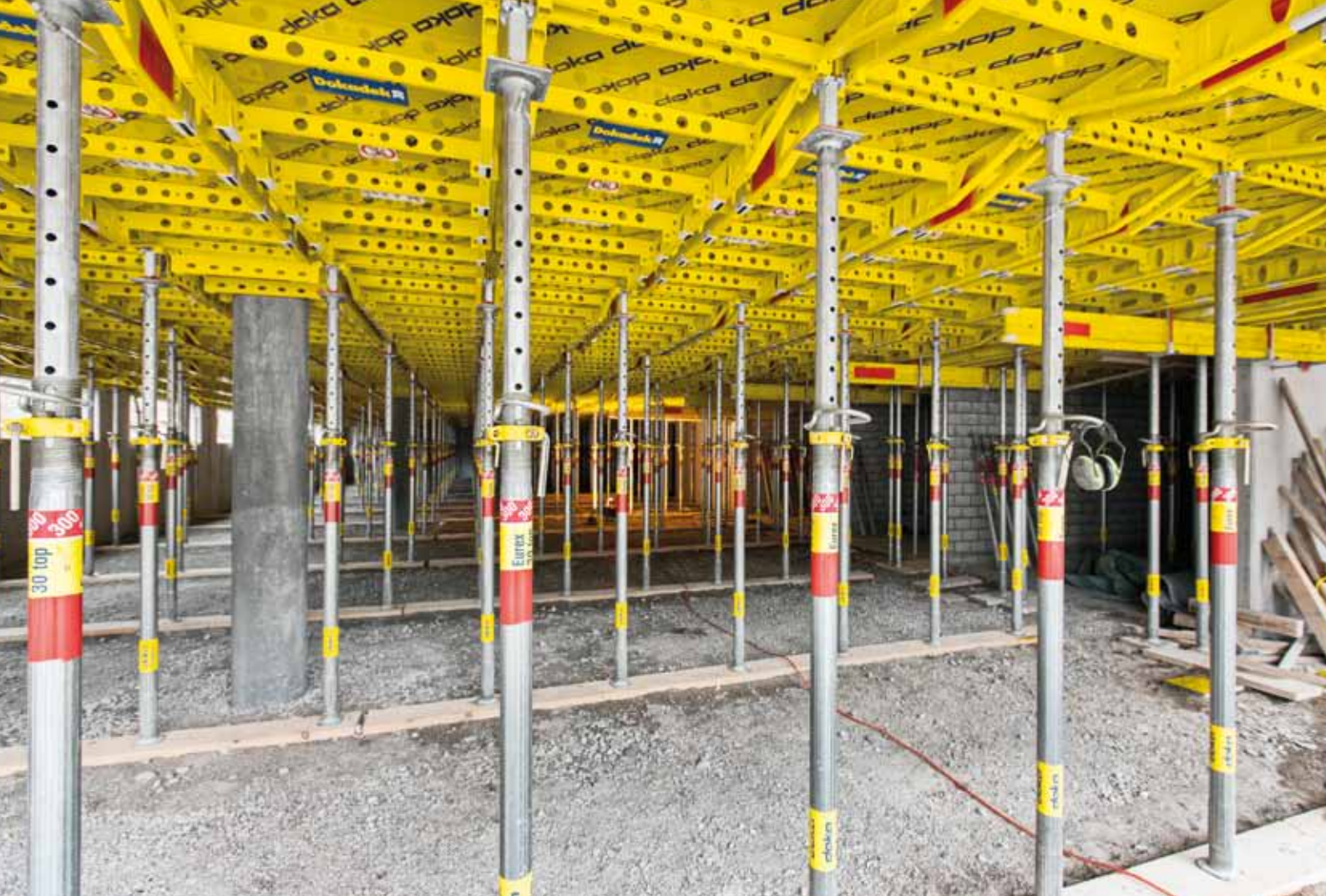
▲ Coffrage modulaire de dalles Dokadek 30 mis en œuvre pour la superstructure « Bohnenrüti » à Schattdorf.
