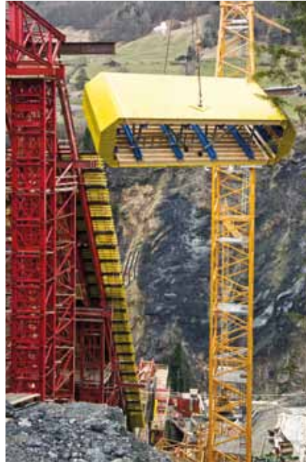
▲ Coffrage intérieur pour l'arche du pont
