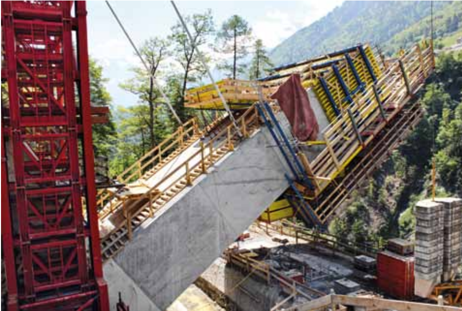
▲ Coffrage extérieur pour l'arche du pont
