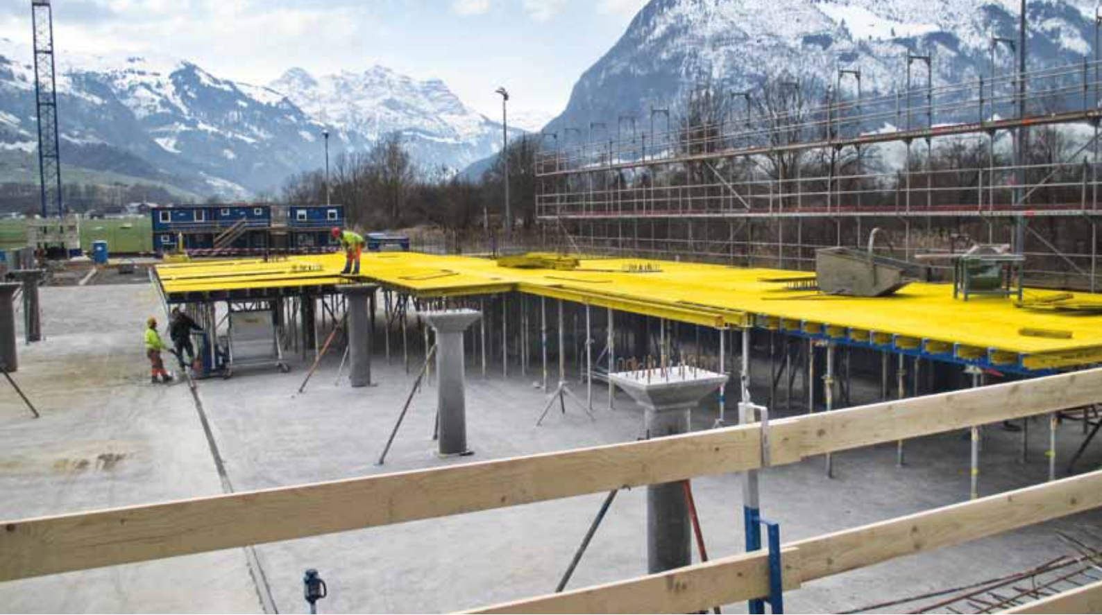
▲ Mise en œuvre de tables Dokamatic pour la construction d'un parking couvert aux usines Pilatus.
