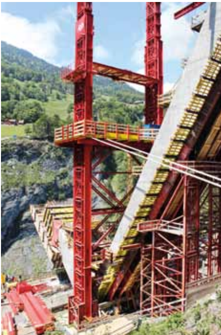
▲ Vue de la pile (d) et de l'arche (g)
