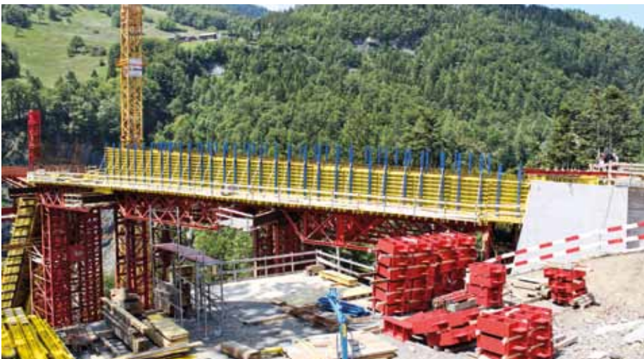
▲ Coffrage Doka pour le caisson creux du pont
