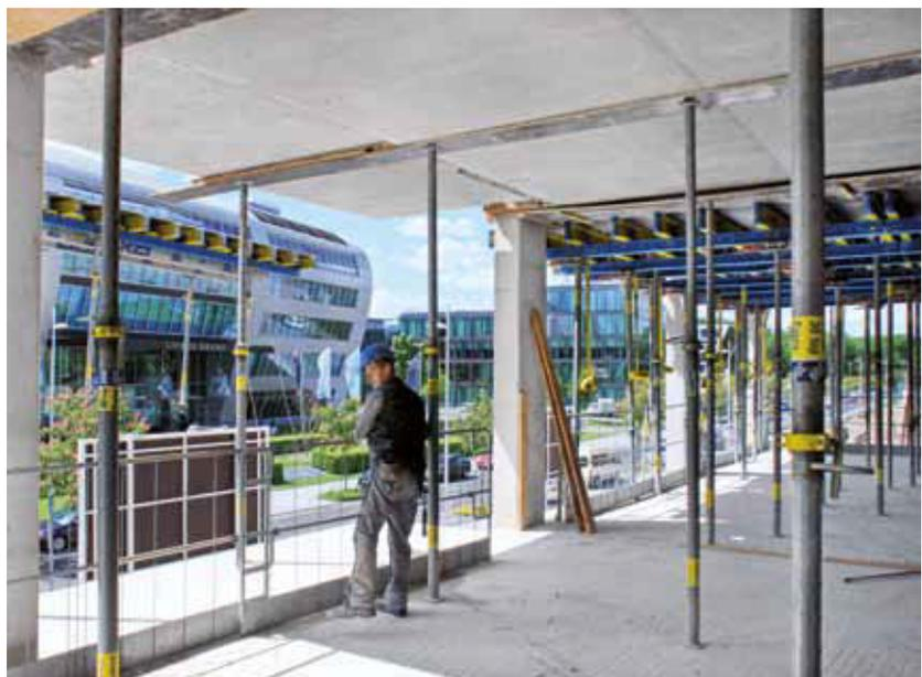
▲ Unmittelbar nach dem Ausheben der Dokamatic-Tische werden die Deckenränder mit dem Seitenschutzsystem XP gesichert.
