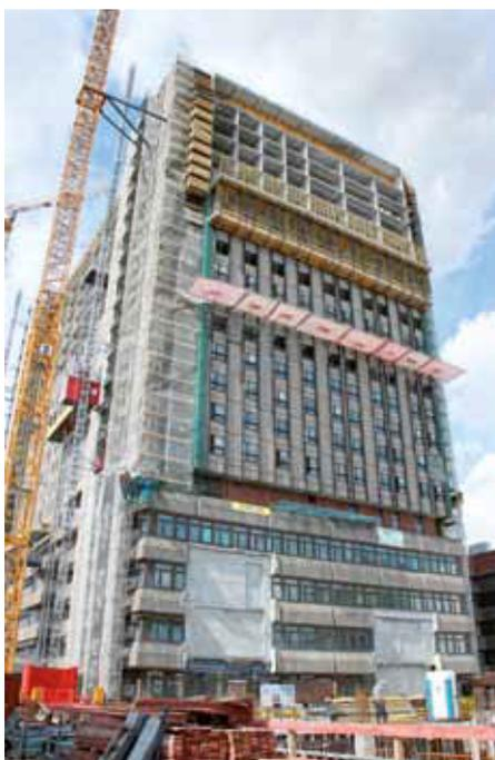
▲ Zur Demontage der alten Waschbetonfassade klettern die Bühnen dem Bauablauf folgend von oben nach unten.
