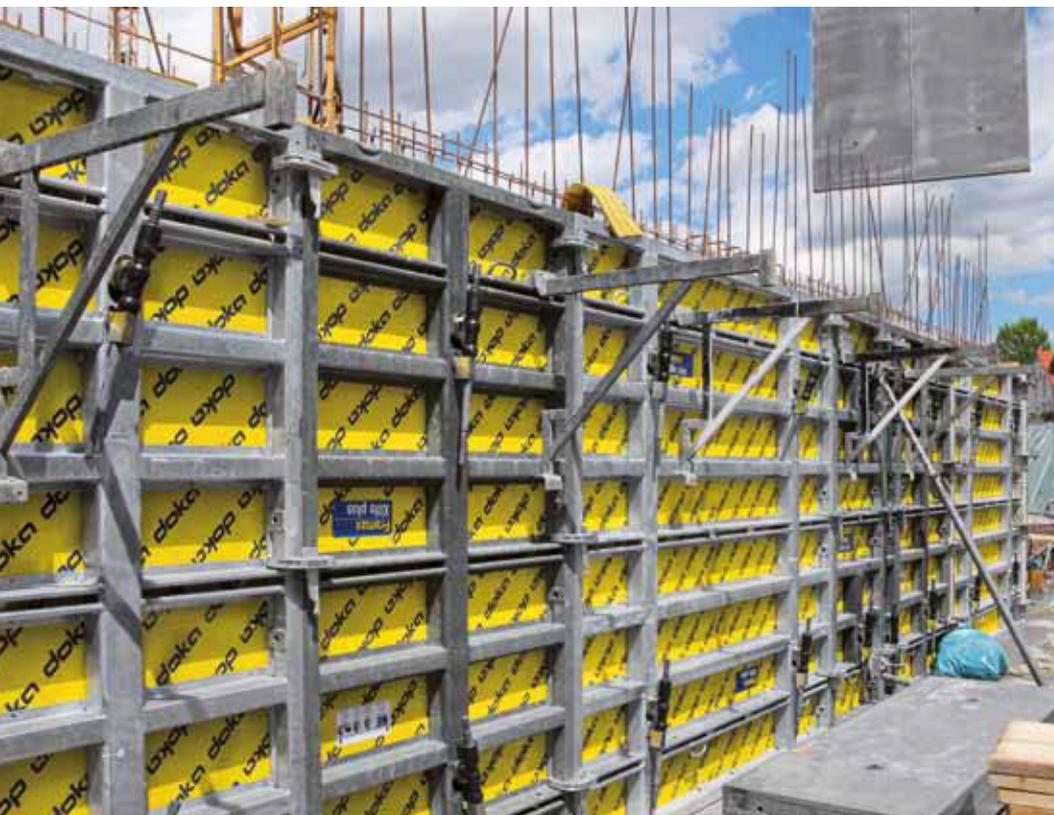
▲ Nach dem Ausschalen lassen sich die Framax Xlife plus-Anker griffbereit in der Distanzsicherung parken. Beim Einschalen nach dem Umsetzen sind sie sofort wieder zur Hand. Entsprechende Such- und Wegezeiten entfallen.
