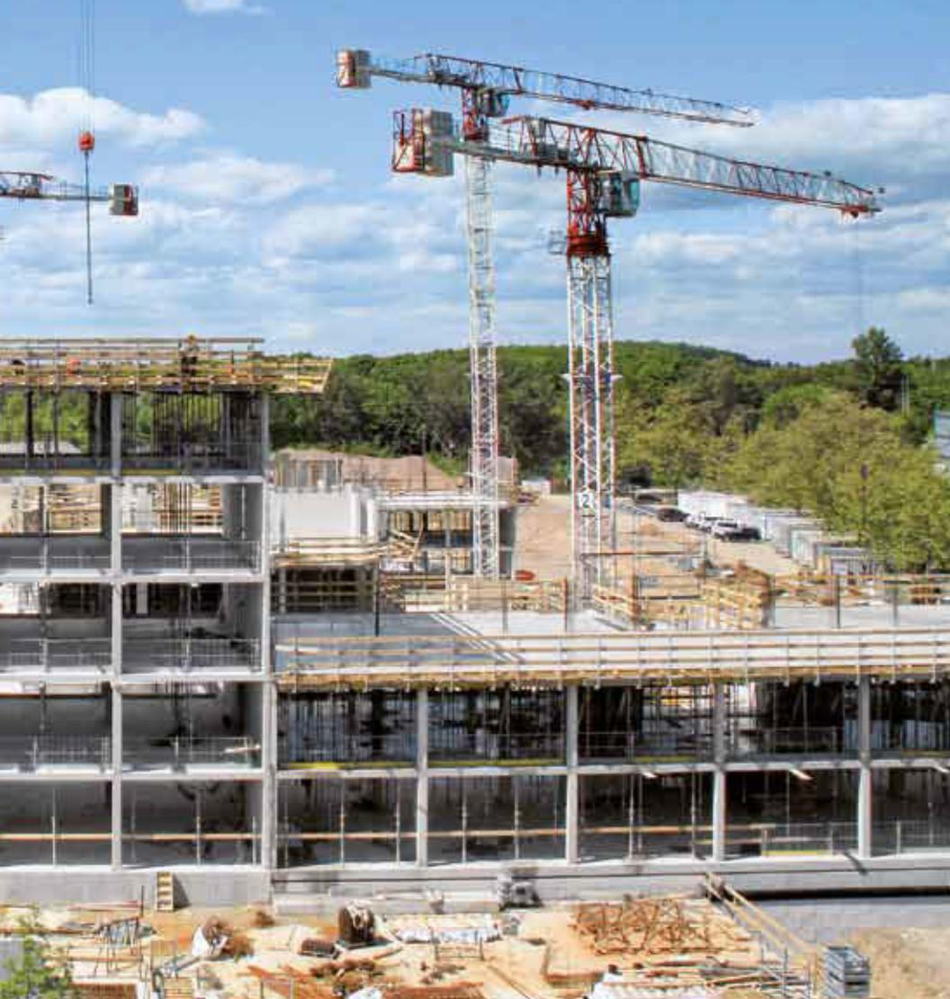
◀ Das Projekt Rhein-Palais ist in Stahlbeton-Rahmenbauweise konzipiert und eignet sich bestens für Dokamatic-Deckentische.
