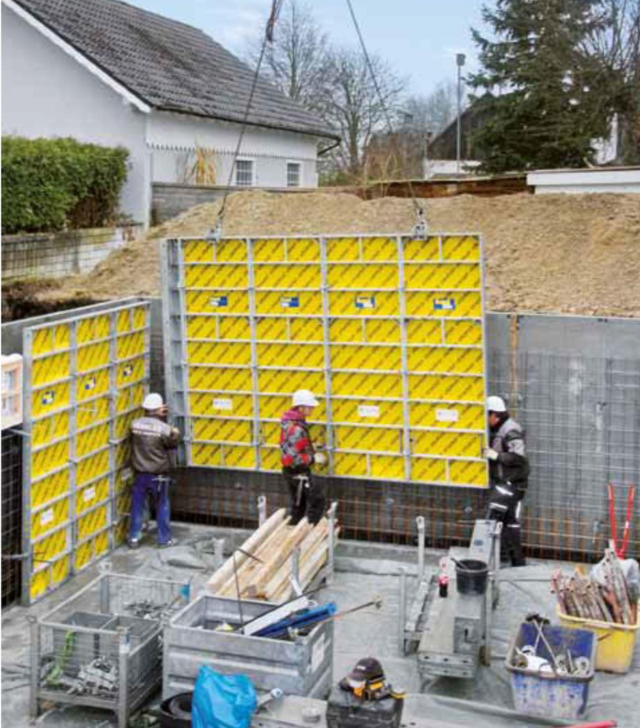
▲ Die leichte Rahmenschalung Frami Xlife mit ihrem robusten, feuerverzinkten Stahlrahmen ist von Hand einsetzbar und stabil genug für großflächiges Schalen - auch mit niedrig belastbarem Kran.
