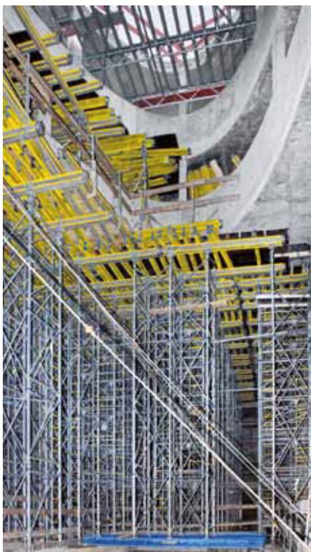
▲ Die Staxo-Türme stehen auf SL-1-Profilen und sind abgespannt, um auch höhere Horizontal-Lasten sicher aufzunehmen.
