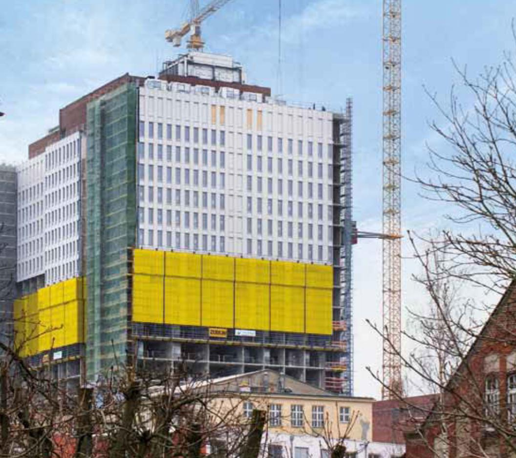
◀ Zur Montage der neuen Fassadenelemente kommt das selbstkletternde Schutzschild Xclimb 60 mit Xbright-Einhausung zum Einsatz.
