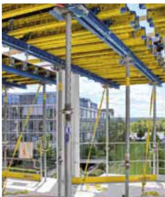
▲ Nach dem Einlegen der Passstreifen zwischen die Dokamatic-Deckentische ist die nächste Decke vorbereitet für die Eisenflechter.
