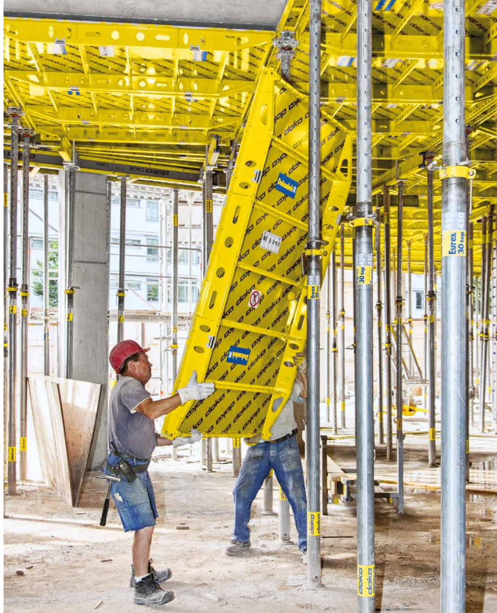
▲ Bei Deckenhöhe 4,29 m zeigt sich: Die rechteckige Form der Dokadek 30-Elemente erhöht die Reichweite gegenüber quadratischen Modulen enorm.
