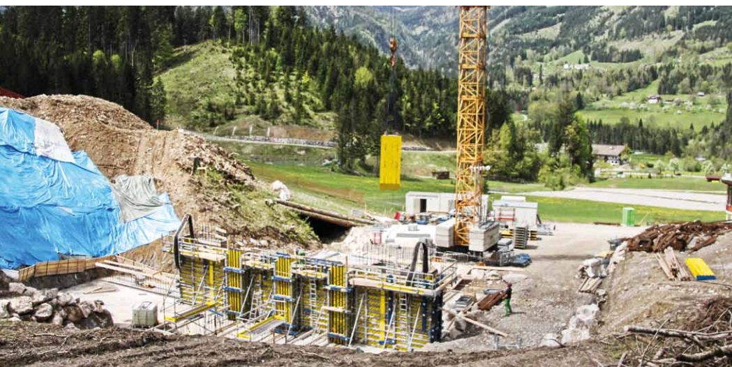
▲ Die neue Geröllsperre wird zukünftig Menschen und Infrastruktur im Tal schützen.
