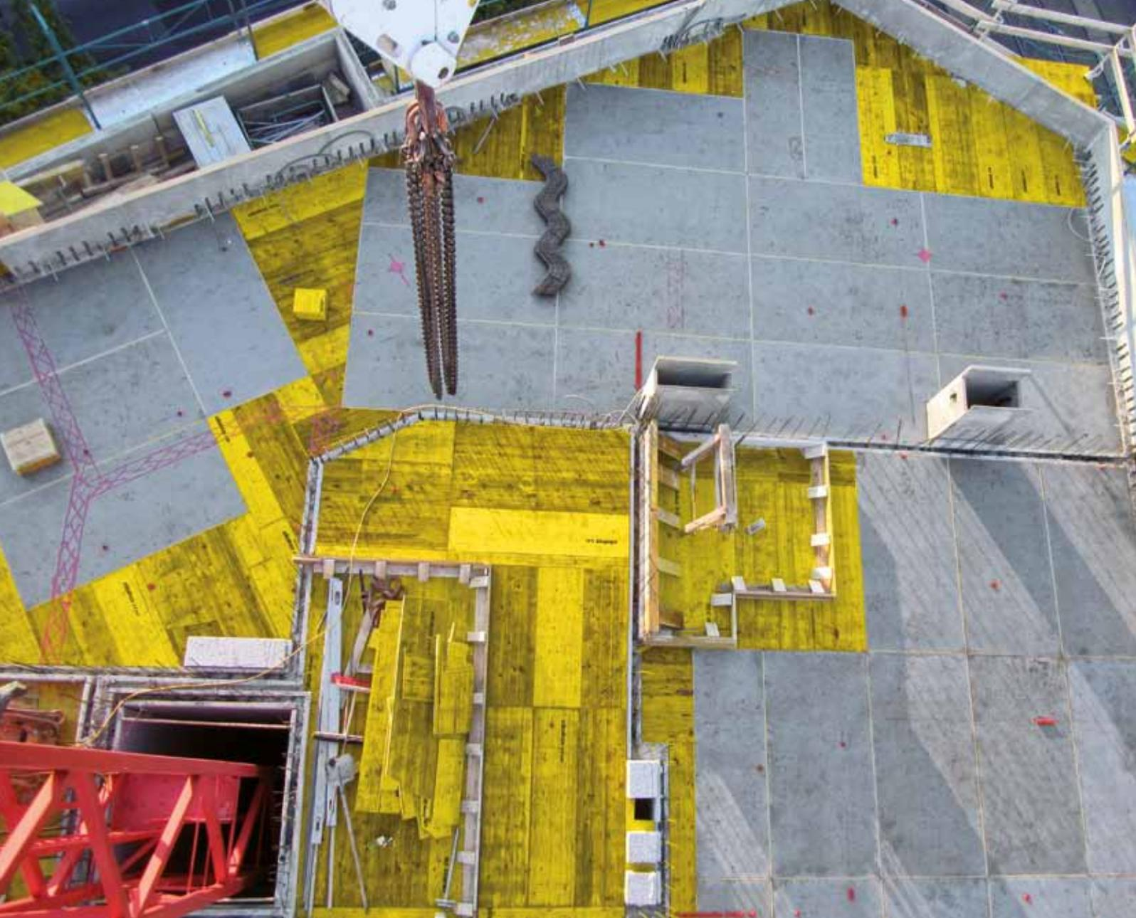
Montagefolge vorgegeben und dank weniger verschiedener Einzelteile sehr übersichtlich. Mit den 3 m<sup>2</sup> großen Elementen geht es im Regelbereich zügig voran. Der Aufbau von Dokadek 30 erfolgt in 2er-Teams vom sicheren Boden aus, ohne die Deckenschalung zu betreten. Zwei Mann hängen das Element ein. Einer von beiden schwenkt das Element in seine endgültige Position hoch, der zweite Mann fixiert das Element mit der Deckenstütze.
