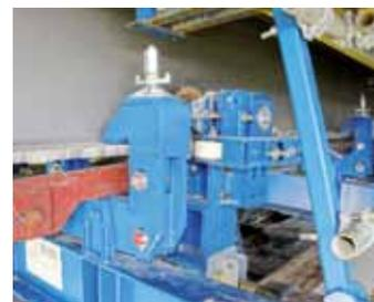
▲ Während des Betoniervorgangs hängen die Verbundschalwagen zuverlässig in Aufhängezangen.
