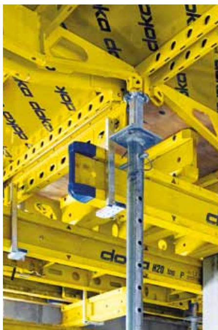
▲ Aus der Vogelperspektive wird deutlich, wie geschickt Element-Deckenschalung und Dokaflex kombiniert sind – äußerst effizient hergestellt dank einfacher Handhabung.
