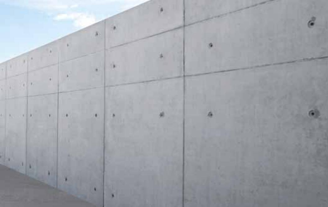
◀ Abgestimmte Elementformate und innen liegende Ankerstellen sorgen für einen stets geordneten Fugenverlauf mit einem symmetrischen Ankerbild auch bei Kombination stehender mit liegenden Elementen.
