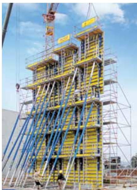
▲ Montage einer großflächigen Umsetzeinheit für die bis zu 14,13 m hohe, querliegende Schottwand.
