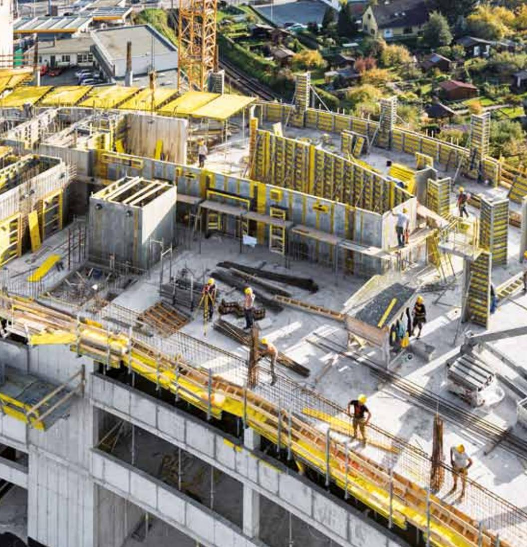
Die Herstellung dieser Innenwände hat es in sich: architektonische Anforderungen und statische Gegebenheiten stellen hohe Anforderungen an Schalungstechnik und Bauausführung. So sind die Außenflächen des Kernbereichs in Sichtbetonanforderung der Klasse 3 auszuführen, die Wände nähern sich im Grundriss polygonal einem Radius an, der Ankerraster ist vorgegeben. Außerdem ist ein hoher Bewehrungsgrad erforderlich und viele Durchbrüche
