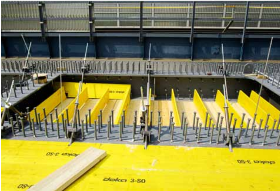
▲ Alle Arbeiten für das Einschalen, Einrichten, Bewehren, Betonieren und Ausschalen können direkt vom Tragwerk aus ausgeführt werden.
