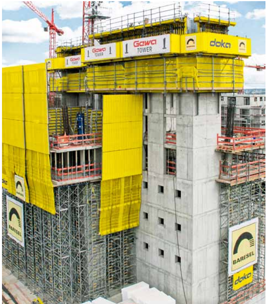
▲ Mit 107 Meter Höhe wird der GEWA-Tower künftig das höchste Wohngebäude Baden-Württembergs. Die komplette Schalungstechnik dazu kommt von Doka.
