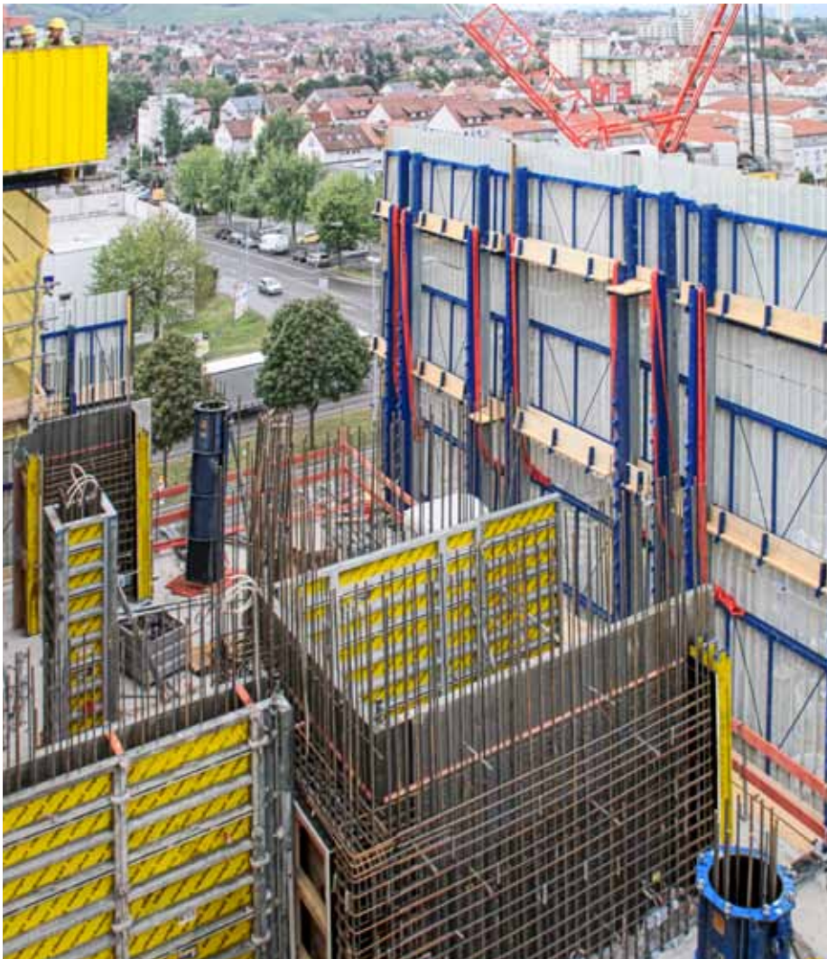
▲ Die Schutzschilde überlappen und lassen sich daher ohne Umbau durch Teleskopieren der von Etage zu Etage zunehmenden Gebäudebreite einfach anpassen.
