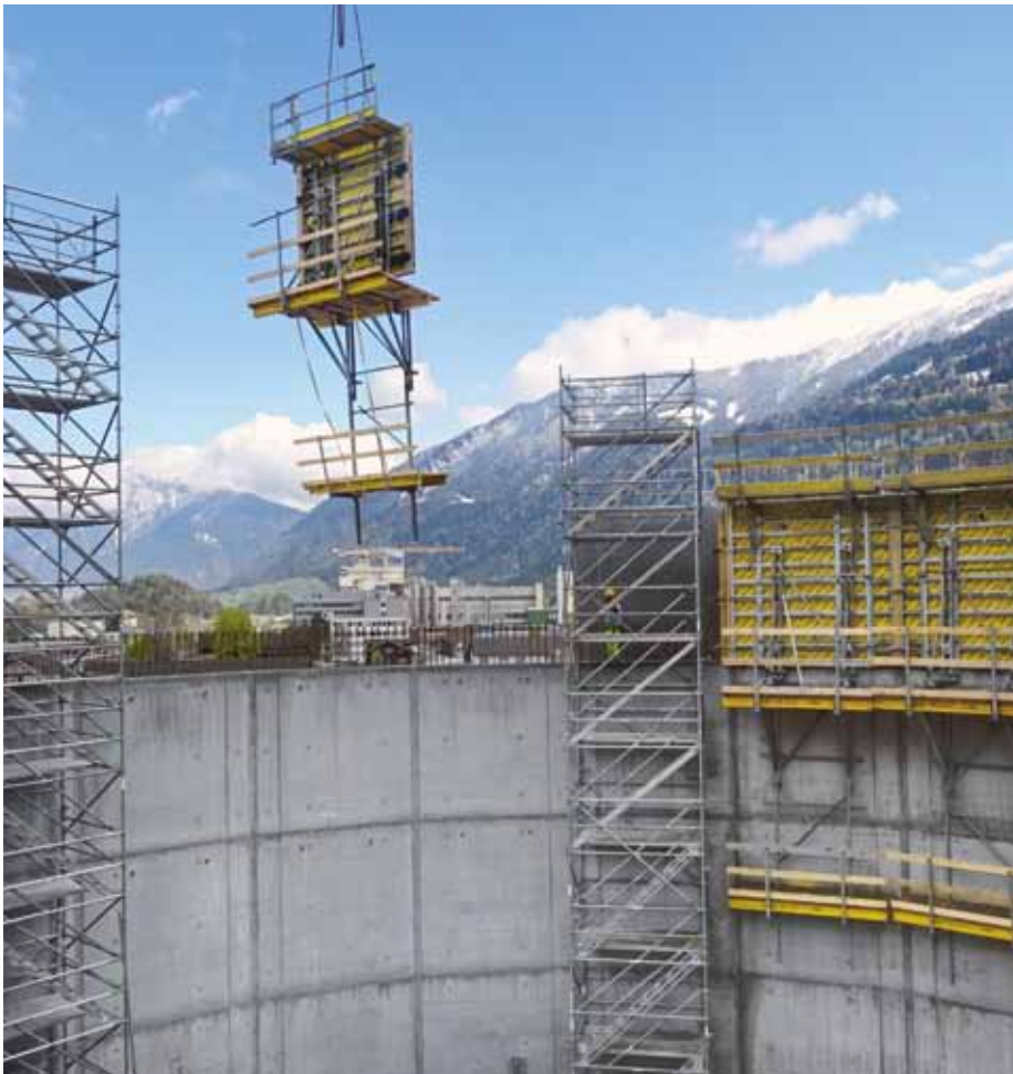
▲ Mit nur einem einzigen Kranhub lässt sich die Kombination aus Kletterschalung MF240 und Rahmenschalung Framax Xlife plus inklusive Bühnensystem Xsafe plus schnell und einfach umsetzen.
