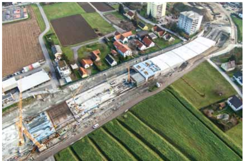
▲ Aus der Luft ist der Nutzen der Unterflurtrasse klar ersichtlich: Pendler und Anrainer profitieren vom Bauwerk.
