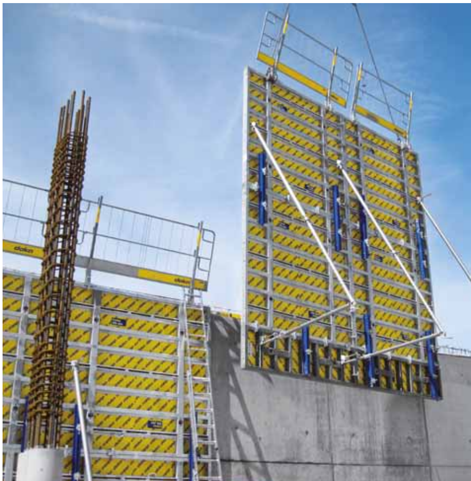
▲ 33 m 2 Wandschalung inklusive Gegengeländer werden in einem Kranhub umgesetzt.
