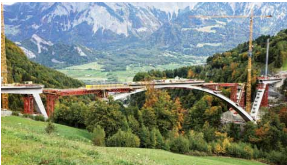
▲ Die Bogenbrücke wird von beiden Seiten kommend über die 200 m tiefe Schlucht gebaut.
