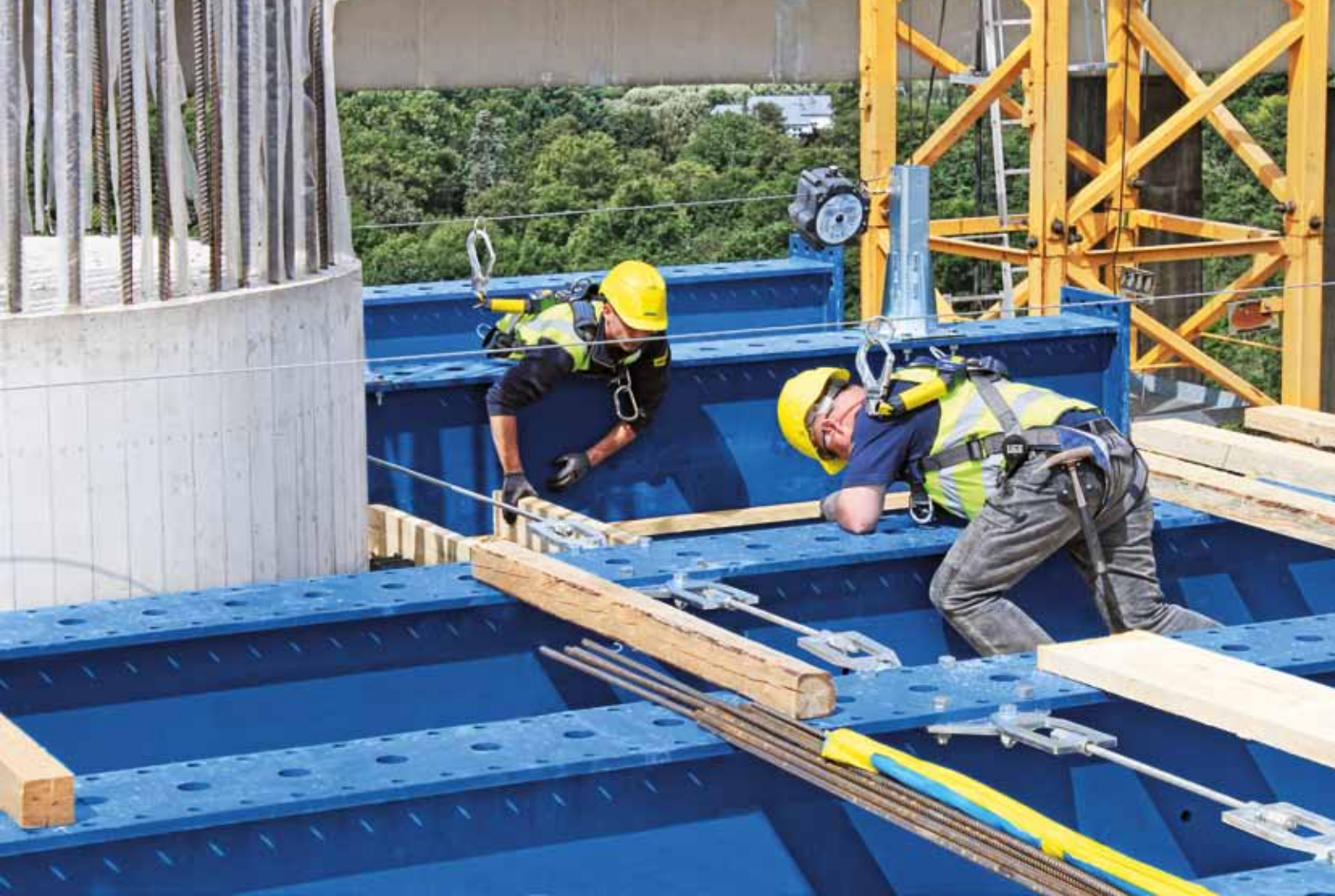
▲ Für die Errichtung der Lahntalbrücke bei Limburg wurden die Montagen, Demontagen und Umsetzvorgänge der zwei Stahlträgerroste sowie die vier Freivorbauwagen durch das Schalungsvormontage-Team von Doka schnell und effizient realisiert.
