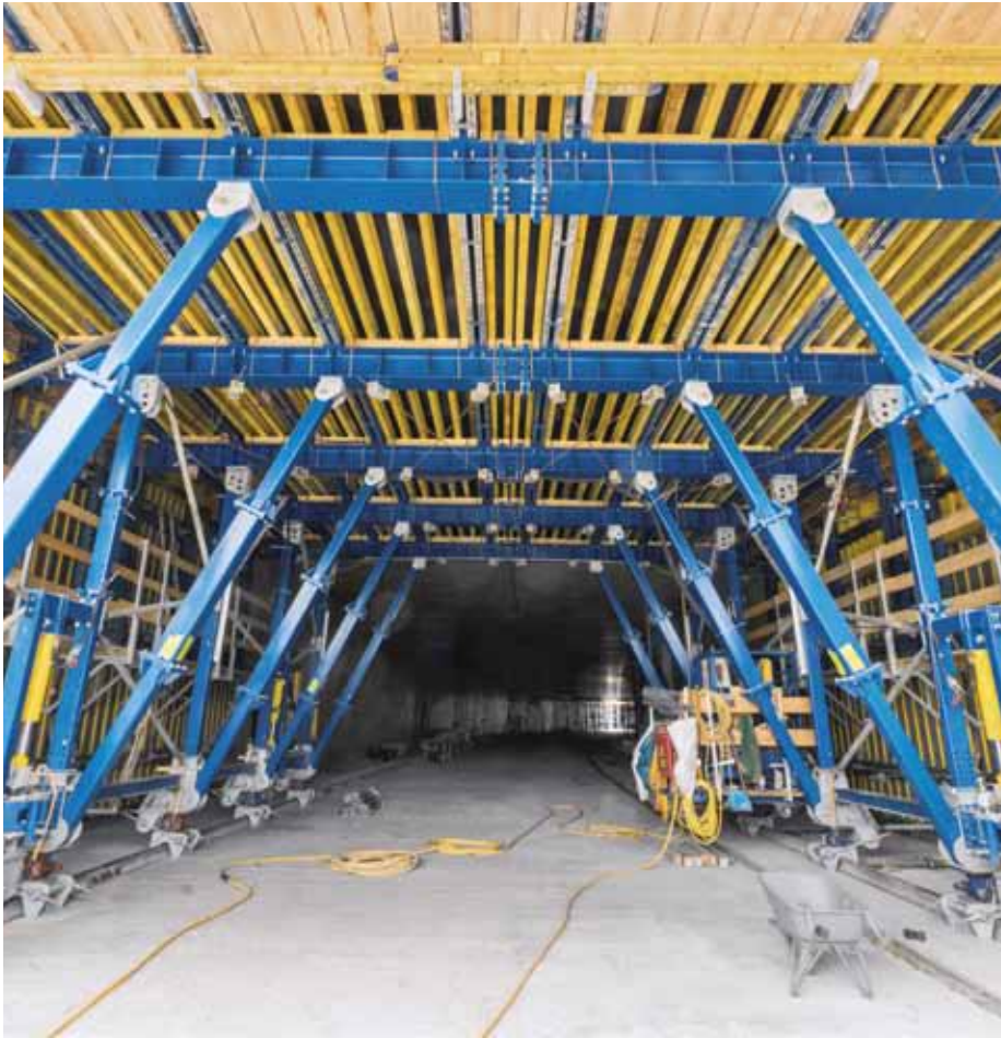
▲ Tunnelschalungen von Doka passen sich den unterschiedlichen Anforderungen an, für einen wirtschaftlichen Materialeinsatz und einen schnellen Baufortschritt.
