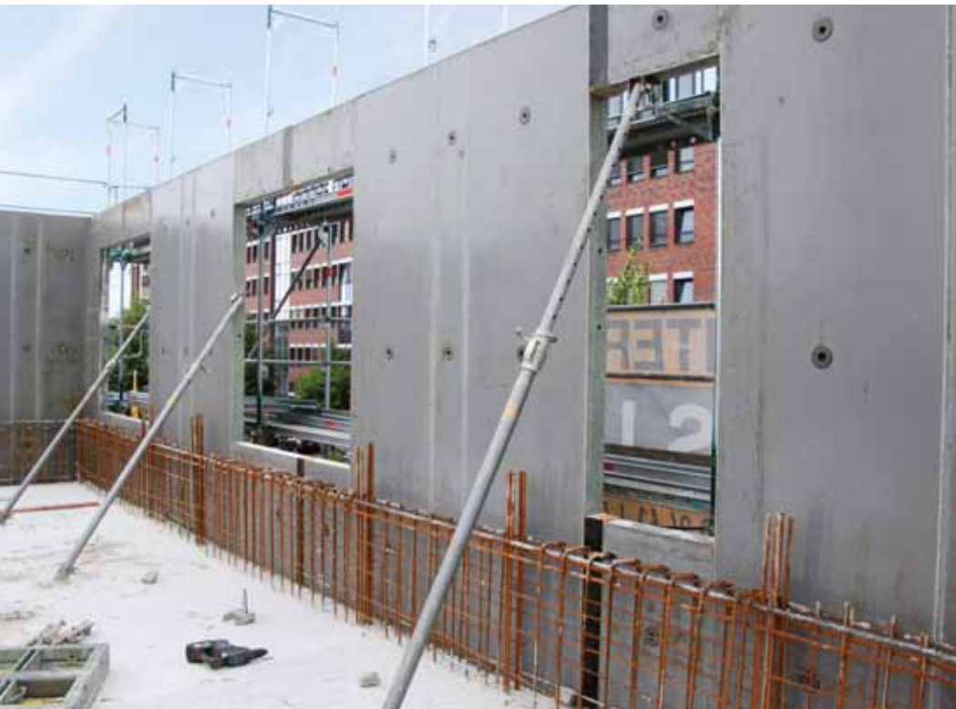
▲ Die Vorstellungsschalung steht außen. Der große Vorteil: Die Bewehrung kann auf der fertiggestellten Decke gelagert und ganz ungehindert von hier aus auch eingebaut werden.
