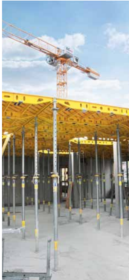
▲ Dokadek 30 – eine gute Wahl: Im Regelfall werden auf der Baustelle in Köln 22 cm starke Flachdecken bis 3,63 m Höhe geschalt – in Summe fast 18.000 m 2 .
