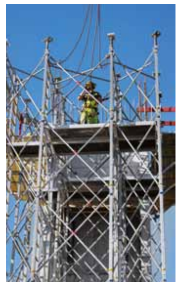
▲ Beim Bau der neuen Hubschrauberlandeplattform des Donauislar Klinikums Deggendorf montierte das Schalungsvormontage-Team 12 m hohe Staxo 100-Türme.
