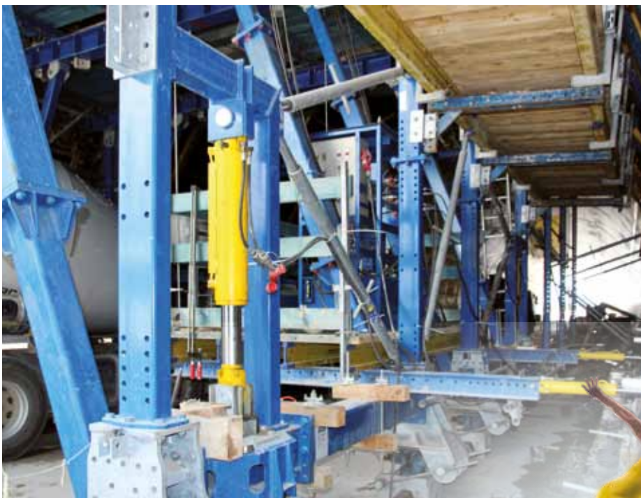
▲ Die Wandelemente lassen sich über Hydraulikzylinder zurückschwenken. Ein hydraulisches Hubwerk dient dazu, den Schalwagen auf bauseitige Schienen abzusenken.
