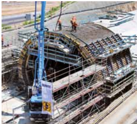
▲ Der Doka-Schalwagen aus Komponenten des Traggerüstsystems DokaCC ist mit 10,40 m Länge auf Betonierabschnitte bis zu 10 m ausgelegt.
