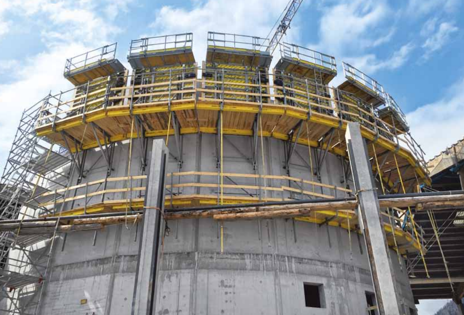
▲ Rahmenschalung Framax Xlife plus mit Kletterschalung MF240 und Bühnensystem Xsafe plus.
