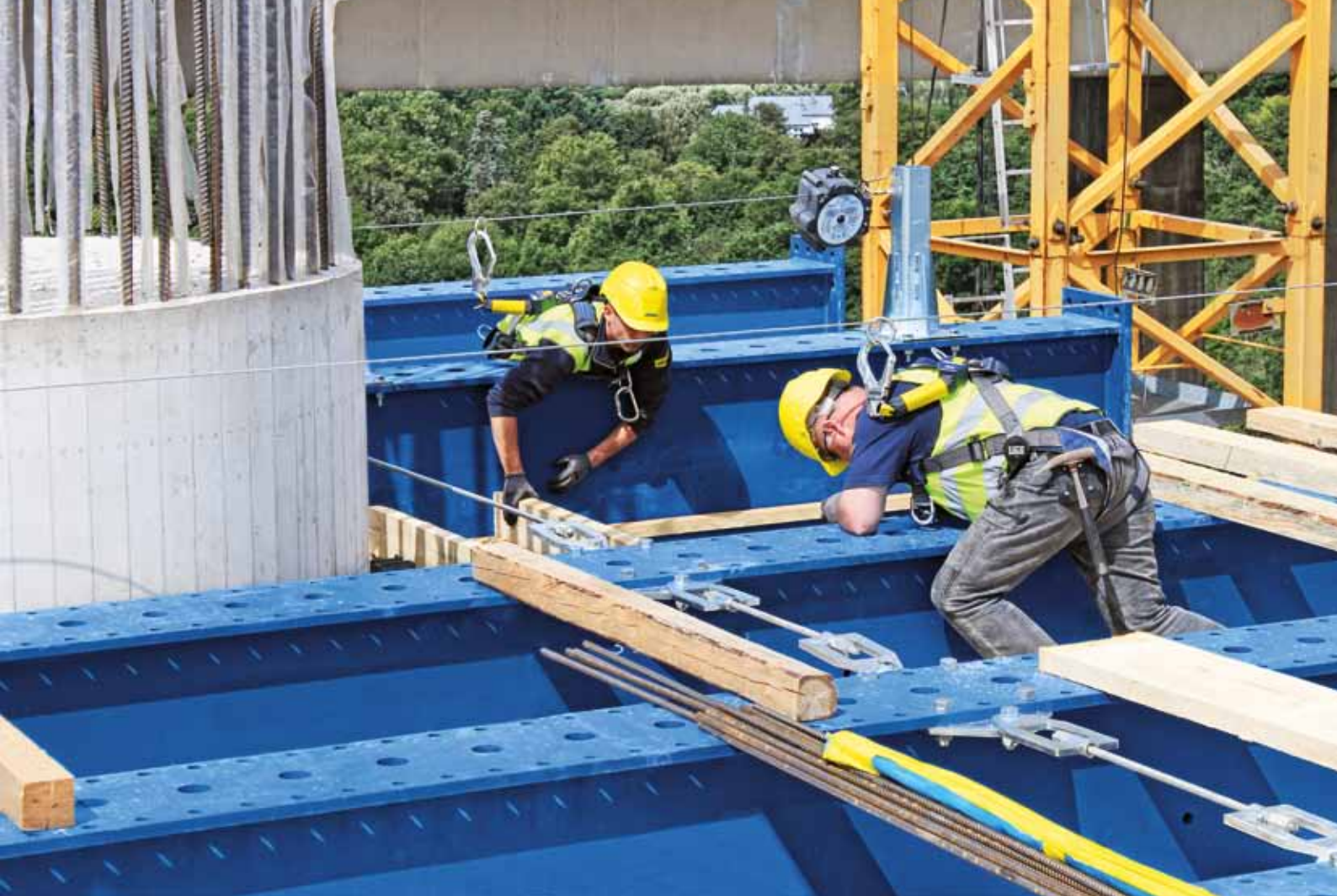
▲ Für die Errichtung der Lahntalbrücke bei Limburg wurden die Montagen, Demontagen und Umsetzvorgänge der zwei Stahlträgeroste sowie die vier Freivorbauwagen durch das Schalungsvormontage-Team von Doka schnell und effizient realisiert.
