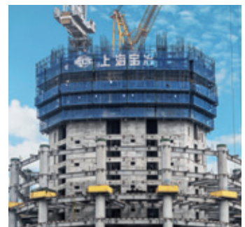
▲ 外围轻型爬模系统 SKE50 采用了全封闭的防护设计，给施工现场提供了一个安全的，防天气干扰的作业条件。
