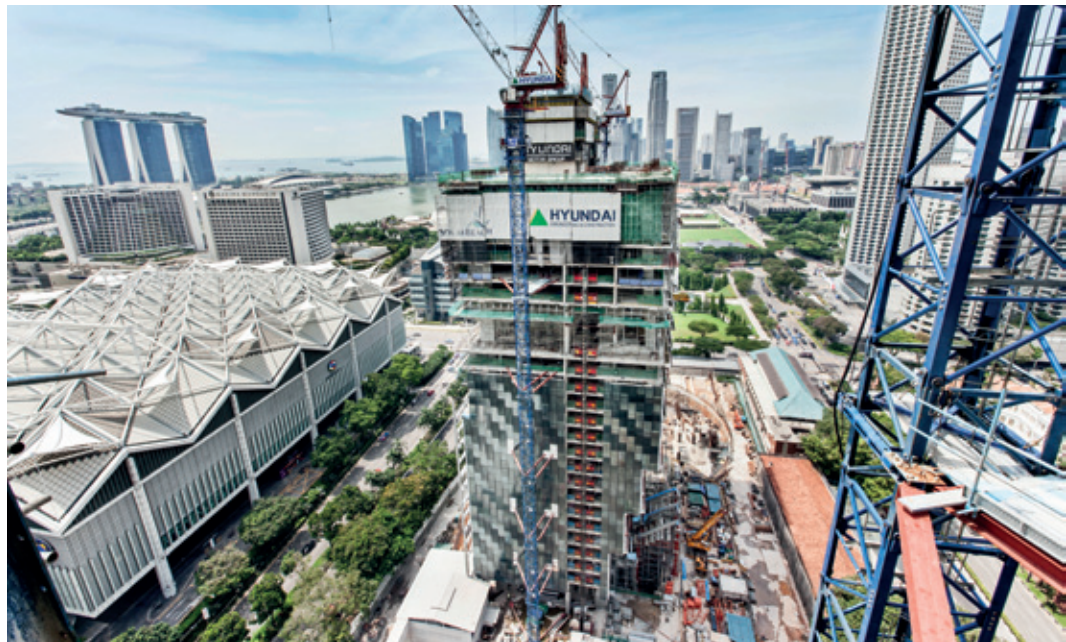
▲ 悉尼 CBD 的一个项目中预先组装并使用了带框架式围栏 Xbright 的安全防护屏 Xclimb 60。
