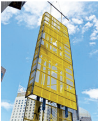
▲ 悉尼 CBD 的一个项目中预先组装并使用了带框架式围栏 Xbright 的安全防护屏 Xclimb 60。
