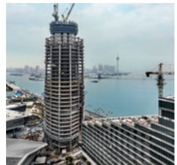
▲ 多卡组合了自动爬升模板 SKE50 和 SKE100，完全满足客户的各种施工需求。
