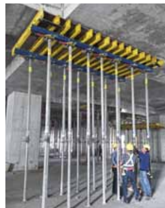
▲ Dokamatic 台模非常适合用来快速组拼大楼面面积。被 Singtel Data Centre West 项目用来组拼厚度在 30cm 到 1m 的楼板。
