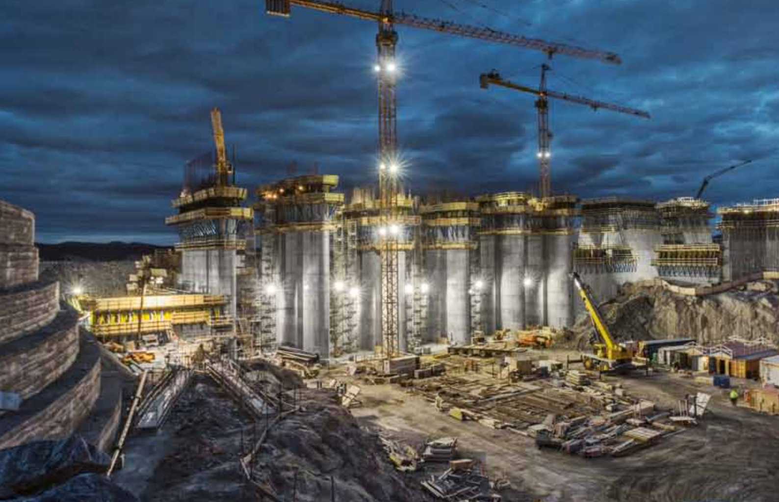
▲ 从右至左下行视图：北过渡大坝，6个溢洪道闸墩，中心过渡大坝，隔离墙
