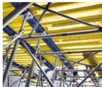
▲ d3 热浸镀锌钢框和剪刀撑的组合让塔架单撑承重能力可高达 94 kN。
