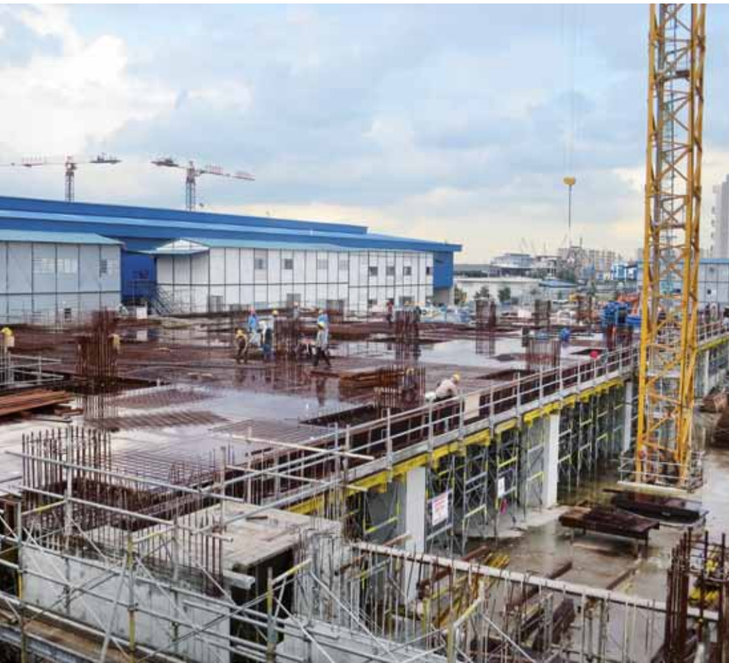
▲ 施工现场将使用约 13,700 m 2 多卡模板。
