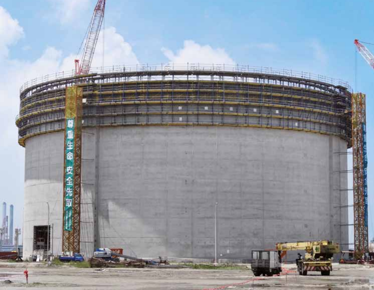
▲ 液化天然气储罐采用大面积模板 Top 50和爬升平台 D15 建造。
