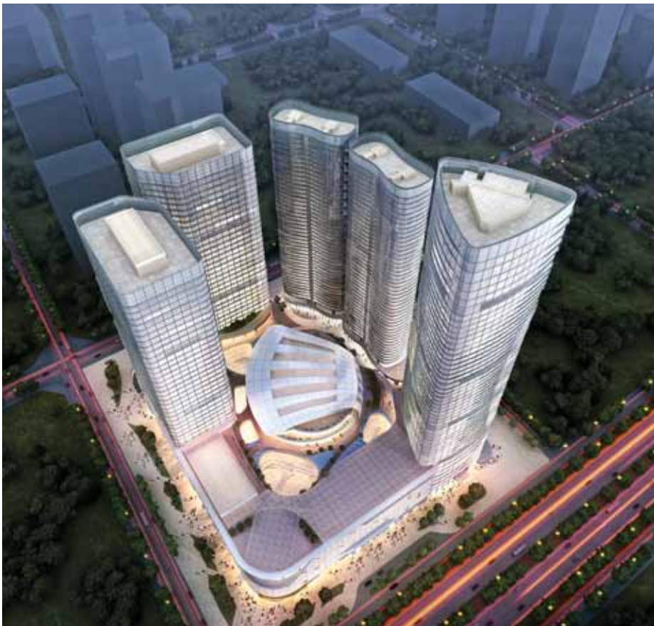
▲センターは、超高層ビル5棟と高価格のオフィスビルで構成されます。Dokaは、最も高いビルに型枠を供給しています。
