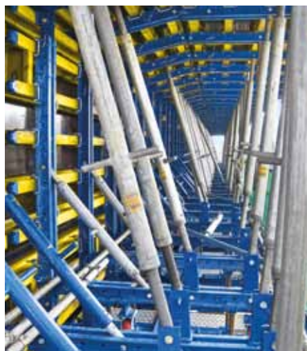
▲ スラブと側壁の型枠は、コンクリートの重さに耐えるように設計され、安全性を向上させる作業用プラットフォームとして使用できるTop 50ラージエリア型枠で構成されます。
