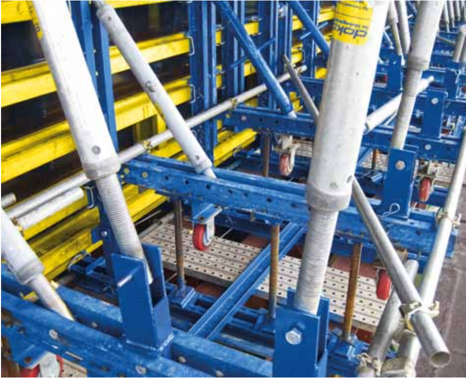
▲ 側壁とデッキスラブの型枠は、ローラーで進むように設計されました。クレーンを使う必要はないため、現場の効率が上がります。
