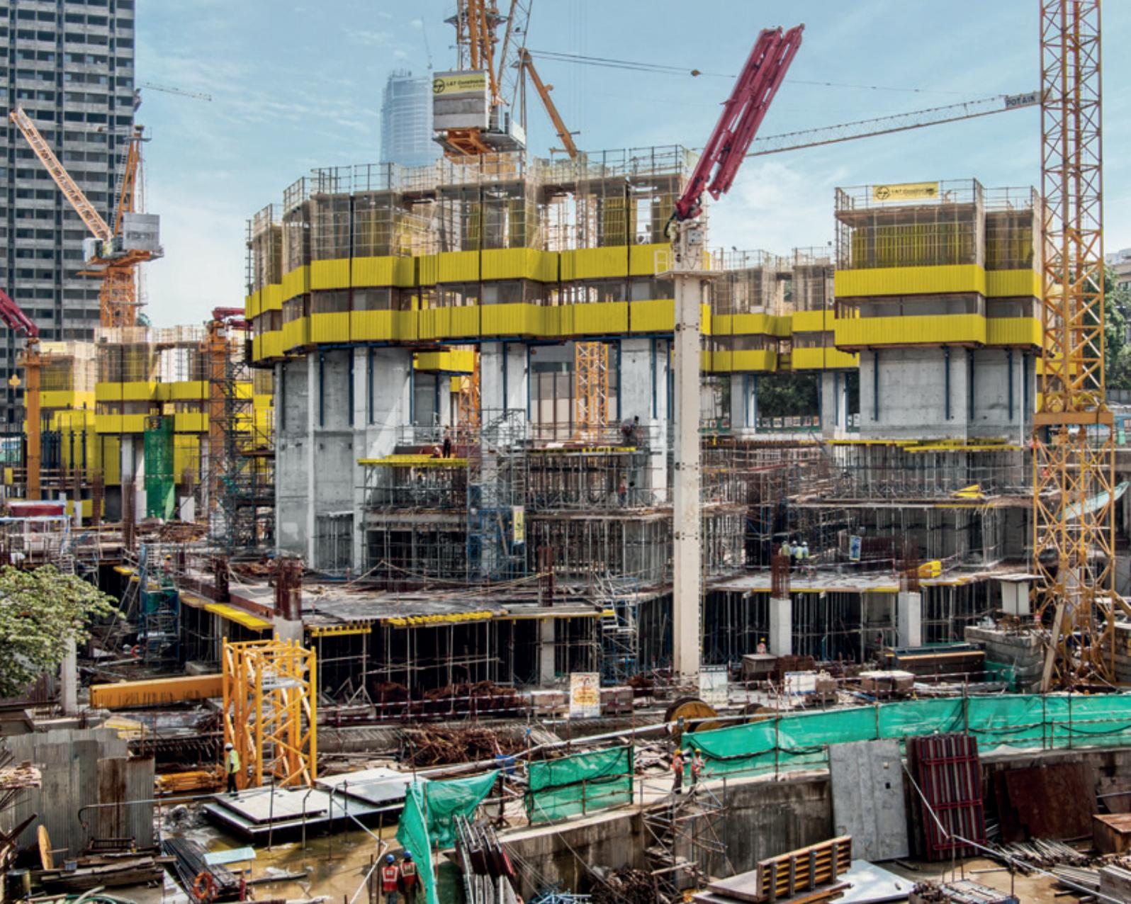
▲ 墙模板 Top 50 经过完美设计，可以匹配建筑物的混凝土形状设计。
