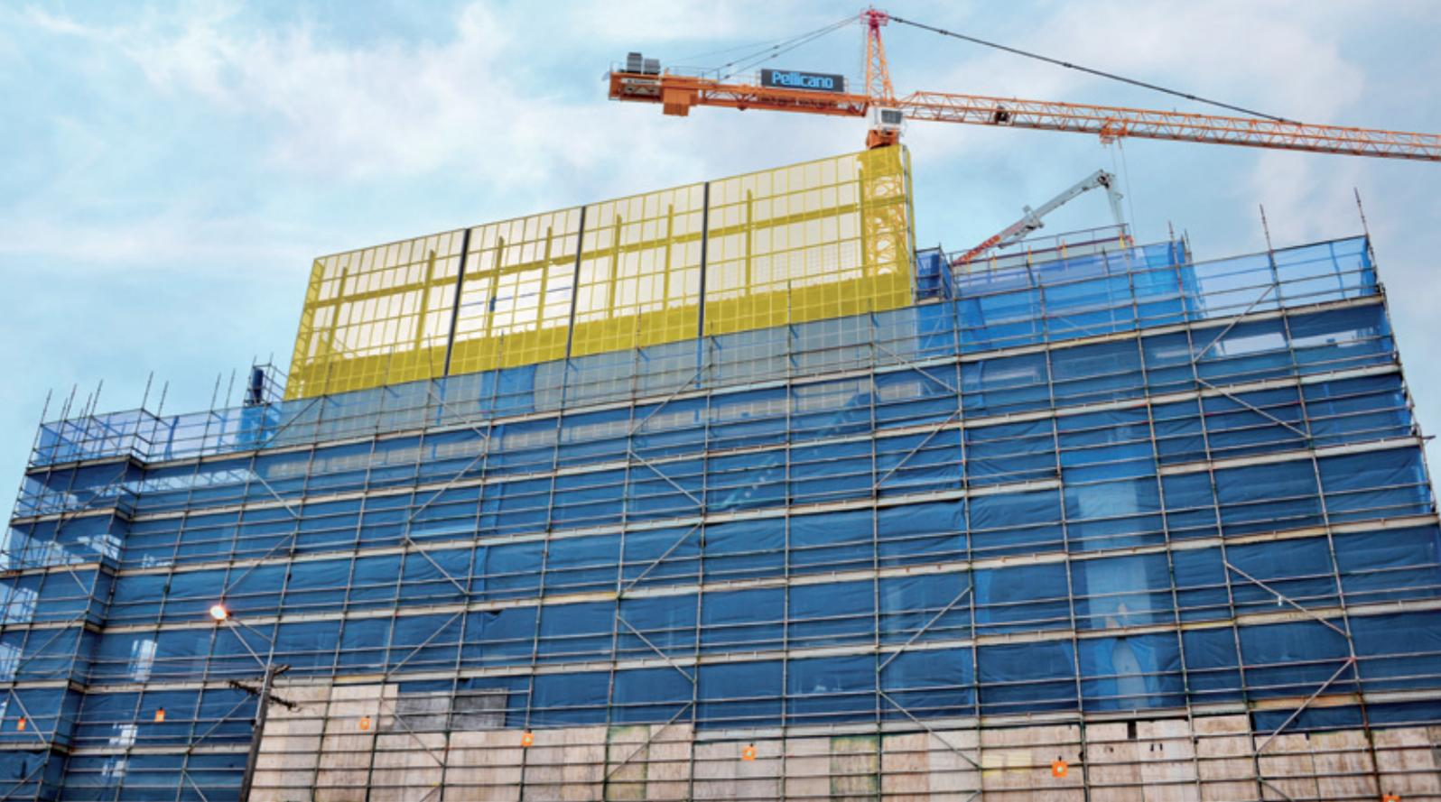
▲ 黄色框架面板，以及将这些连在一起的简单方法，可以实现快速的现场组装。
