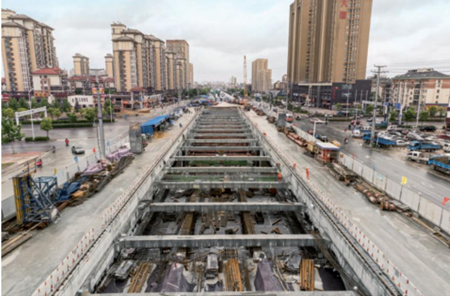
◀ 施工采用明挖回填法。
