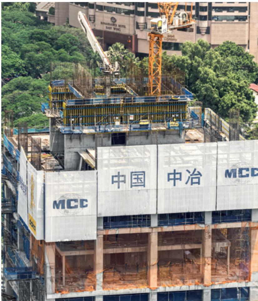
合适的模板解决方案。MCC Overseas 被说服并决定为非标准层高选择一套组合 Dokamatic 台模和 Dokaflex 1-2-4 以及支撑塔架 Staxo 40 的解决方案。为了实现该高层建筑核心筒墙快速且一致的爬升，多卡建议采用塔吊辅助爬升模板 MF240 和井筒平台组合大面积模板 Top 50。大楼结构的建筑按计划进行。除了超过 6 米的非常规层高外，多数浇筑层高不超过 3.8 米。而非常规层高处采用双周期浇筑法。
