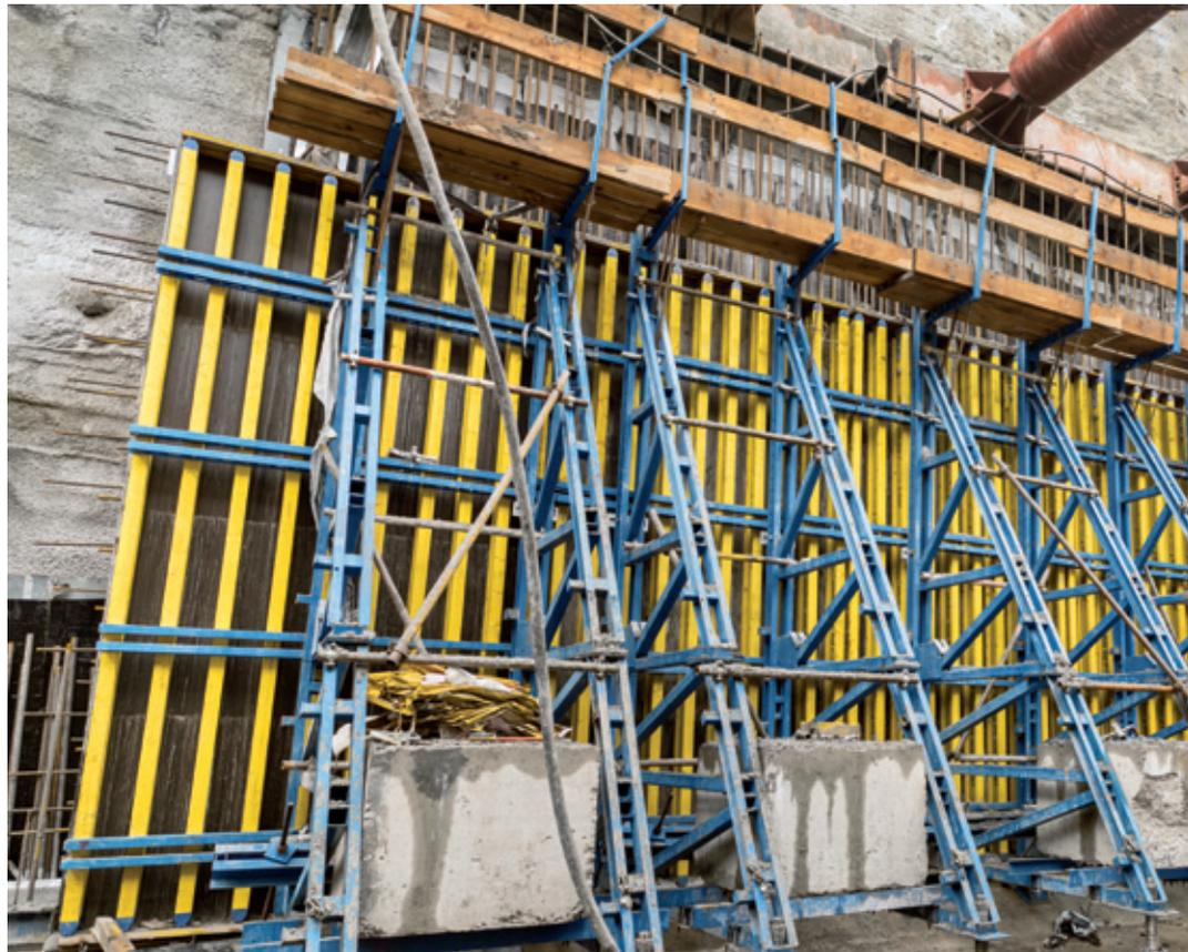
► “支撑结构框架”在不可能通过混凝土对拉墙模构件的情况下可借由斜拉埋件安全转移浇筑力。
