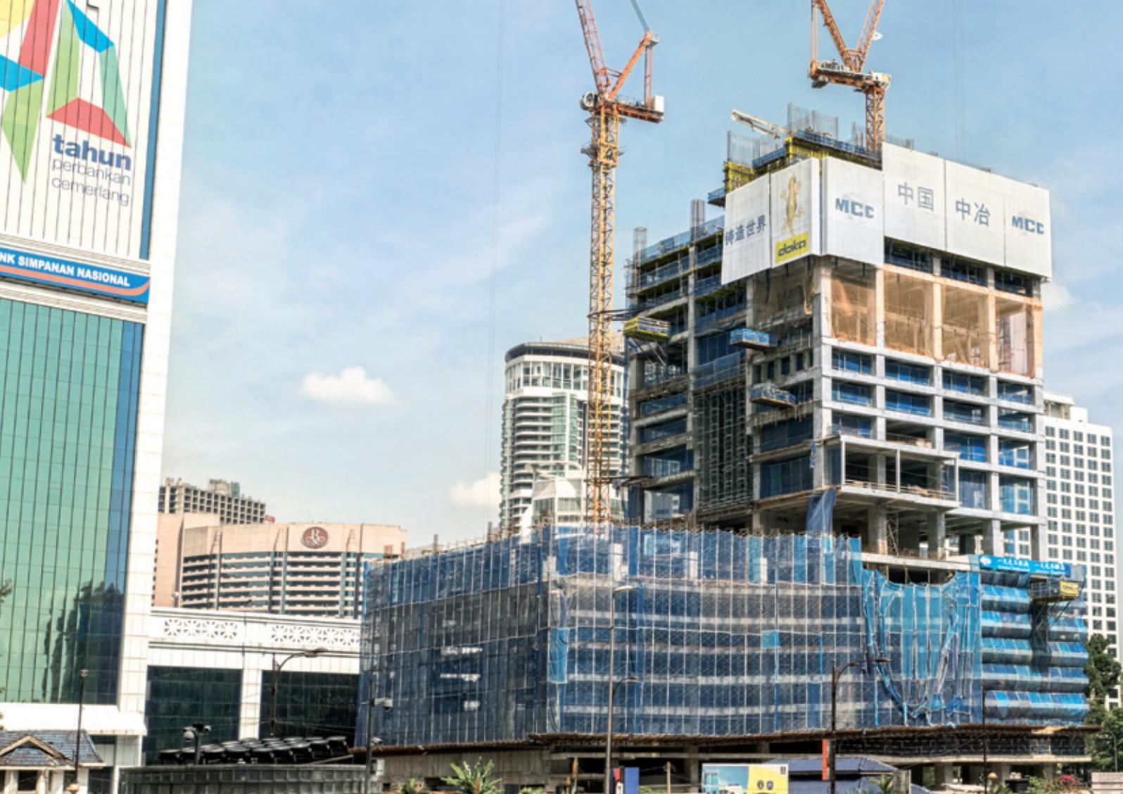
▲ 多卡爬升、楼板和墙模系统让项目施工迅速。
