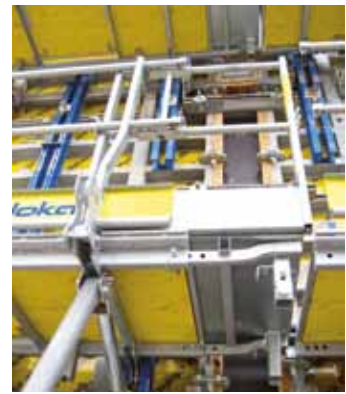
▲ Wysoka zdolność adaptacyjna do każdej geometrii deskowania, dzięki teleskopowym przedłużeniom pomostów Xsafe plus.
