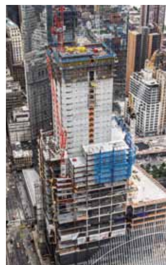
▲ Całość deskowania obejmująca pełne piętro budynku jest podnoszona bez konieczności użycia dźwigu.
