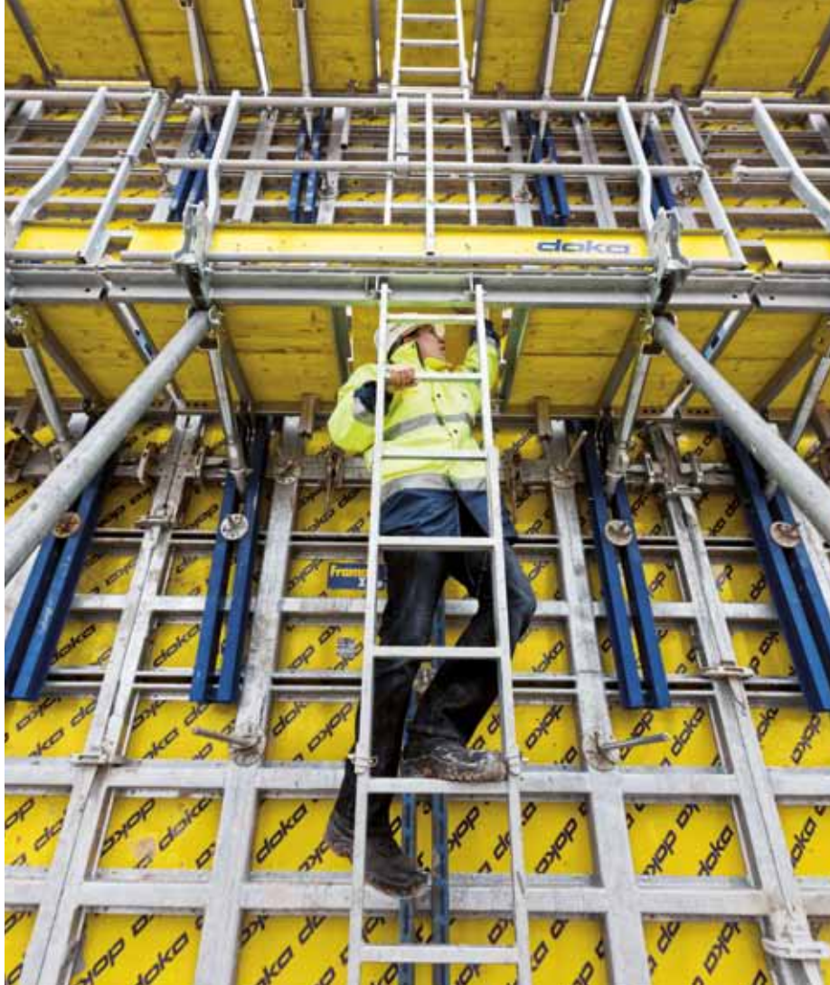
▲ Fot. 2 Najwyższy poziom bezpieczeństwa dla pracy wykonywanej na wysokości, dzięki platformie betoniariskiej Xsafe plus.
