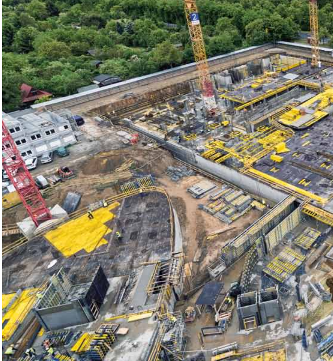
▲ Plac budowy – Budynki 5, 6 i 7
