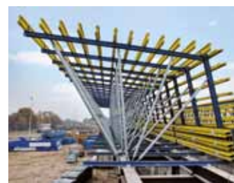
▲ Stanowisko wytwórni – deskowanie od strony zewnętrznej.
