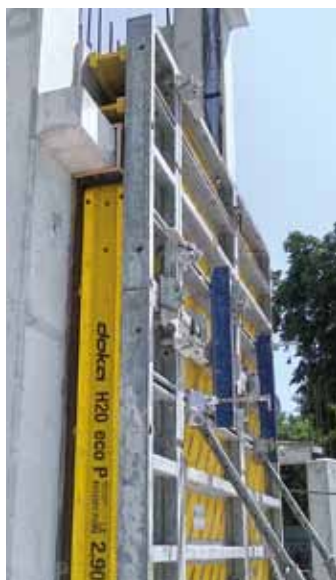
▲ Przykład deskowania ściany ze wspornikiem przy budynkach 6 i 7
