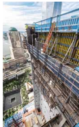
▲ Pomosty robocze gwarantują bezpieczne warunki pracy na wszystkich wysokościach
