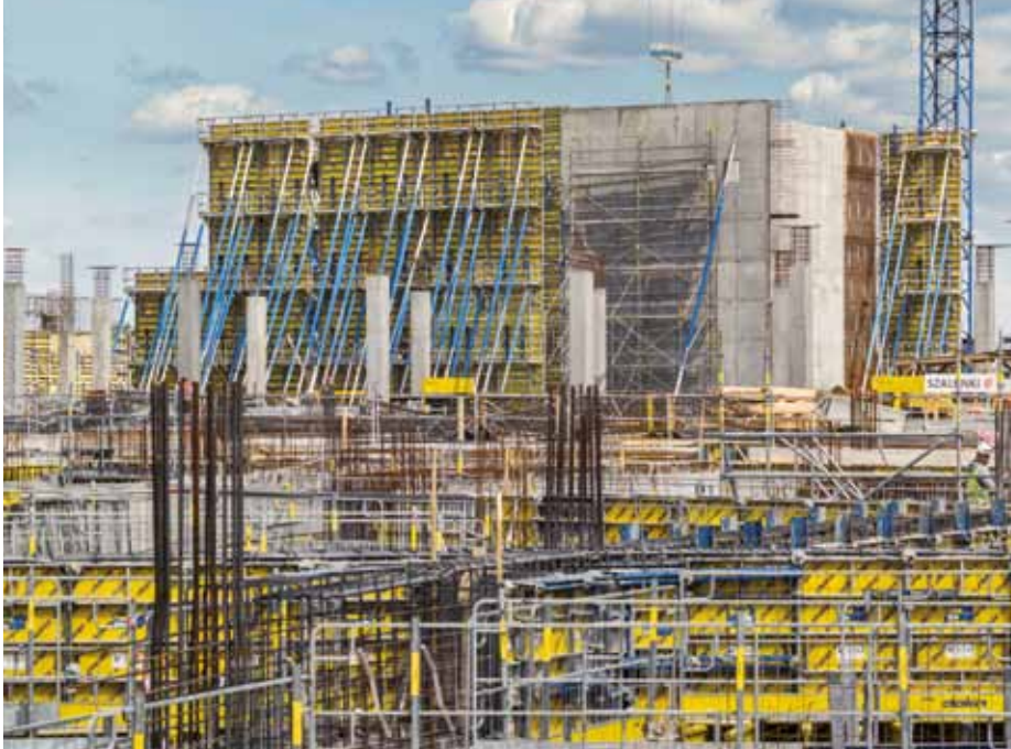
▲ Żelbetowe ściany kin o wysokości 13,5m
