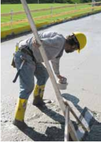
▲ Czujniki stropowe instalowane w świeżym betonie po wyrównaniu jego powierzchni; automatyczne rozpoczęcie pomiaru.
