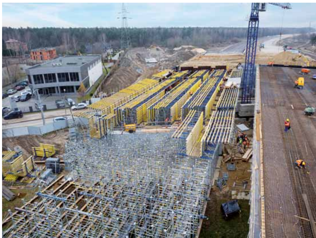
▲ Deskowanie ustrojów nośnych w systemie dźwigarowo-ryglowym Top 50.
