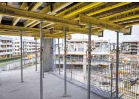
▲ Zoptymalizowane deskowanie stropu kondygnacji powtarzalnej w systemie Dokaflex 20
