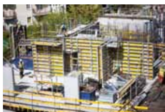
▲ System pomostów betoniarskich Xsafe plus.
