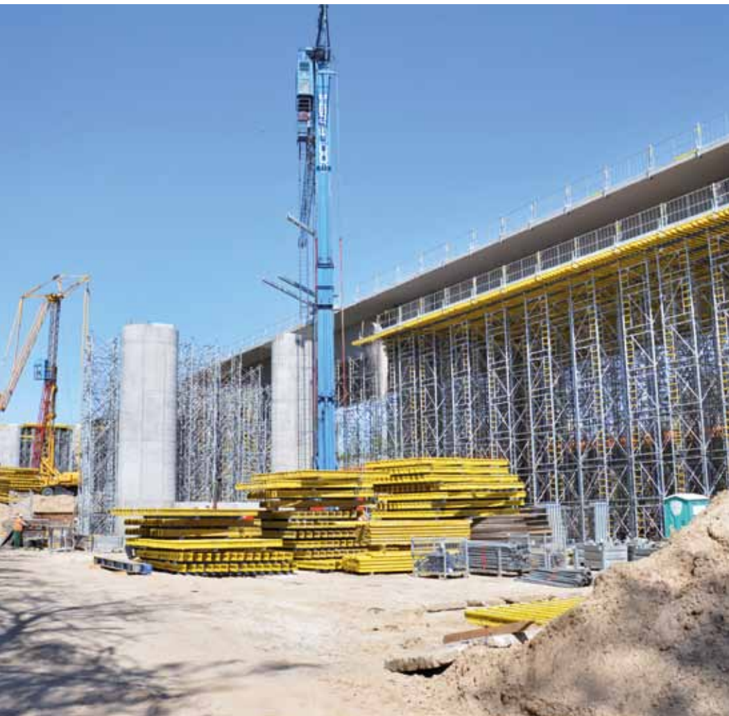
▲ Obiekt MS-7 w ciągu drogi ekspresowej S7 na odcinku Miłomłyn-Ostróda
