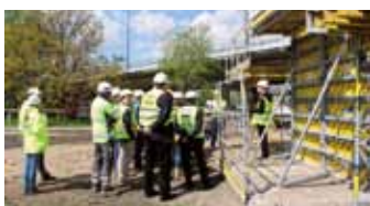
▲ Szkolenie montażowe systemów bezpieczeństwa Doka na budowie
