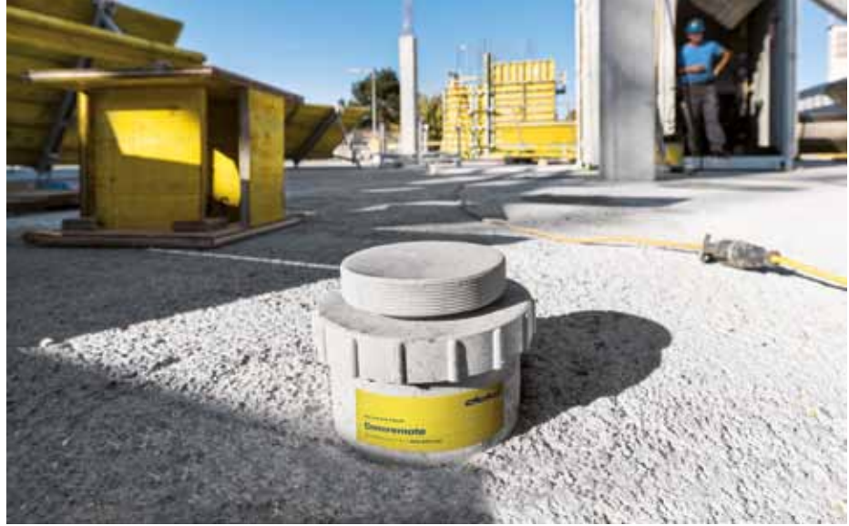
▲ System Concremate określa optymalny termin rozdeskowania i w ten sposób znacznie zwiększa produktywność.
