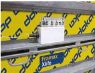
▲ Czujnik kablowy Concremate zamontowany bezpośrednio w deskowaniu ramowym Framax Xlife.
