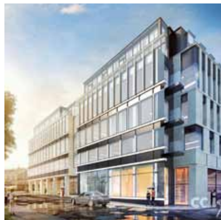
Fot. CDI Konsultanci Budowlani Sp. z o.o.
