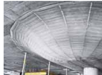
▲ Do poszycia deskowania ramowego Framax Xlife przytwierdzone są różne elementy, które następnie są pokrywane środkiem antyadhezyjnym, a po rozdeskowaniu usuwane.
