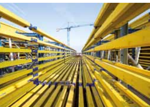
▲ Deskowanie ustrojów nośnych w systemie dźwigarowo-ryglowym Top 50.
