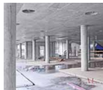
▲ Framax Xlife i Dokaflex zapewniają najwyższą jakość struktury betonu
