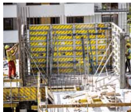
▲ Otwarcie ściany klatki schodowej w systemie Framax Xlife
