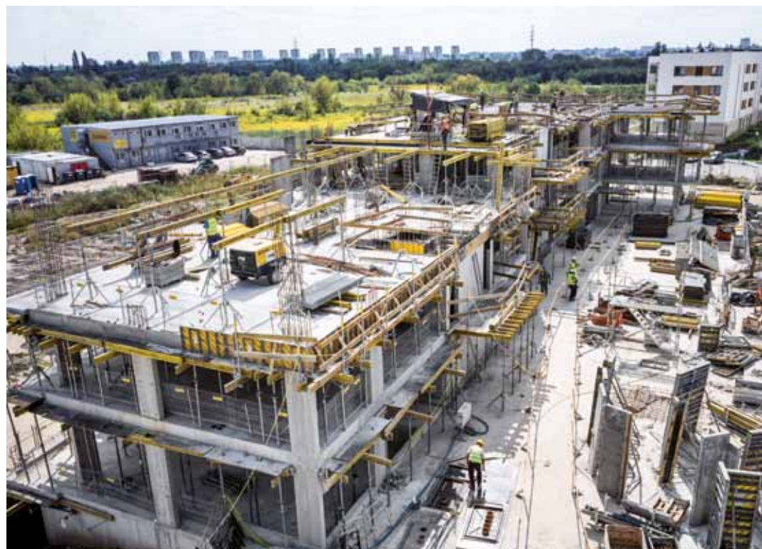
▲ Zoptymalizowane deskowanie stropu kondygnacji powtarzalnej w systemie Dokaflex 20
