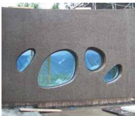
▲ Le béton architectonique de couleur brune et les fenêtres aux formes personnalisées confèrent au bâtiment son caractère unique.
