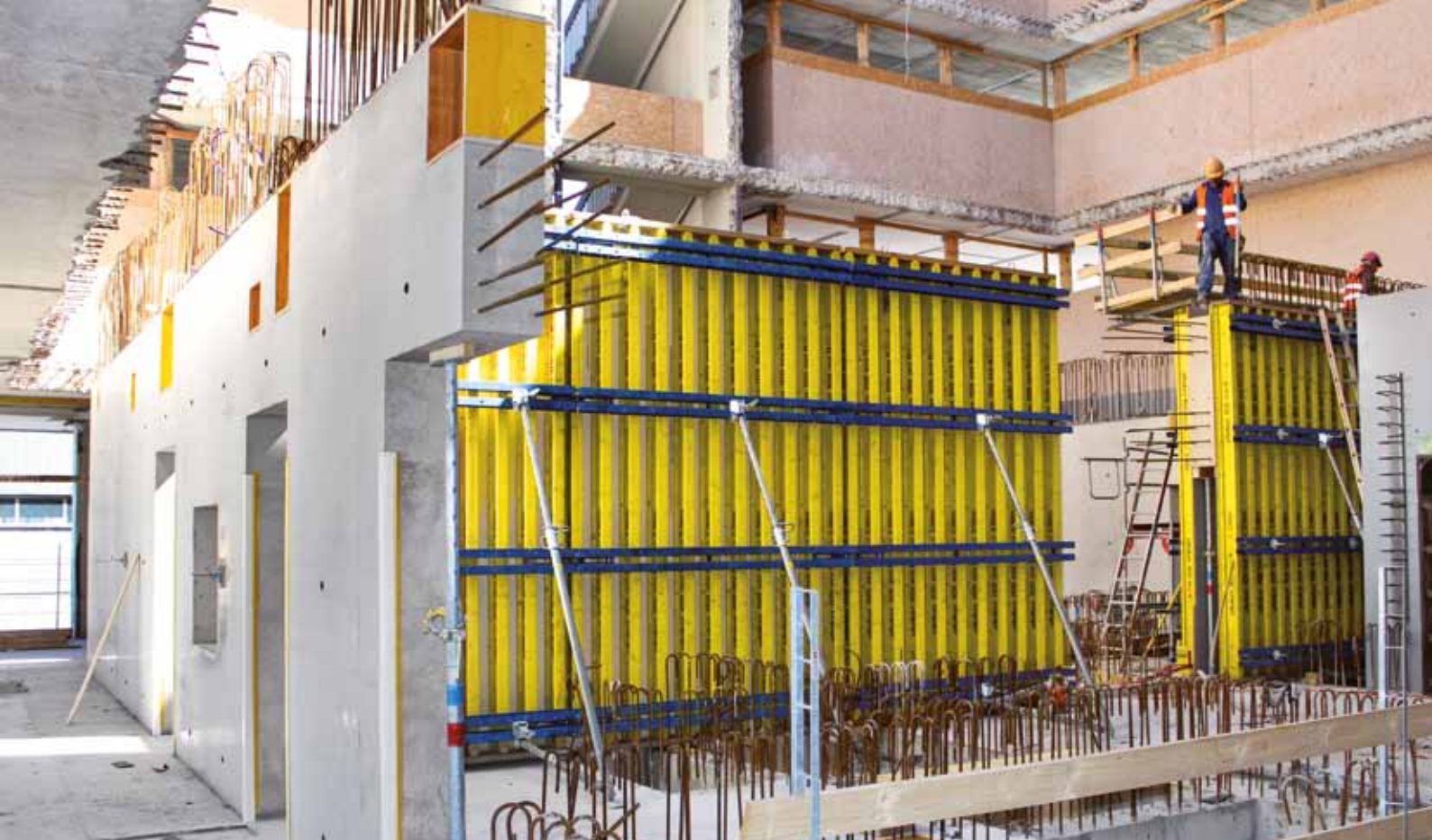
▲ Béton architectural parfait – et dans le futur, également dans le noyau du bâtiment existant.
