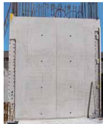
▲ Voile de béton architectural une fois terminée.
