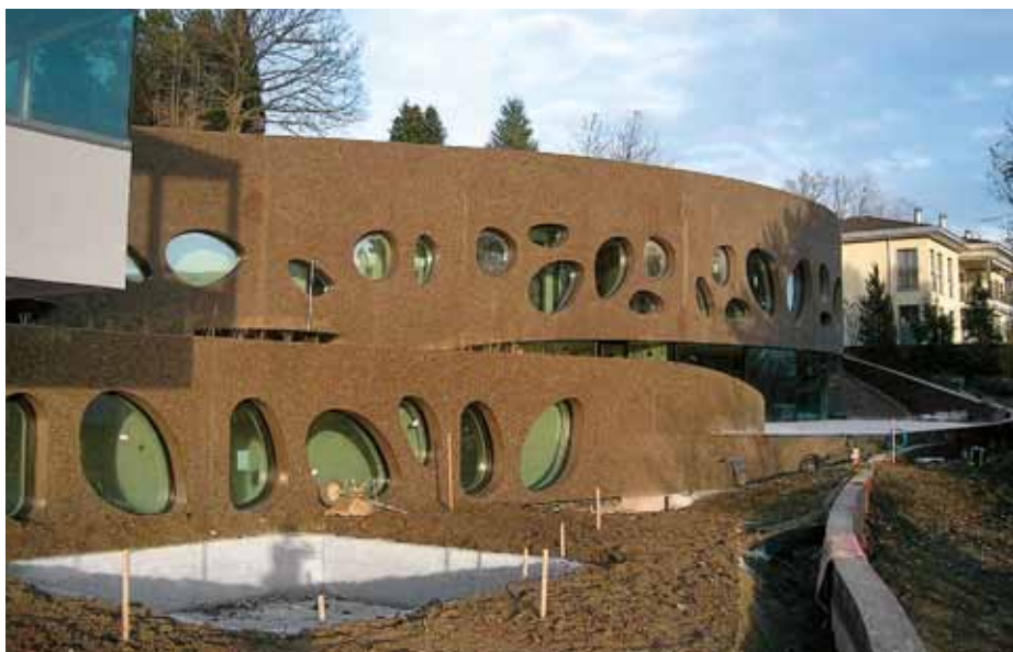
▲ Coffrage spécial avec différents rayons changeants, parfaitement étudié, réalisé par Doka Schweiz.
