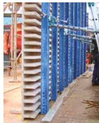
▲ Coffrage spécial avec différents rayons changeants, parfaitement étudié, réalisé par Doka Schweiz.
