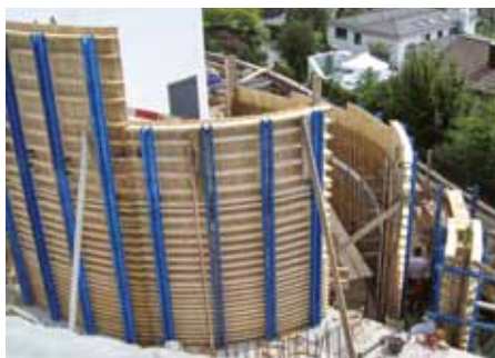
▲ Coffrage spécial avec des courbures tout en rondeur et des planches en guise de peau coffrante.
