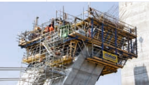
▲ 16 Kletterabschnitte à 2,10 m mit Selbstkletterschalung SKE 50
