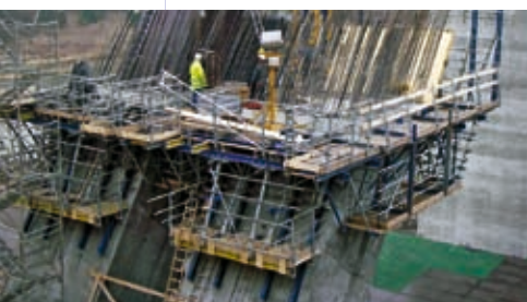
▲ Pfeiler mit einer Neigung von 33° aus der Senkrechten
