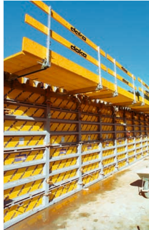
▲ Kranabhängige Rahmenschalungen wie Framax Xlife eignen sich gut für den Einsatz fließfähiger Betone.
