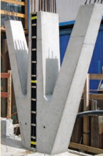
▲ W-Stütze mit Sonderschalung aus dem Doka-Fertigservice.
