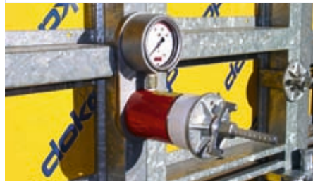
▲ Baustellenversuche mit Druckmessdosen zeigten einen erheblichen Einfluss der Betoneinbringung auf den Frischbetondruck.
