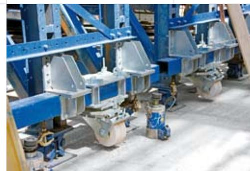
▲ Neu entwickelte Schwerlasträder machen kranloses Rollen leicht.
