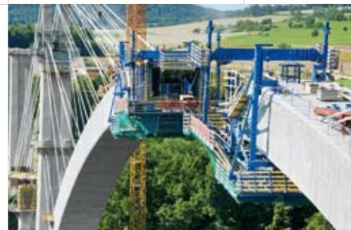
▼ Die um 40 cm teleskopierbare Innenschalung ist eine Rahmenkonstruktion aus Trägerschalung Top 50 und SL-1-Systemträgern mit hoch belastbaren Spindelstreben.
