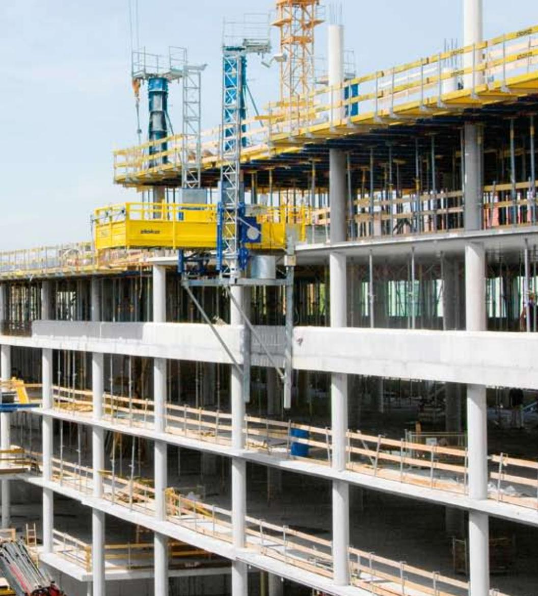
◀ Vier Doka-Tischhubsysteme TLS ermöglichen beim Großprojekt Rivergate extrem kurze Umsetzzeiten für die Dokamatic-Tische.
