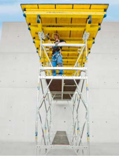
▲ Doka Load-bearing tower Staxo 40의 독창적인 H-형 프레임 기하구조는 장애 없는 자유로운 작업공간을 제공한다.
