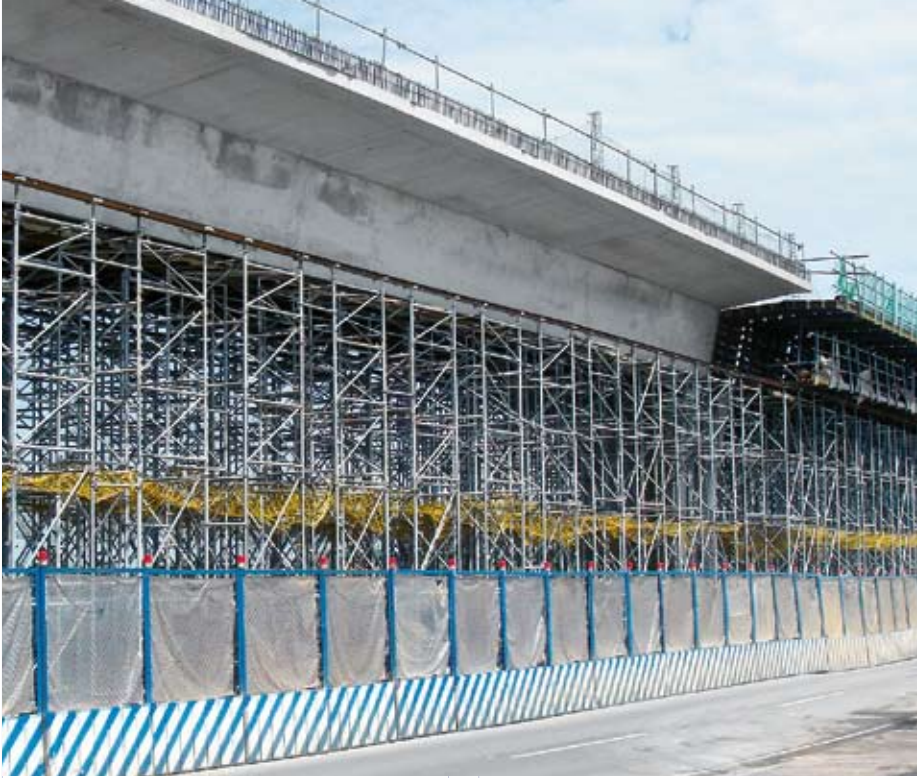
◀ 상부 구조 지지를 위하여 기 입증된 Load-Bearing (하중 지지) 타워 d2가 사용되었는데 이는 높은 하중이 걸리고 여분의 안정성이 요구되는 경우에는 언제나라도 완벽한 소령 시스템이다.
