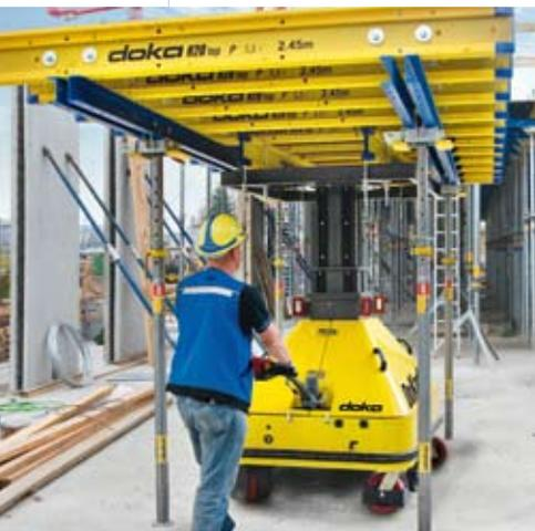
Mit zwei Innovationen beschleunigt Doka das Umsetzen von Deckentischen nochmals, bei erhöhter Sicherheit und völlig unabhängig vom Baustellenkran.
