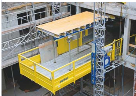
▲ Das Tischhubsystem TLS steht zunächst in Bodenaufstellung im Atrium und klettert anschließend mit dem Baufortschritt hoch.
