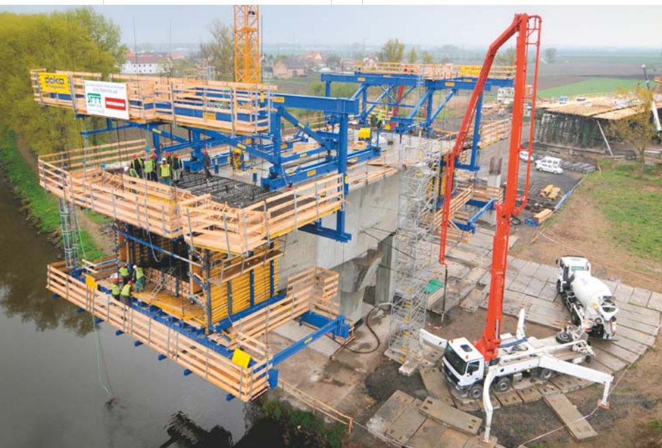
▲ Doka-Freivorbauwagen und Schwing-Betonpumpe bei der gevouteten Hohlkastenbrücke über die Elbe bei Litomerice, Tschechien
