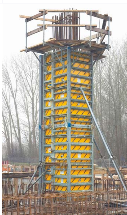
▲ Stützenquerschnitt 1,20 m x 1,00 m geschalt mit Uni-Elementen 1,20m und 0,90m, kombiniert mit Zusatzelement.
