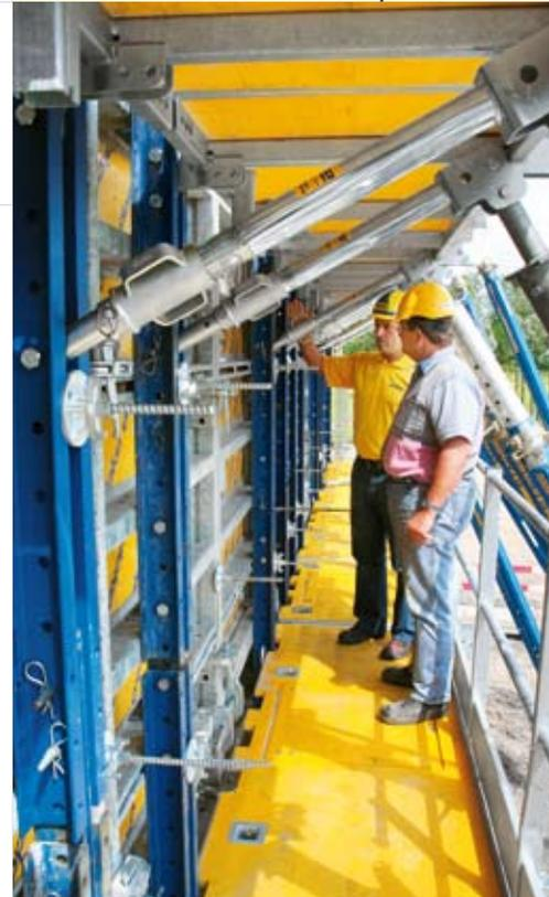
▲ Sicher schalen – mit dem Bühnensystem Xsafe Plus.
