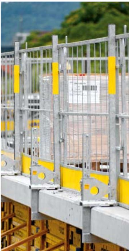
Bei der Errichtung des mehrgeschossigen Wohn- und Geschäftsgebäudes Augarten Nord in Graz werden die Deckenränder mit dem neuen Doka-Seitenschutzsystem XP abgesichert.
