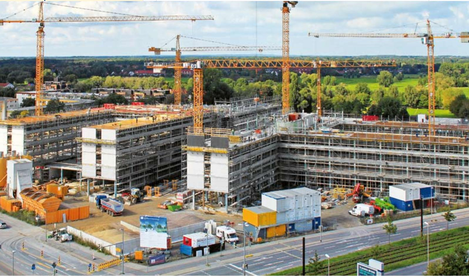
▲ Der dreiflügelige Neubau der HDI-Gerling-Zentrale mit Tiefgarage, Atrium und insgesamt acht fünfgeschossigen Büroflügeln entsteht ausschließlich mit Doka-Schalung.
