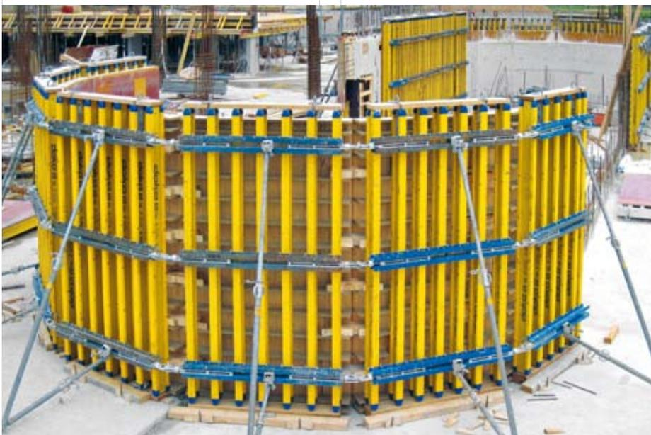
◀ Maßgeschneiderte Trägerschalung Top 50 für die hohen Sichtbetonanforderungen in den aufgehenden Etagen.
