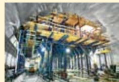
ゴッタルド基底トンネル
