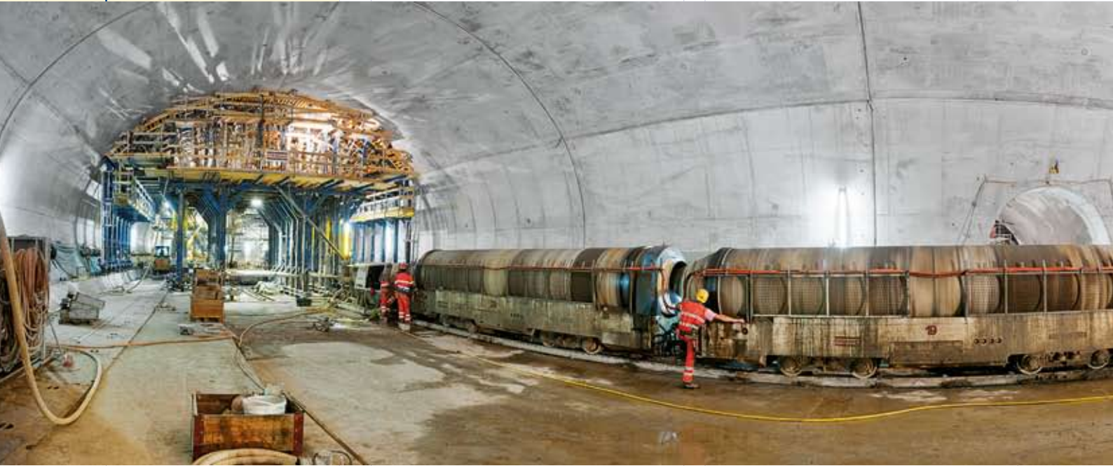
▲ 고타르 베이스 터널의 Erstfeld 구간 Y지관 2중 구조물을 시공하는데 고성능의 완전 유압식 Doka 터널 거 푸집 운반대차가 사용되고 있다.
