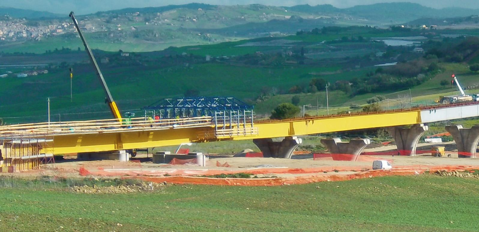
▲ Costituito da 15 campate per una lunghezza di 780 m, il viadotto Pellegrino viene realizzato con un carro Doka a sezione variabile
