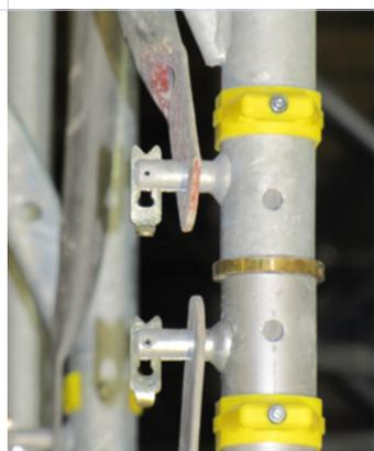
▲ Innesto telaio e arresto di sicurezza
