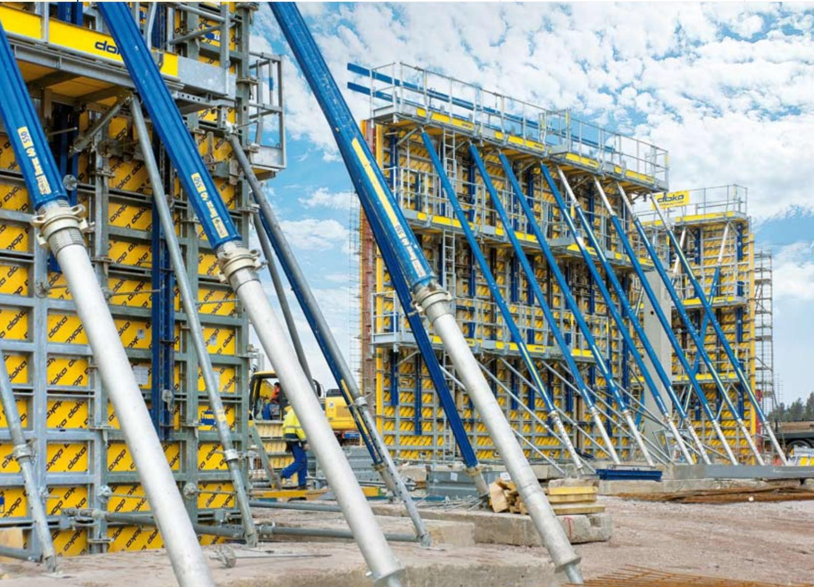
▲ Die an der Rückseite der Bühnen angeschlossenen Elementstützen sorgen für freie Arbeitswege in allen Ebenen.
