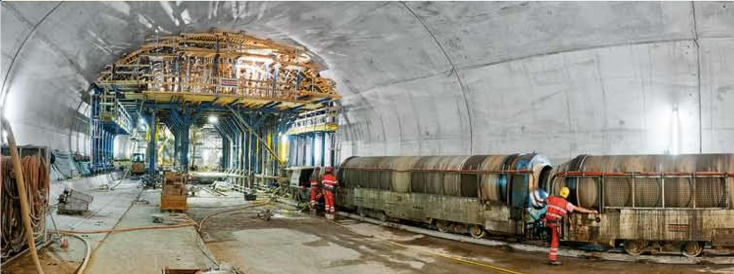
▲ **Starke Leistung:** Der flexibel anpassbare Tunnelschalwagen besteht aus mietbaren Systemkomponenten.
