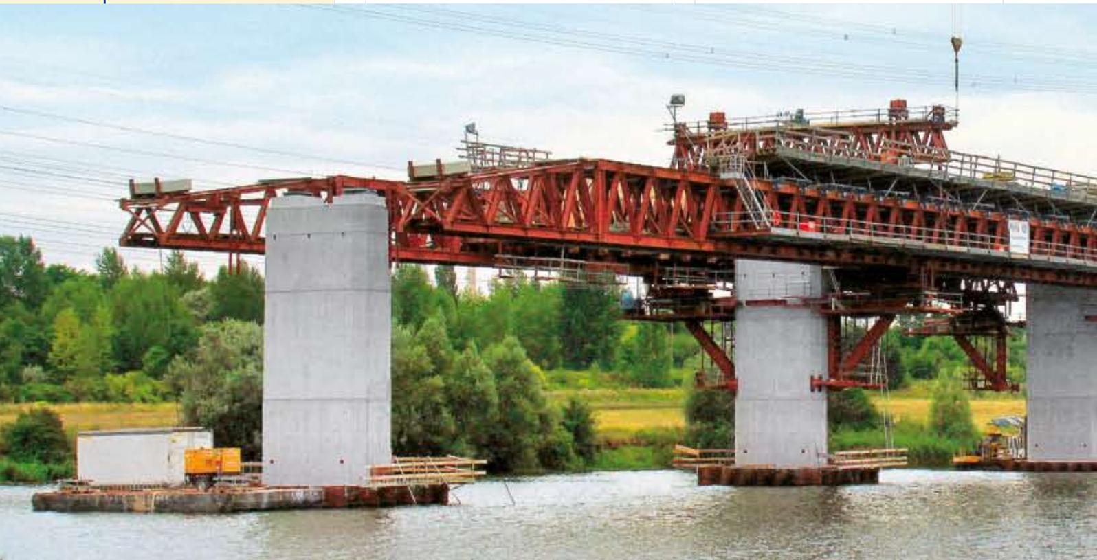
▲ Beim Bau der 8,6 km langen Saale-Elster-Talbrücke dienen Vorschubgerüste zur Überquerung mehrerer Natur- und Vogelschutzgebiete.
