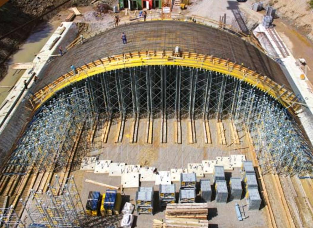
◀ Das Bogentragwerk wurde mit Traggerüst Staxo 100 sicher unterstellt.
