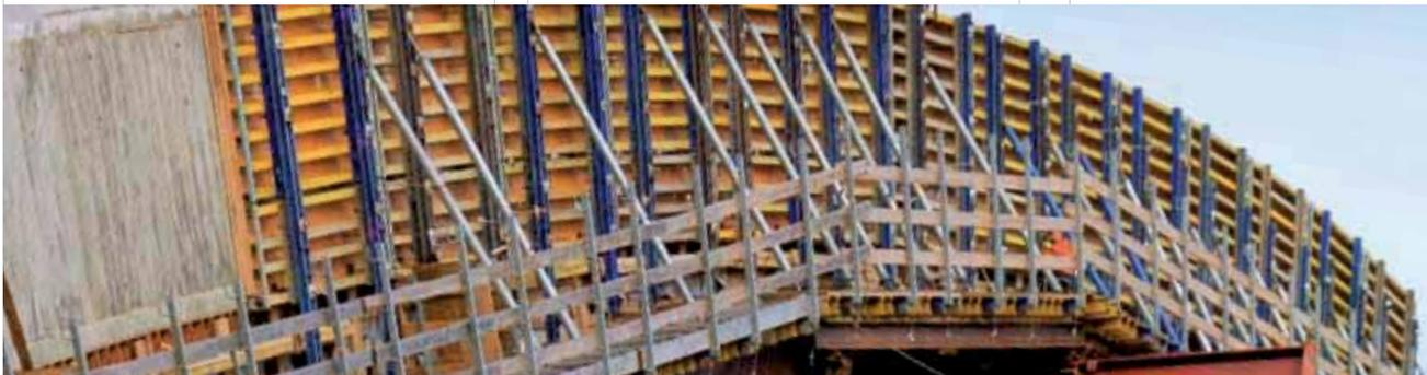
Der weit gespannte Stahlbetonbogen der Massetalbrücke im Thüringer Wald entsteht mit zwei Sätzen Mietschalung auf bodengestütztem Traggerüst. Sein Hohlquerschnitt verjüngt sich zum Bogenscheitel hin. Hier ist das Traggerüst rund 70 m hoch. Längsträger unterstützen die Bogenschalung zwischen den Lasttürmen.
