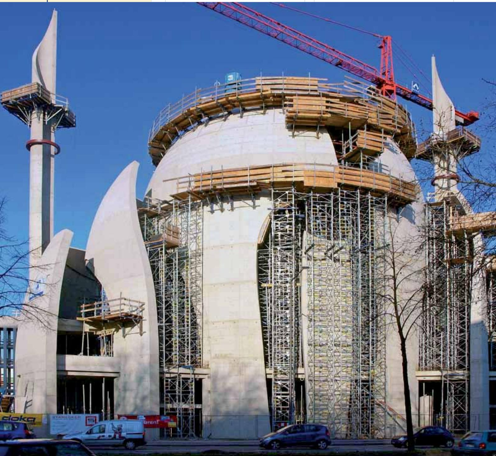
▲ Mehr als 2.000 m<sup>2</sup> gewölbte Sonderschalungen hat der Doka-Fertigservice vormontiert.
