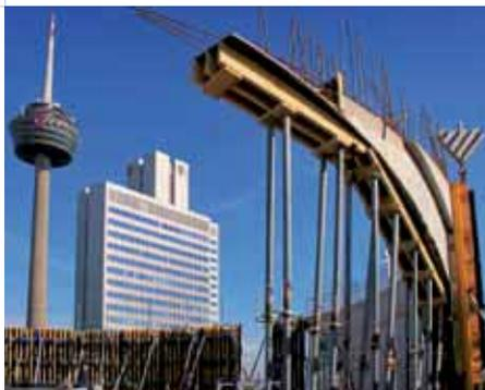
der Trägerschalung Top 50. Zur Unterstellung der bis zu 1,20 m starken Bauteile dient das besonders hoch belastbare Traggerüst Staxo 100.
