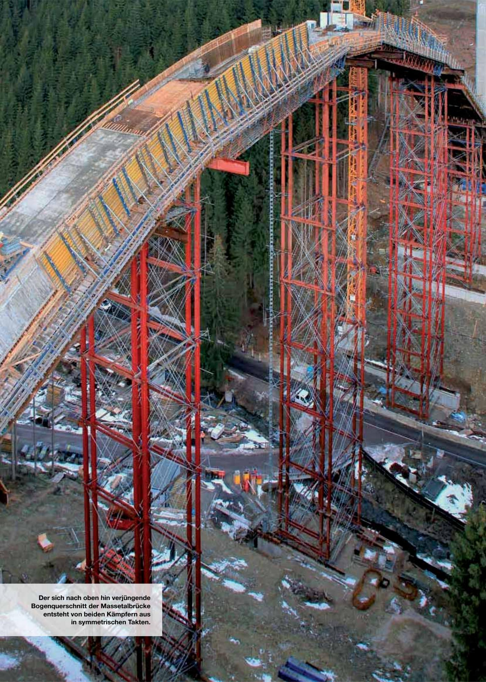
Der sich nach oben hin verjüngende Bogenquerschnitt der Massetalbrücke entsteht von beiden Kämpfern aus in symmetrischen Takten.
