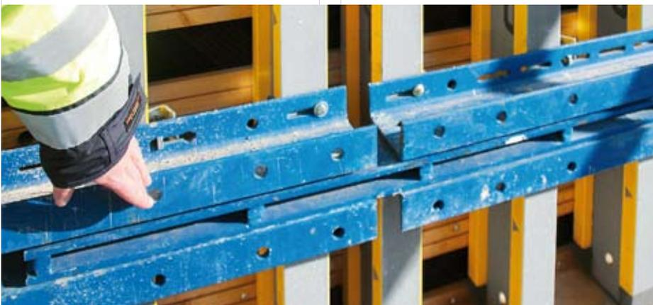
◀ Top 100 tec-Ausgleichslaschen dienen dazu, die vertikalen Fugen im 2,27 m-Raster zuverlässig einzustellen.
