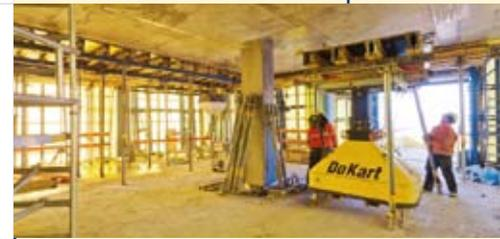
▲ „Karibik-Feeling“ bei jedem Wetter und in jeder Höhe durch das mietbare Schutzschild, belegt mit lichtdurchlässigen und winddichten gelben Polycarbonatstegplatten.
