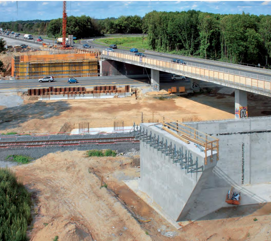
◀ Sobald die erste Brücke im Zuge der A57 fertig ist, wird der Verkehr umgeleitet. Rechts daneben, an Stelle der alten Brücke, entsteht dann die zweite neue Brücke.
