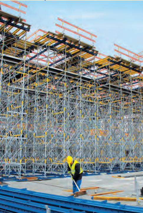
▲ 7.500 m<sup>3</sup> Staxo 40, präzise aufgebaut und verschwert durch das Doka-Team der Schalungsvormontage.
