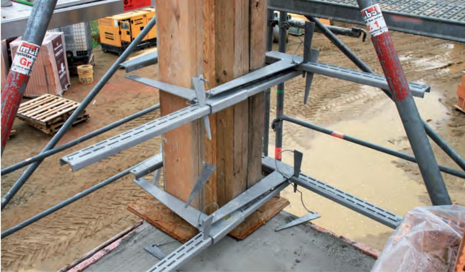
◀ „Ankerung“ einer Stützenschalung mit Schalzwingen.
