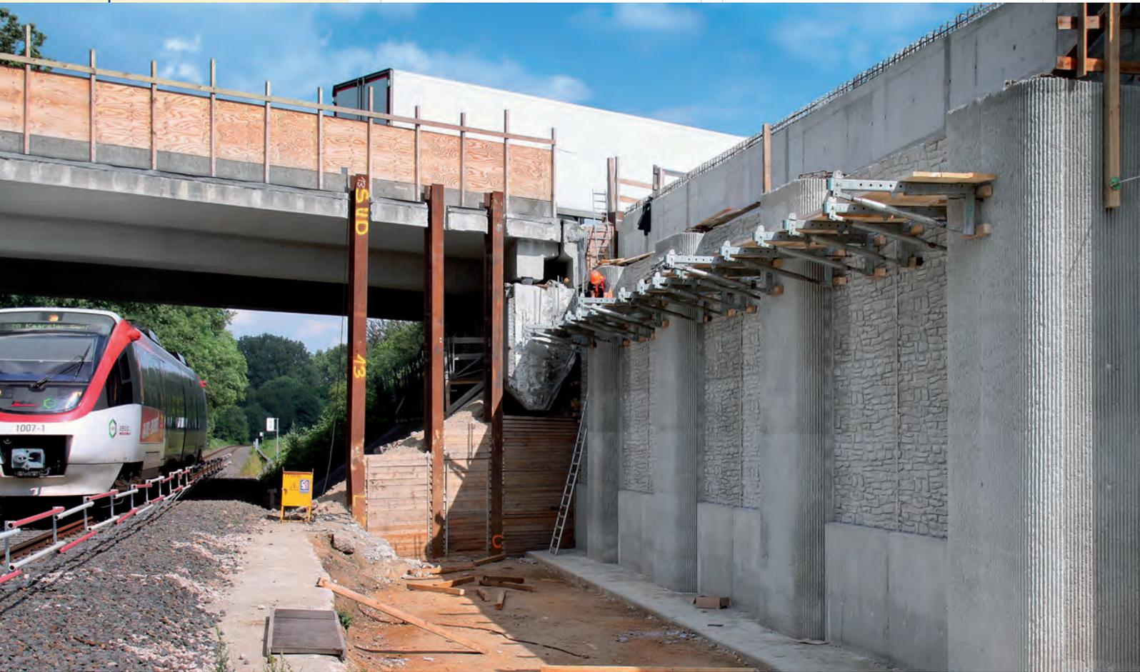
▲ Pfeilervorlagen, Absätze sowie Vor- und Rücksprünge kennzeichnen dieses komplizierte Widerlager in Sichtbeton.
