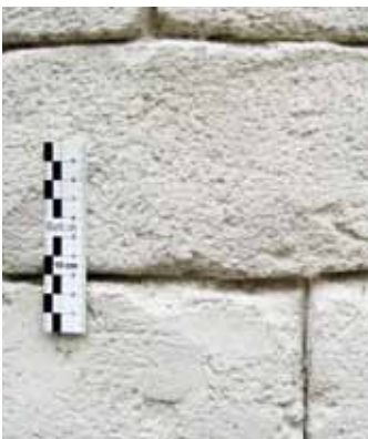
▲ Vom ersten bis zum letzten Einsatz kommt die extravagante Struktur bei den Trogwänden in Ortbeton bestens heraus.
