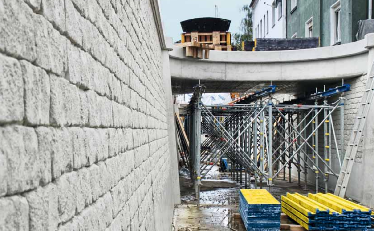
▲ Sichtbetonwände in Steinstruktur und glatt geschalte geschwungene Brücken beim Deininghauser Bach, Castrop-Rauxel.
