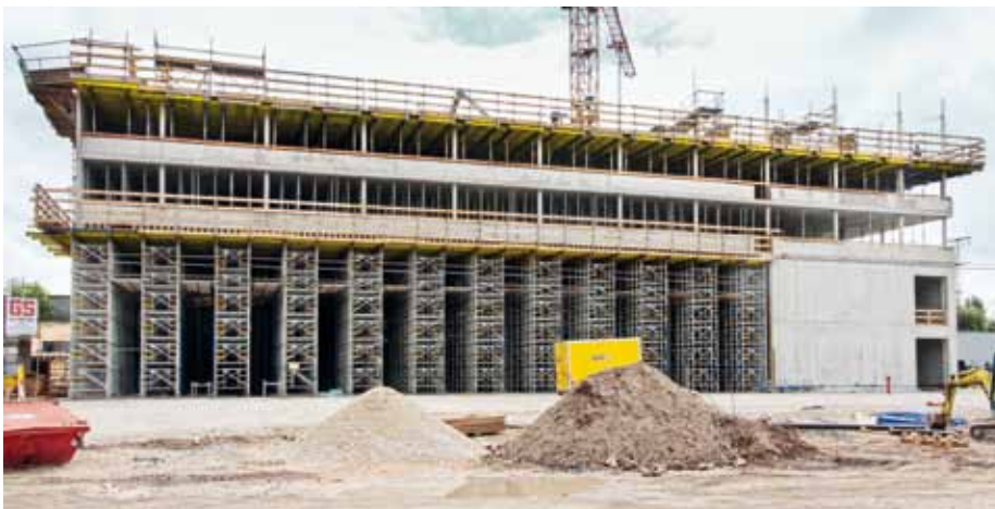
▲ Die massive Unterstellung der Anfahrtzone und Foyer prägt die Schalungslösung des Büroneubaus.
