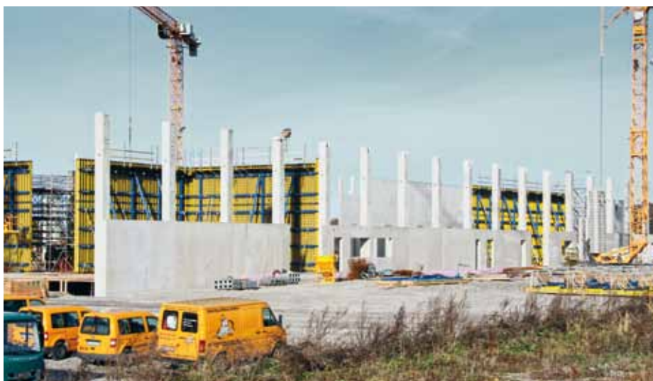
▲ Mit einer Vorhaltung von 2.000 m 2 Trägerschalung Top 100 tec werden alle Sichtbetonwände der Zwischenbauten von vier Produktionshallen betoniert.
