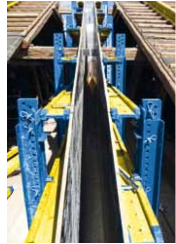
▲ Trägerschalung Top 50 liefert die exakte Form für einen ungewöhnlichen Sichtbeton beim Bauen im Bestand.
