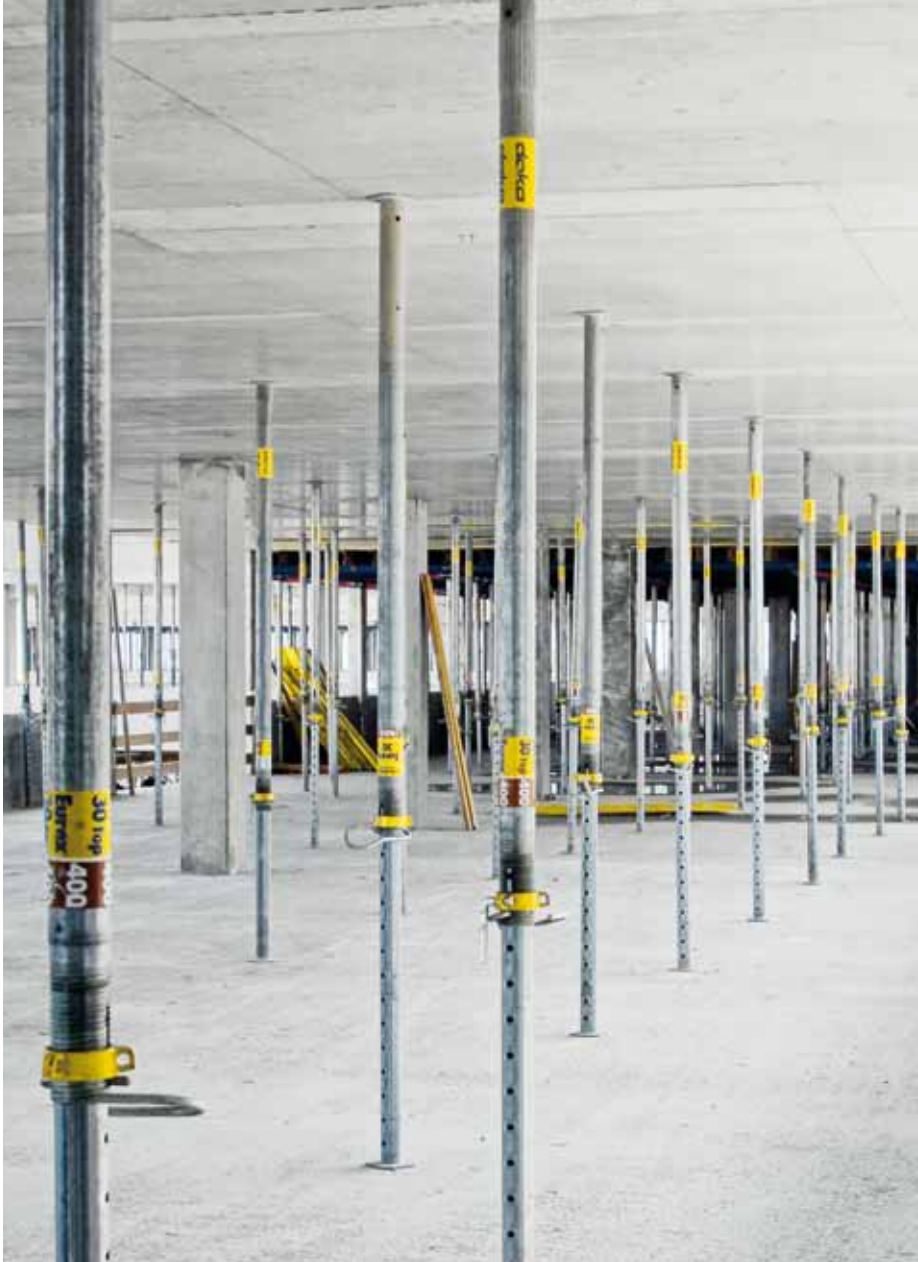
▲ Die Decken mit Plattenraster 2,50 x 1,00 m erhalten im Ausbau lediglich eine Spachtelung von max. 5 mm Dicke.
