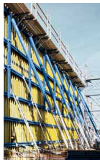
▲ Betonierabschnitte bis zu 24 m Länge bei 7,75 m Betonierhöhe.
