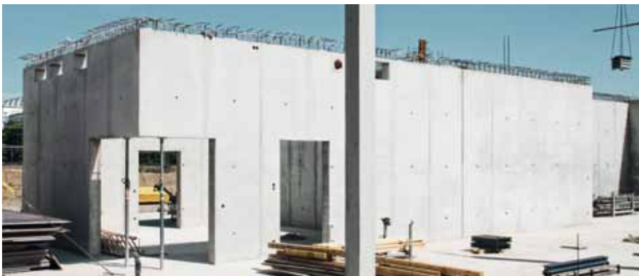
▲ Hier auf der Baustelle in Hannover stimmt alles: Schalung, Trennmittel, Beton und Bauausführung. Das Resultat: glatter Sichtbeton in Perfektion.
