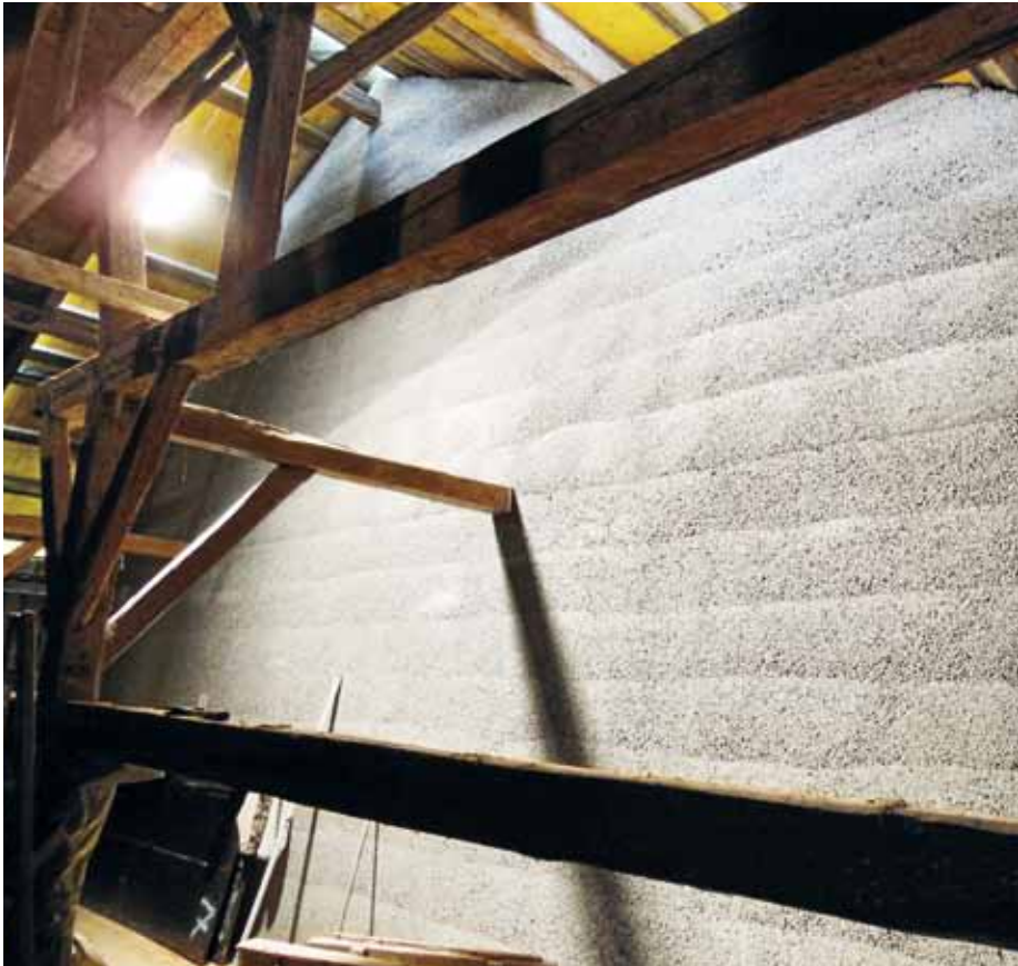
▲ Stampfbeton als Sichtfläche für architektonisch ansprechende Wohnungstrennwände innerhalb eines bestehenden Gebäudes in Tüntenhäusern.
