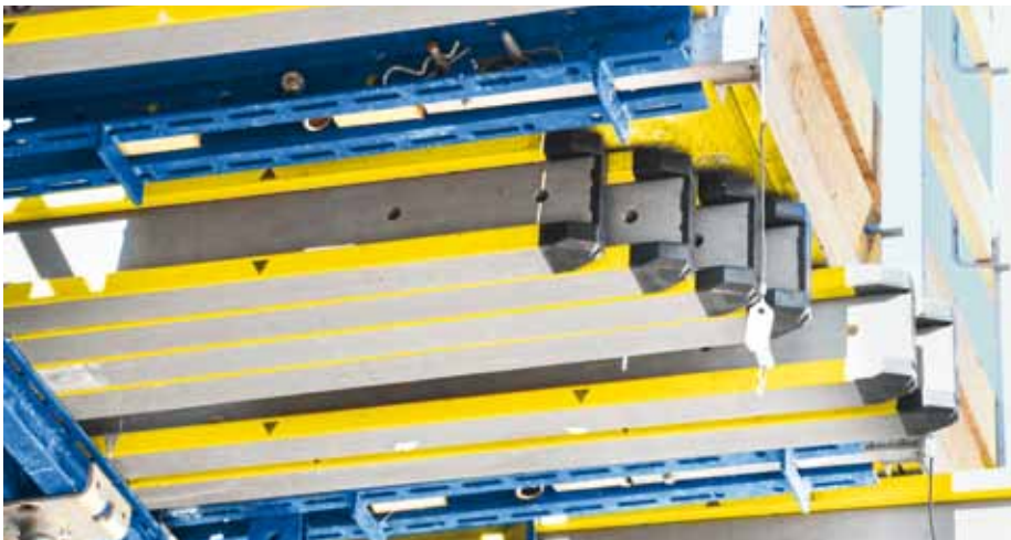
▲ In einigen Deckenschalungsbereichen liegen sogar die hoch belastbaren Verbundschalungsträger I tec 20 dicht an dicht.
