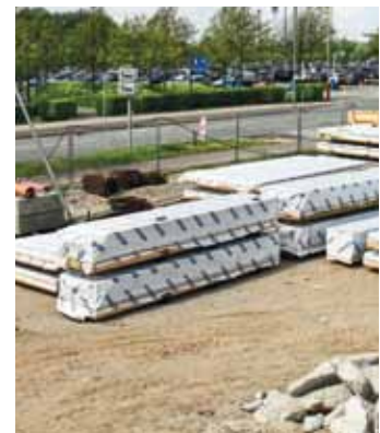
▲ Atmungsaktive Tyvek-Gewebebefolien schützen die Top 50-Elemente bei Transport und Lagerung vor ihrem ersten Einsatz.
