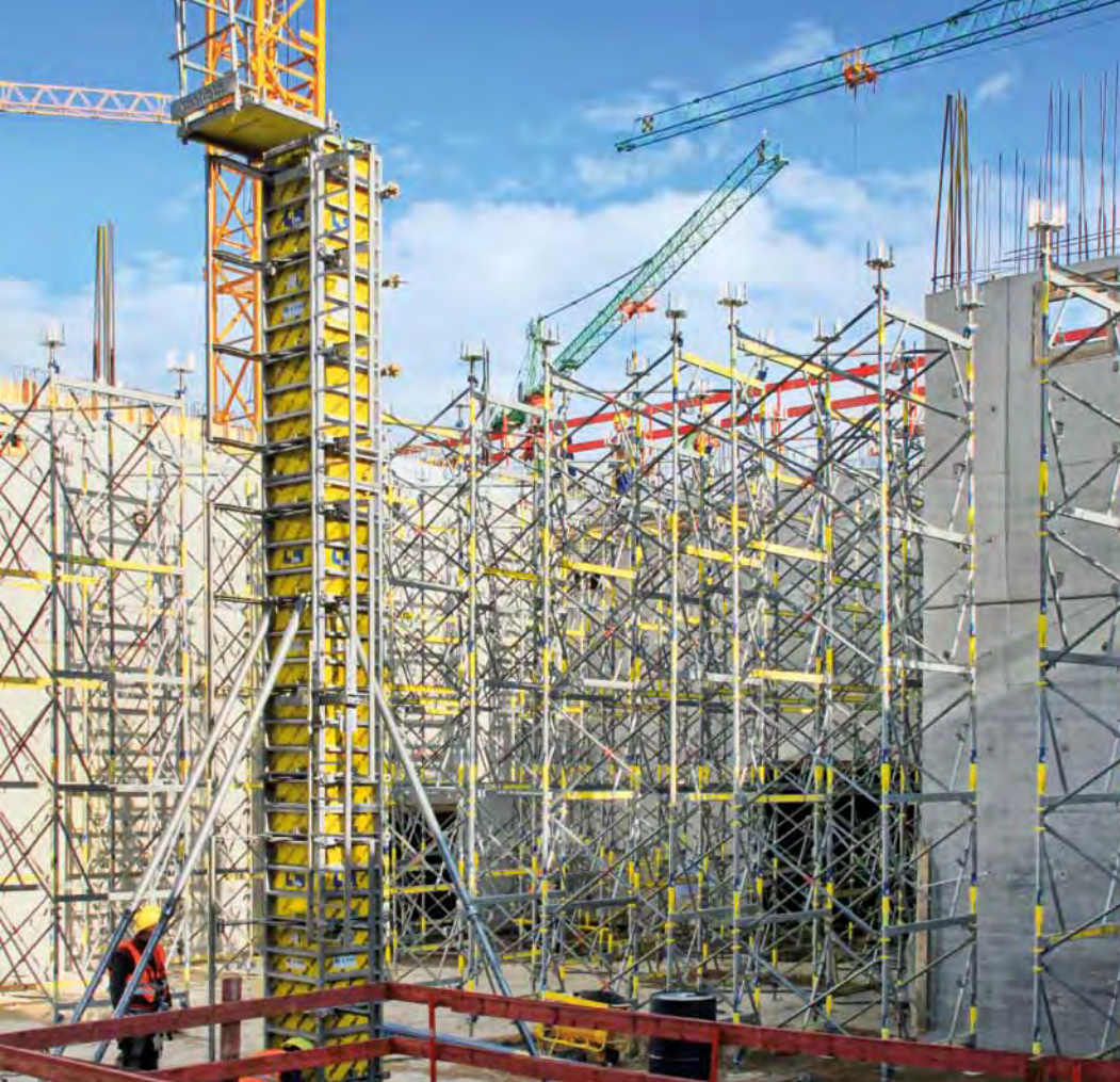
▲ In der künftigen Prüfhalle sind das Traggerüst Staxo 40 und die Stützenschalung KS auf 8,00 m Höhe ausgelegt.
