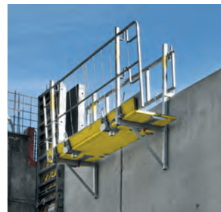
▲ Aus Hohlwand-Konsolen 60 und Konsolenbelag oder Bohlen vormontierte Bühneneinheiten sind mit dem Kran umsetzbar.
