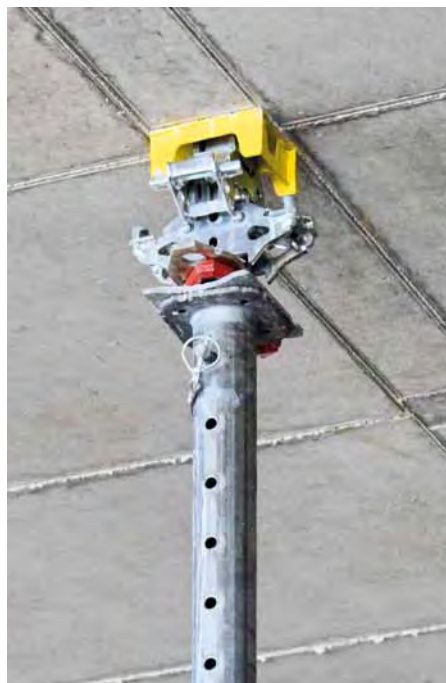
▲ Mit dem XF-Fallkopf wird die Element-Deckenschalung Dokadek 30 zum Frühausschalssystem.
