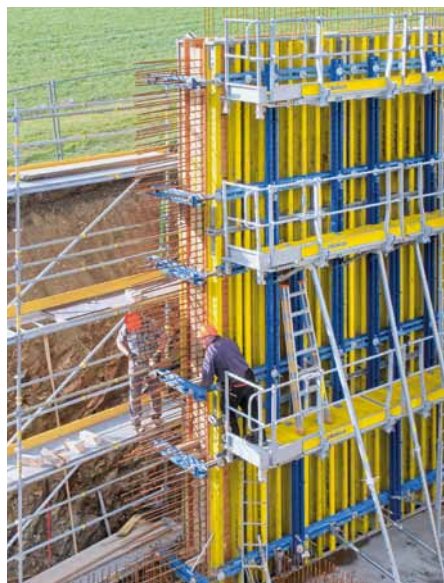
▲ Das Arbeitsgerüst Modul auf der Außenseite (hinten) und das Bühnensystem Xsafe plus ergänzen sich ausgezeichnet.
