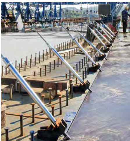
▲ Der innovative Einbauschuh bietet einfache Montage, exakte Höhenanpassung und die komplette Bedienung der Kragarmschalung von oben.
