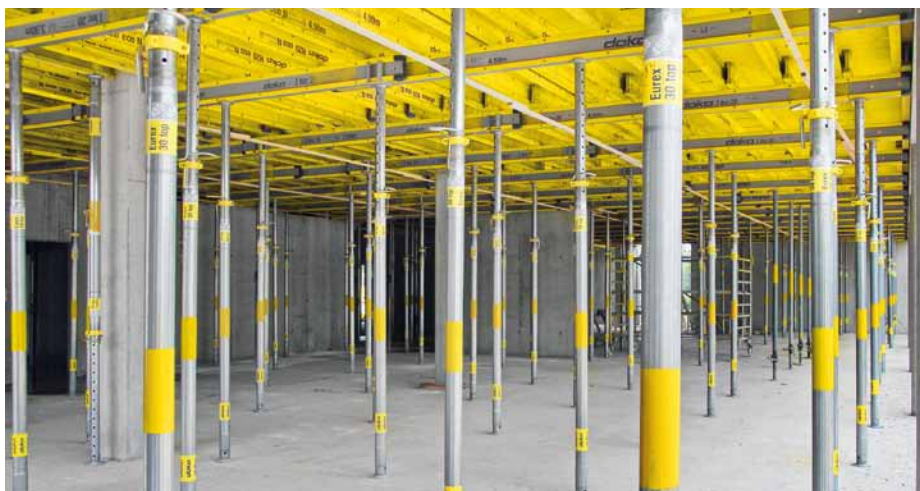
▲ Beim Bau der Grundschule Wassertrüdingen kommen die Vorteile der verringerten Vorhaltemenge voll zum Tragen.
