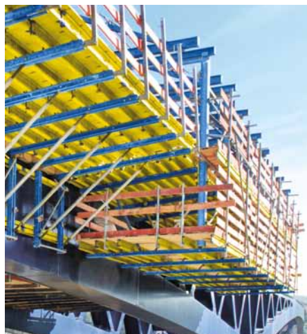
▲ Die Brückenschalung ParaTop und der Doka-Verbundschalwagen bestehen weitestgehend aus mietbaren Systemteilen.
