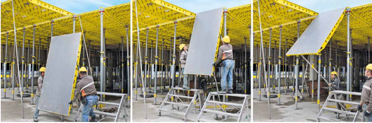
▲ Mit Dokadek 30 erfolgen alle Arbeiten vom sicheren Boden aus. Bei Höhen von hier 4,05 m leistet die Podesttreppe 0,97m gute Dienste.
