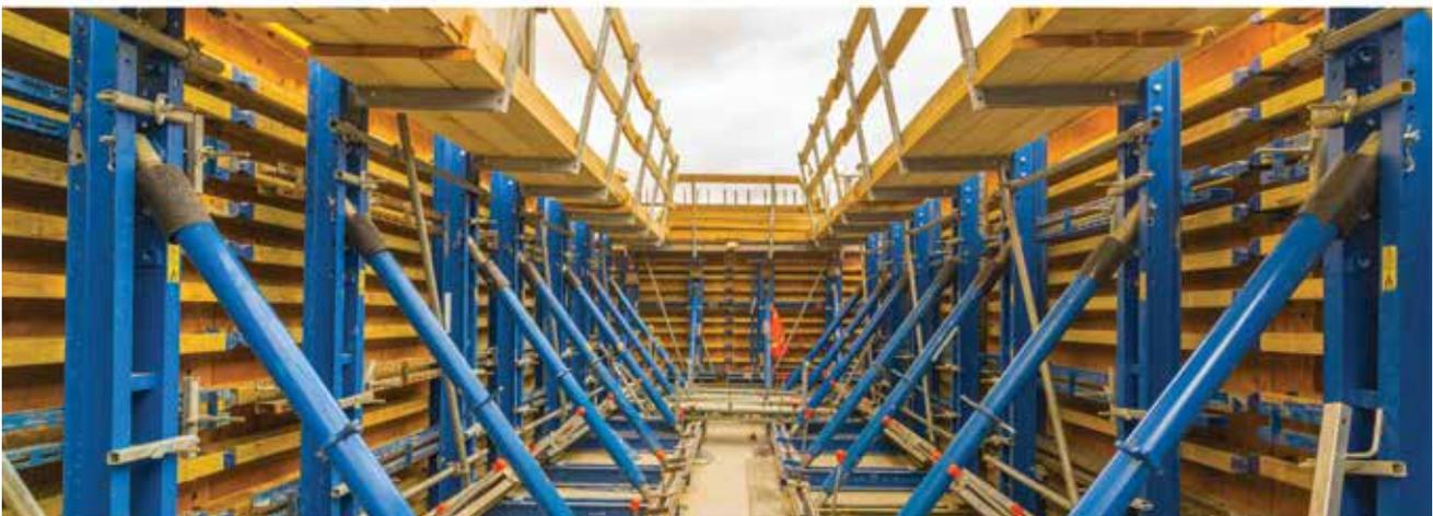
▲ Pilares do vertedouro com fôrmas customizadas.
