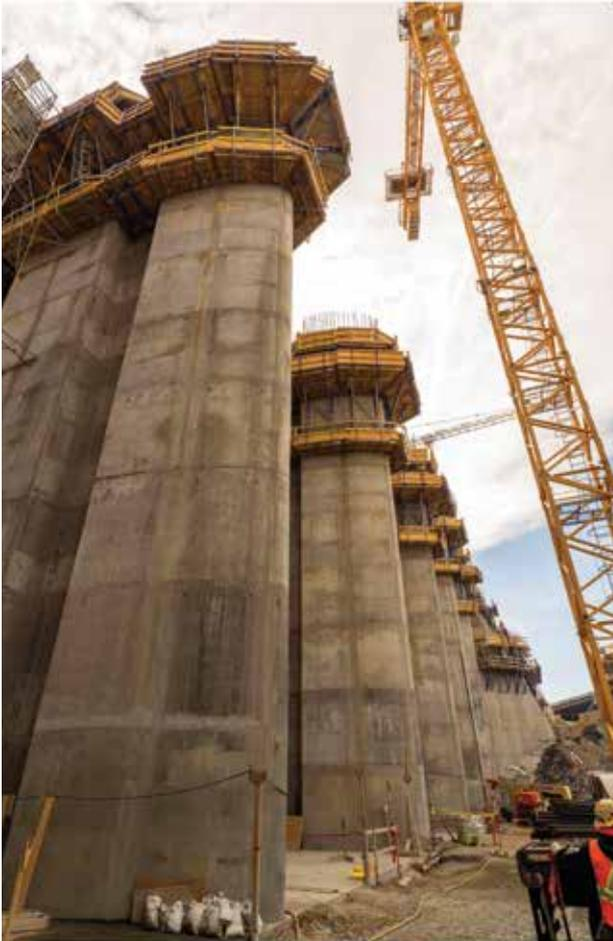
▲ Construção simultânea de seis pilares do vertedouro.
