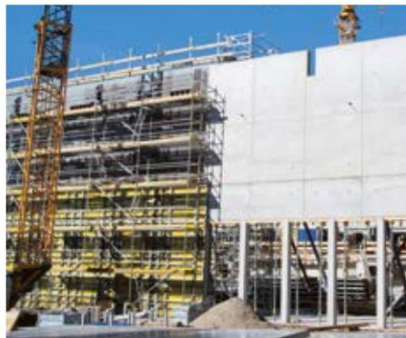
Das Arbeitsgerüst Modul mit seiner praxisgerechten Arbeitsbreite von 73 cm erleichterte den Betonbauern die Arbeit. Vom 12 m hohen Treppenturm 250 aus Staxo 100-Bauteilen war wiederum Polier Frank Hummel besonders begeistert: „Durch die ergonomische Konstruktion fällt uns das Auf- und Absteigen sehr viel leichter. Gleichzeitig gewährleistet er gerade bei hohen Arbeitsstellen volle Sicherheit.“ //
