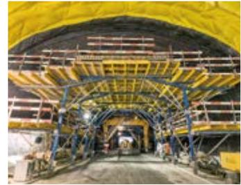
▲ Für den bergmännischen Tunnel bringt Doka einen Bewehrungswagen von 12 m Länge als Sonderkonstruktion zum Einsatz.
