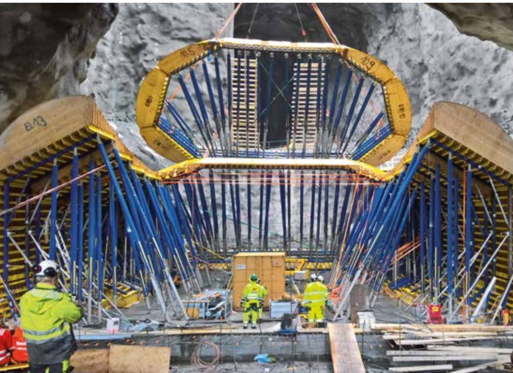
▲ Das ausführende Bauunternehmen ist begeistert von der Passgenauigkeit der Sonderschalung für den Saugschlauch beim Vamma Kraftwerk.
