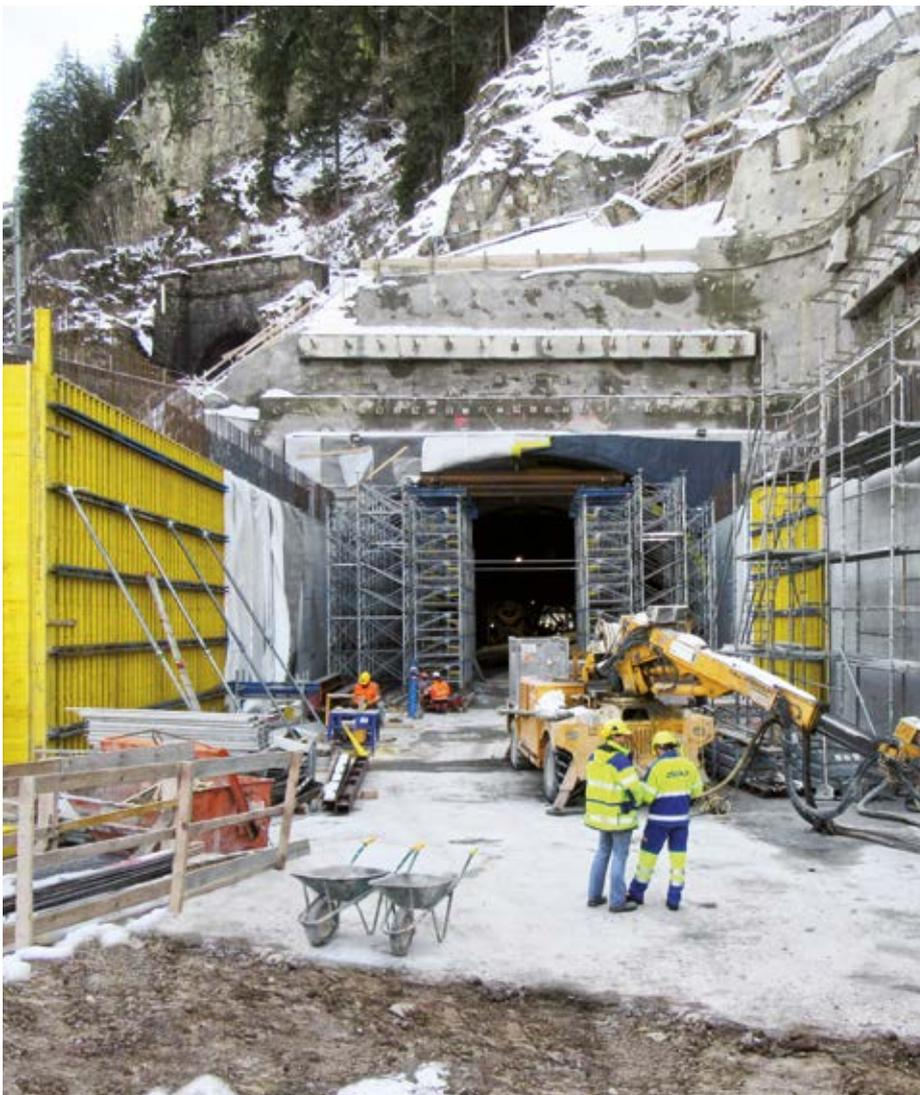
▲ Beim eckigen Nordportal kommt die Doka Leichtschalung mit Brettstruktur im Schiffsverband plus das Traggerüst Staxo 100 zum Einsatz.
