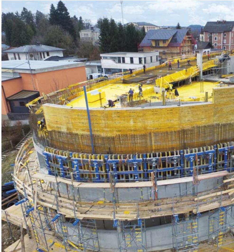
che zu erreichen, setzt die ausführende HABAU auf den robusten Dokamatic-Tisch. Die Deckentische können mit dem Umsetzgerät DoKart plus als komplette Einheit mit bis zu 12,5 m<sup>2</sup> von nur einer Person umgesetzt werden. Die Stützen werden mittels Spindel auf unterschiedliche Höhen eingestellt, um die gewünschte Neigung zu erreichen.
