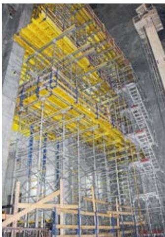
▲ Für den Bau der Decken wurde das Traggerüst Staxo 100 mit dem hochbelastbaren Verbundschalungsträger I tec 20 als Jochträger und H20 eco als Querträger kombiniert.
