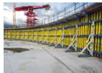
▲ 内模板第一层由剪刀式轴杆和起始装置进行支撑。
