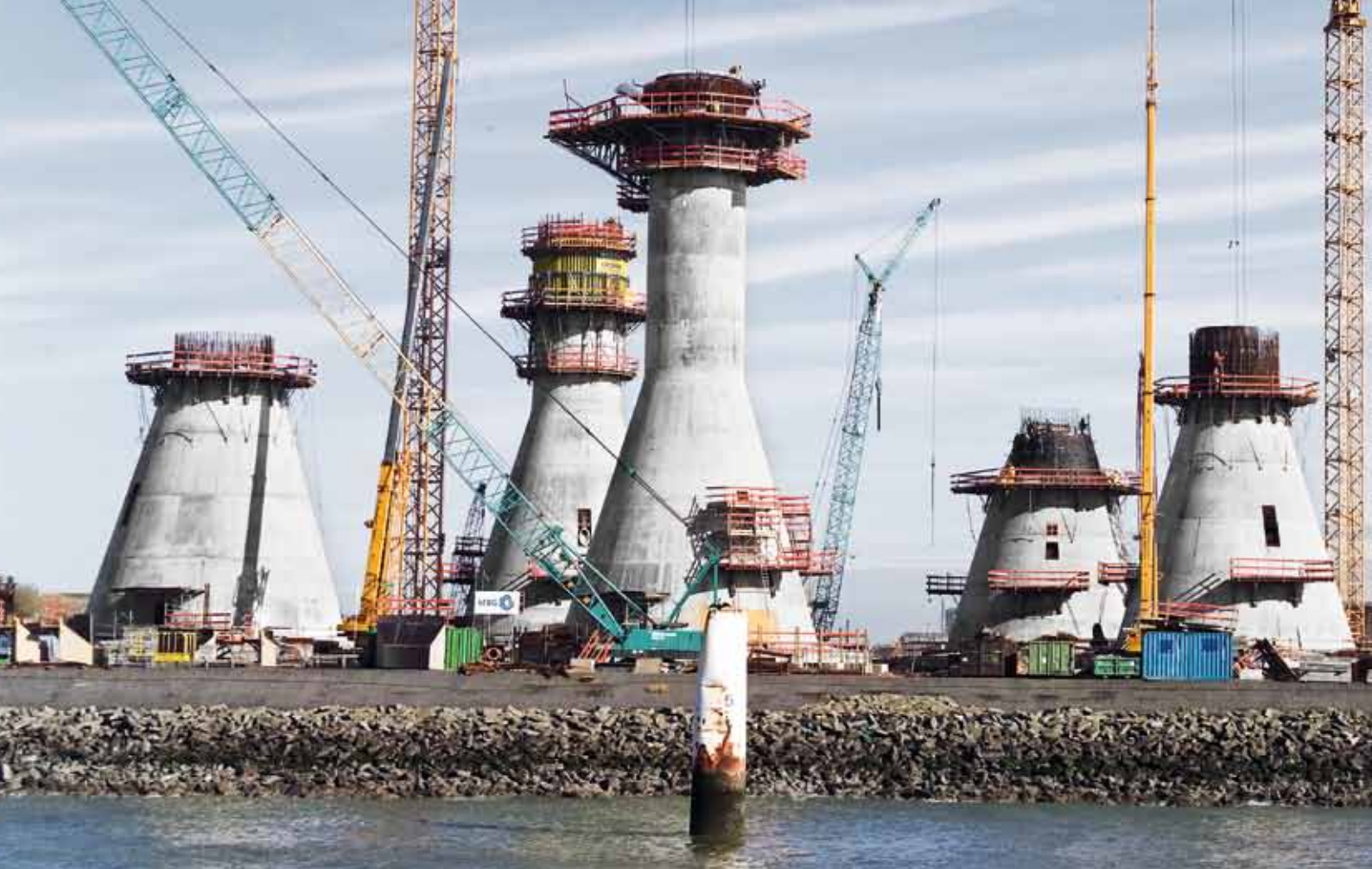
▲ 多卡系统在风车施工时用于基座和风车塔，例如，比利时的近海风电场Thornton Bank。
