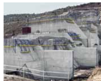
▲ 多卡的历史与发电站施工关系密切。多卡在国际发电站项目上积累的数十年经验，例如西班牙 Castrovido 大坝，在客户施工项目实施时使客户受益。
