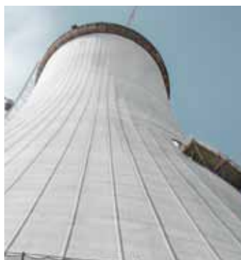
▲ 多卡为斯洛文尼亚煤电站Sostanj 164米高的冷却塔施工提供了以冷却塔模板 SK175 为基础的模板解决方案。用于1.50米高浇筑节段的自动爬升系统可以在极短周期时间内实现精确成型。
