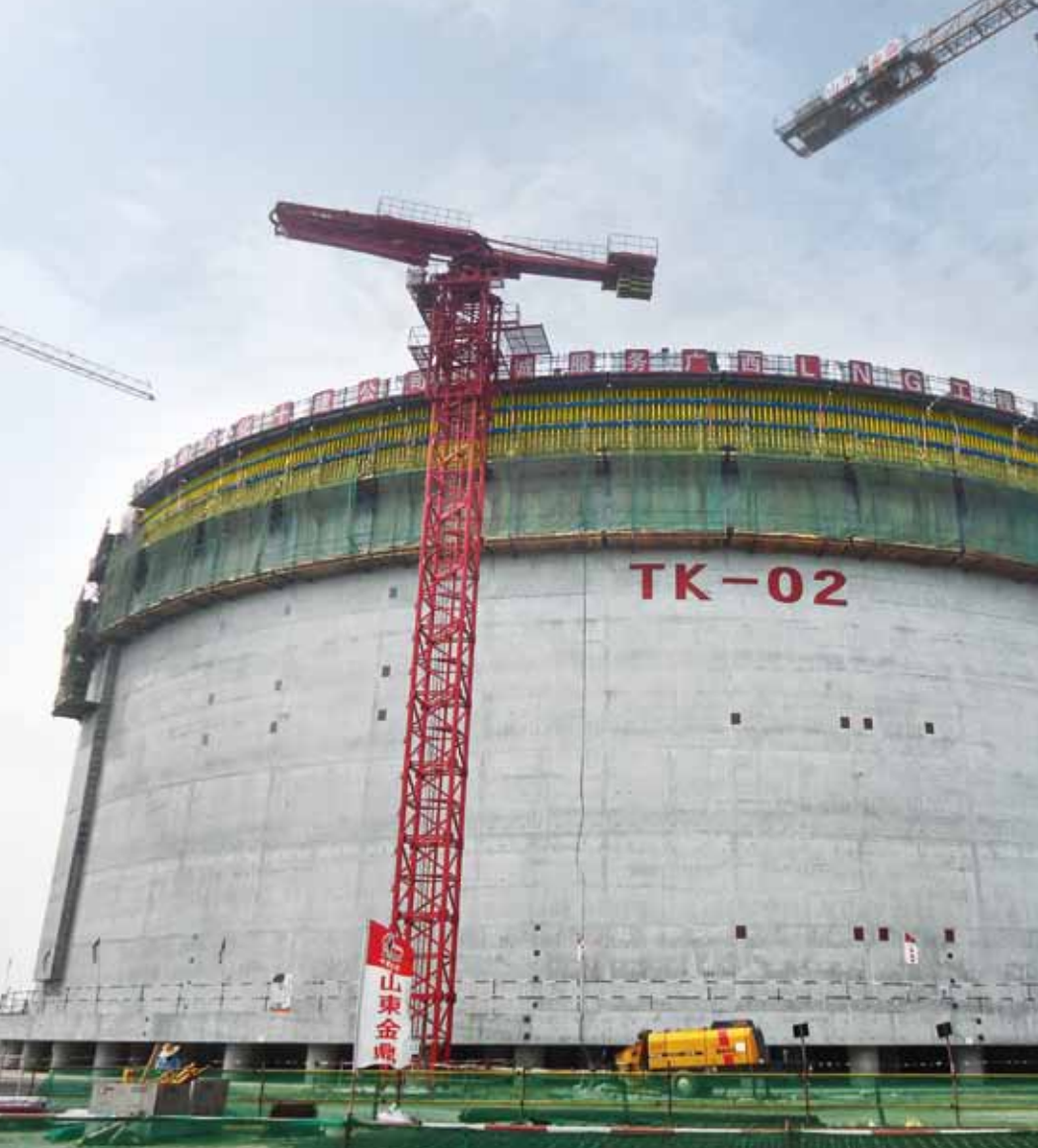
▲ 施工速度非常快，各流程非常紧凑且进行得有条不紊。
