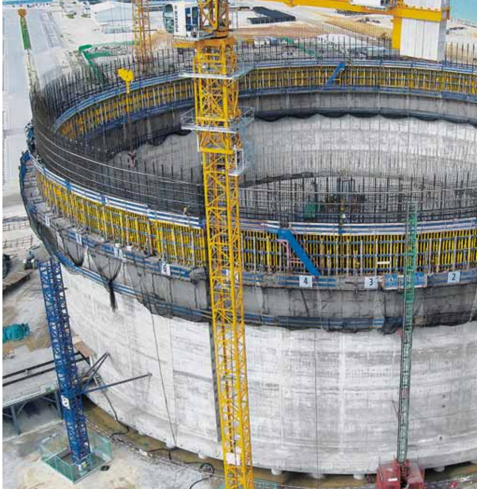
▲ 在直径82米、高52米的泰国液化气罐 Map Ta Phut 施工期间，塔吊提升爬升模板 MF240 确保了拼装流程有序且施工进度快速。
