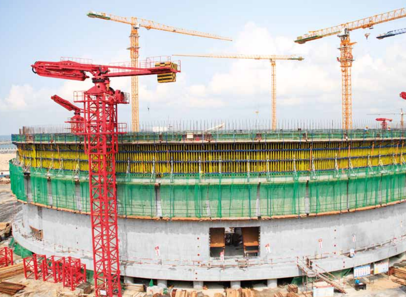
▲ 广西北海液化气项目施工现场
