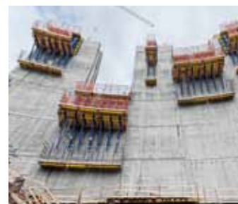
▲ 水坝模板 D35 首次亮相 多卡标准系统在挪威拦河坝 Dam Sarvsfossen 施工时首次被使用。
