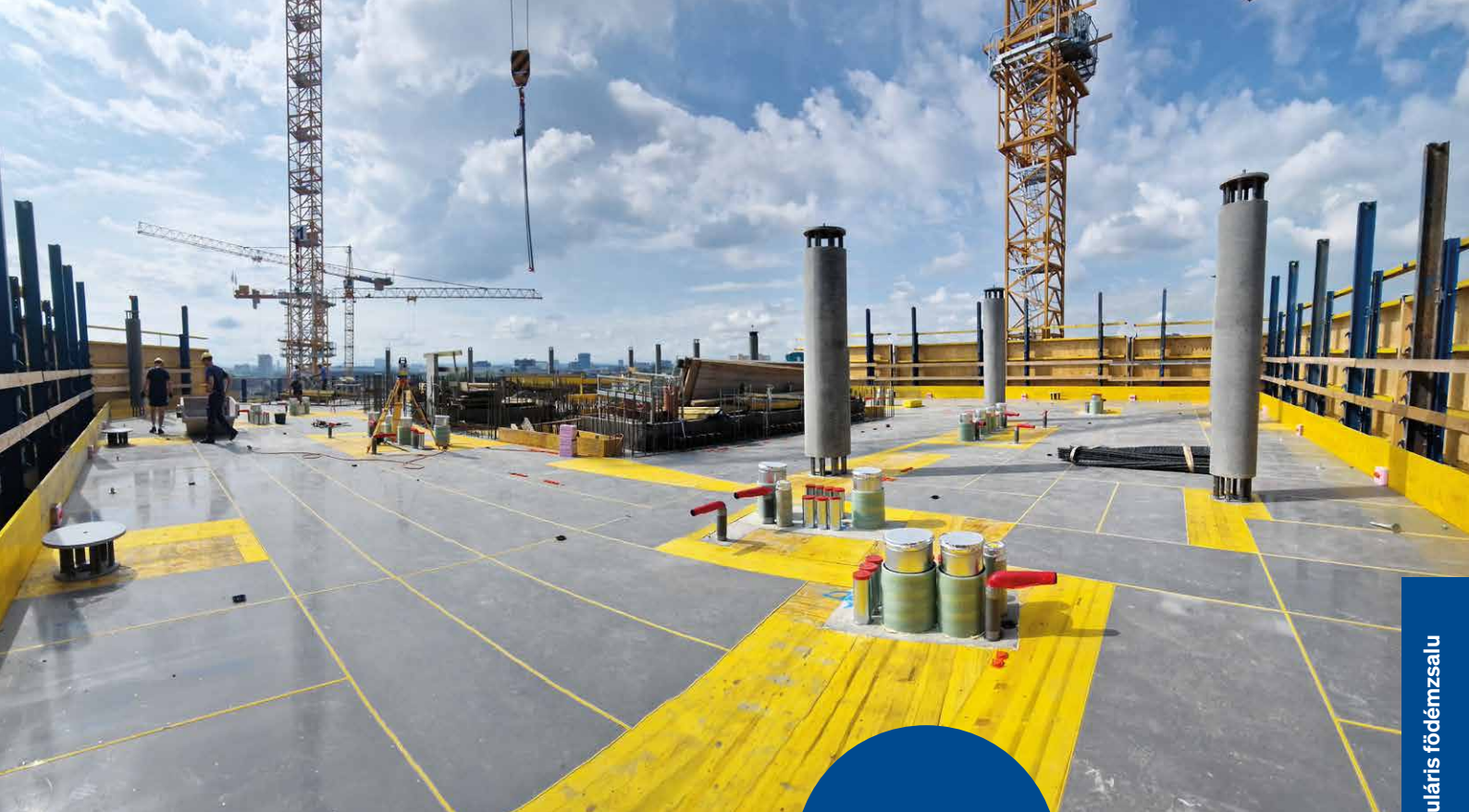
A DokaXdek moduláris födémzsalu bevetésén
