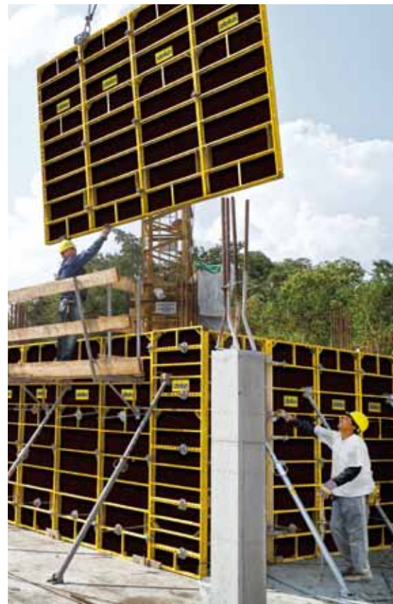
System deskowania ręcznego Frami eco - w przypadku użycia dźwigu - pozwala również na montaż elementów wielkopowierzchniowych.
