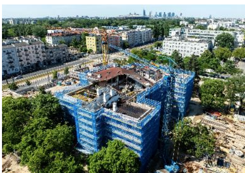
Varsó Praga Południe kerületében két Ringlock-rendszert használnak a Sinfonia Varsovia zenekar új székházának építéséhez. © Doka
