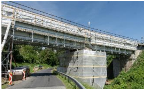
Az ausztriai Mühlkanal híd felújítása a Doka Ringlock állványzatával. © Doka
