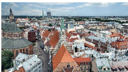
A lettországi Rigában, a Szent János-templomra egy 39 méter magas állványtornyot építettek Ringlock lépcsőrendszerrel. Ez lehetővé tette, hogy a munkások biztonságosan, a tetőn dolgozzanak anélkül, hogy azt megzavarnák. © Doka
