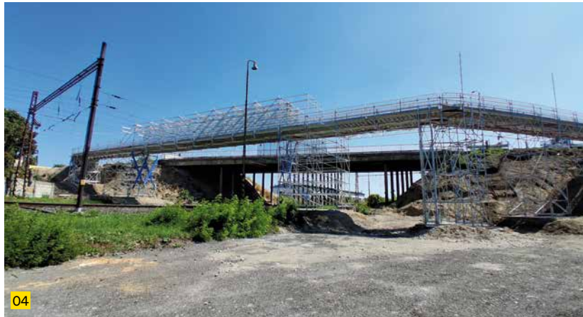
Systémové lešenie Ringlock je nasadené ako dočasný most ponad železniciu a starý most v havarijnom stave pred jeho demoláciou.
