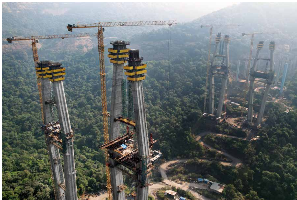
Po dokončení tohto projektu sa zásadne zlepší dopravné spojenie medzi metropolami Bombaj a Pune. Copyright: Doka
