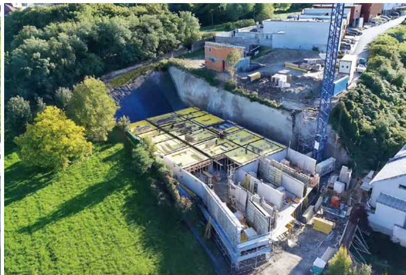
Železobetónové steny sú zhotovované pomocou rámového debnenia Framax Xlife 3,0 m, paralelne s realizáciou stropných konštrukcií systémom Dokaflex, ktorý umožňuje flexibilné prispôsobenie rôznym podmienkam stavby.
