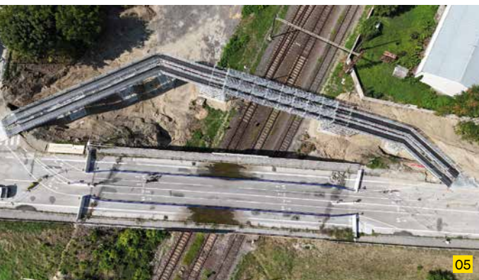
Pohľad na pôvodný most pred demoláciou a dočasný most postavený z Doka lešenia Ringlock z vtáčej perspektívy. Zdroj Facebook: Mesto Sered'
