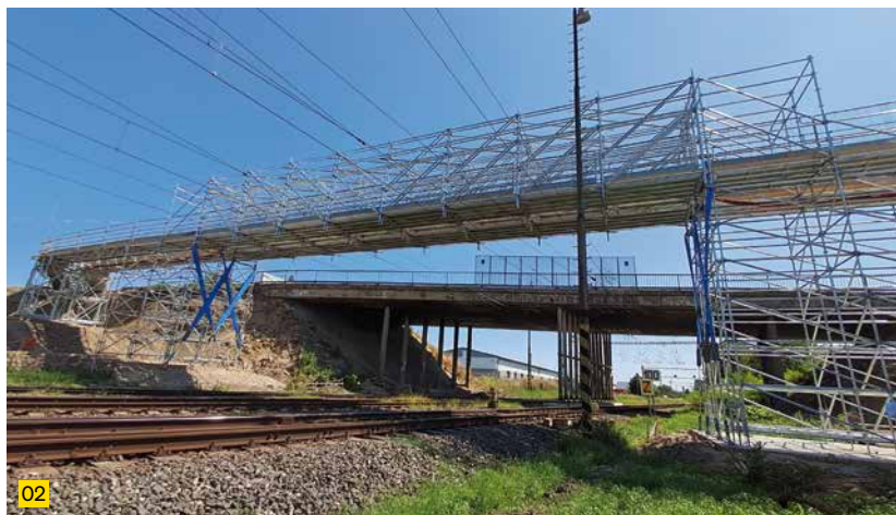
Najdlhšie pole dočasného mosta vytvoreného z bežných prvkov lešenia Ringlock má rozpätie až 20,5 m a bolo navrhnuté ako priehradový väzník s výškou 3,1 m.
