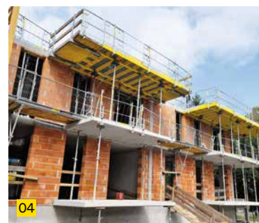
DokaXdek stoly sú vhodné na bezpečné riešenie debnenia obvodových oblastí stropu alebo balkónov.
