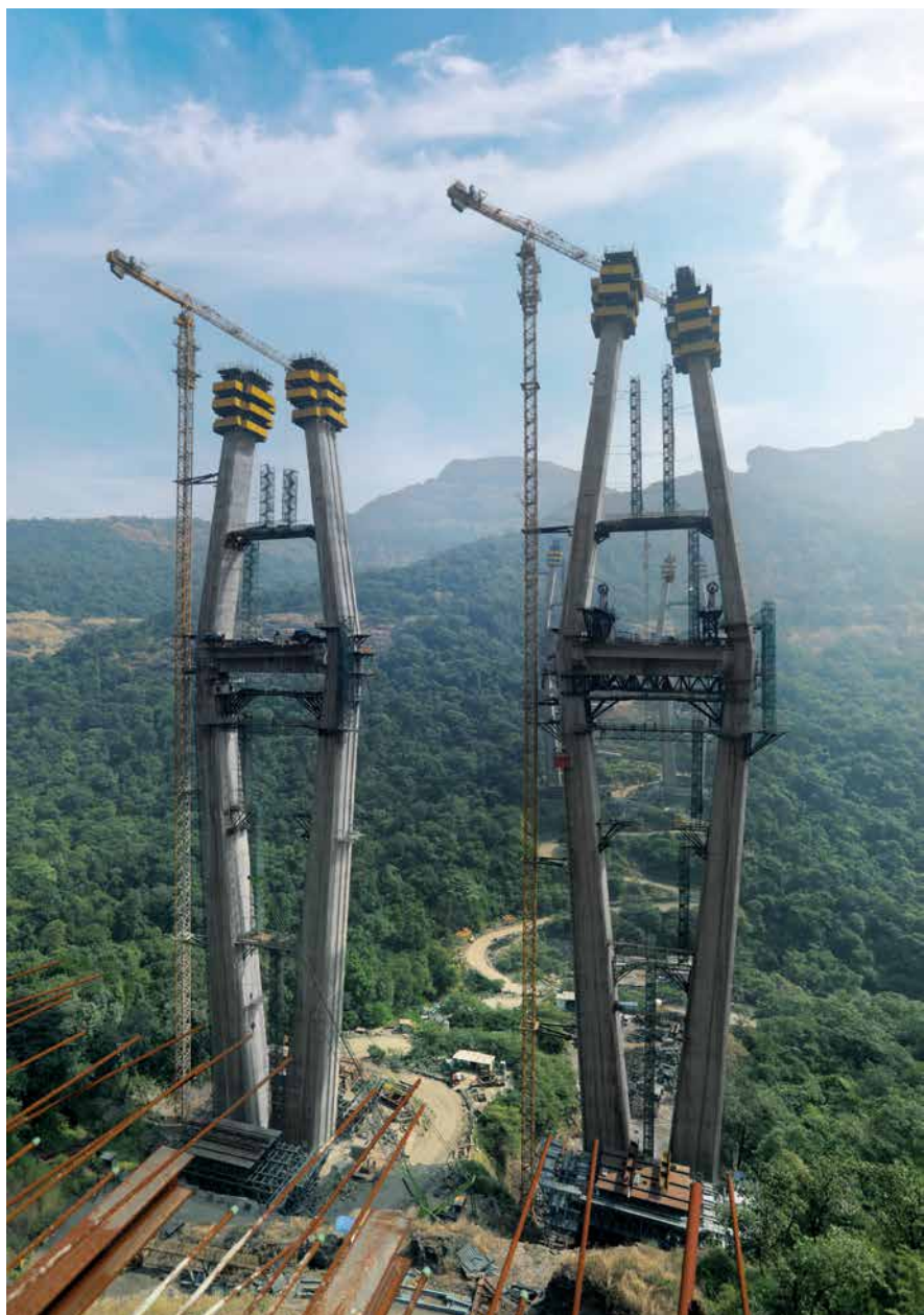
Na zhotovenie konštrukčne náročných pylónov v tvare diamantu sa nasadilo samošplhacie debnenie SKE50 plus a SKE100 Plus, vedené šplhacie debnenie Xclimb 60 a veľkoplošné debnenie Top 50.
