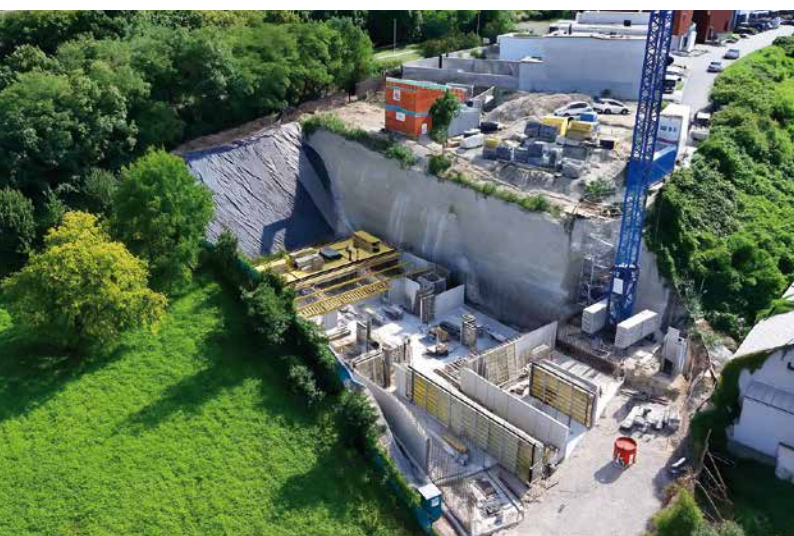
Železobetónové steny sú zhotovované pomocou rámového debnenia Framax Xlife 3,0 m, paralelne s realizáciou stropných konštrukcií systémom Dokaflex, ktorý umožňuje flexibilné prispôsobenie rôznym podmienkam stavby.
