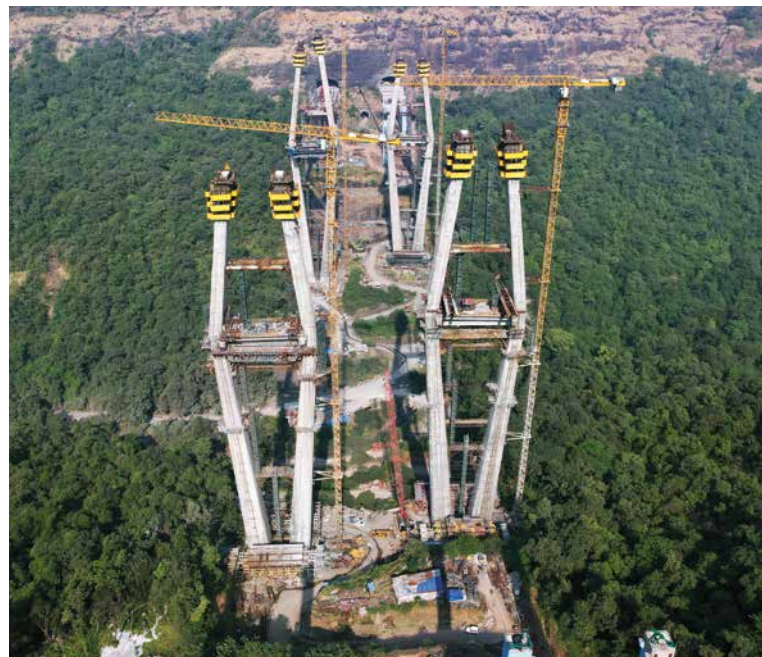
Impozantné rozmery: Pri pohľade zhora na celú stavbu naplno vynikne rozsah majestátnych pylónov s výškou 182 m. Copyright: Doka
