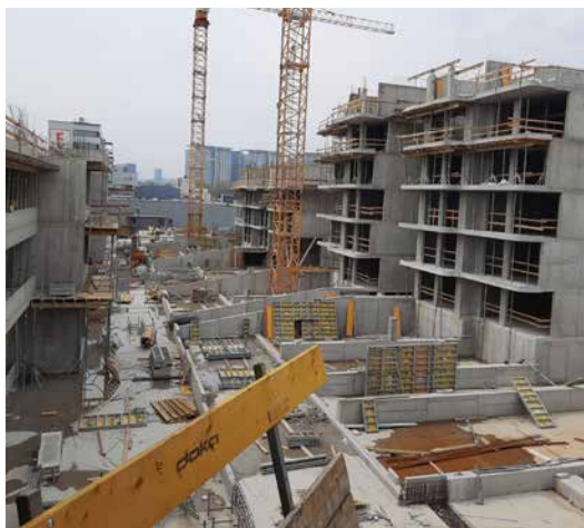
Výstavba komplexu sa realizuje pomocou Doka-systémového debnenia.
