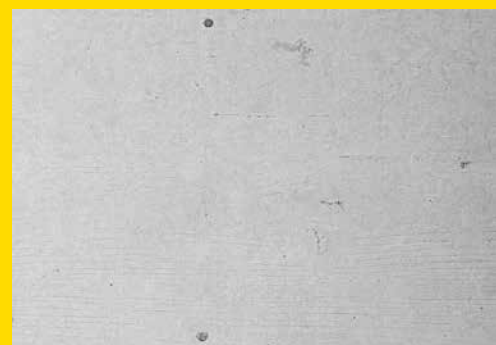
Typický odtlačok Doka debniacej dosky 3-SO na povrchu betónu.
