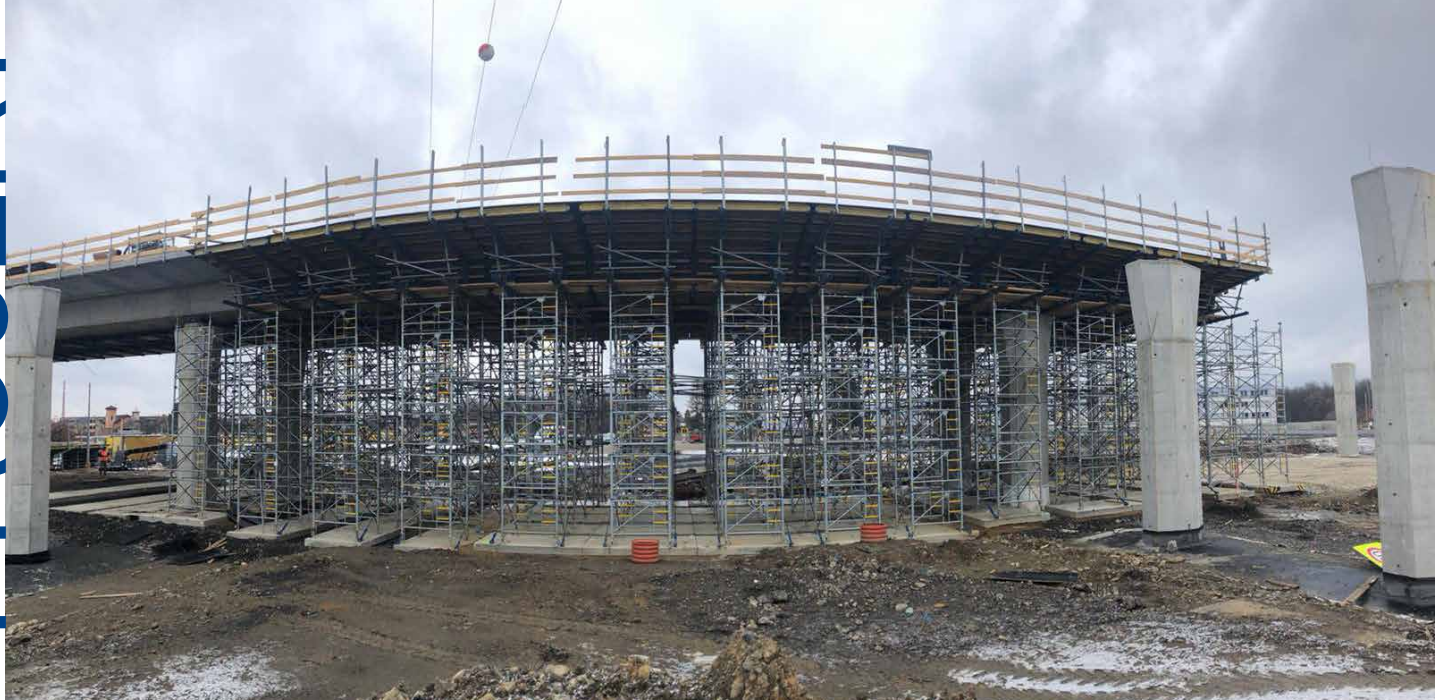
Obr. 1 SO 211: Podopretie jedného poľa mostovky podperným systémom Staxo 100. Na vytvorenie požadovaného tvaru nosnej konštrukcie dvojtrámového mosta sa používa nosníkové debnenie Top 50. Drieky a hlavice pilierov majú šesťuholníkový tvar.
