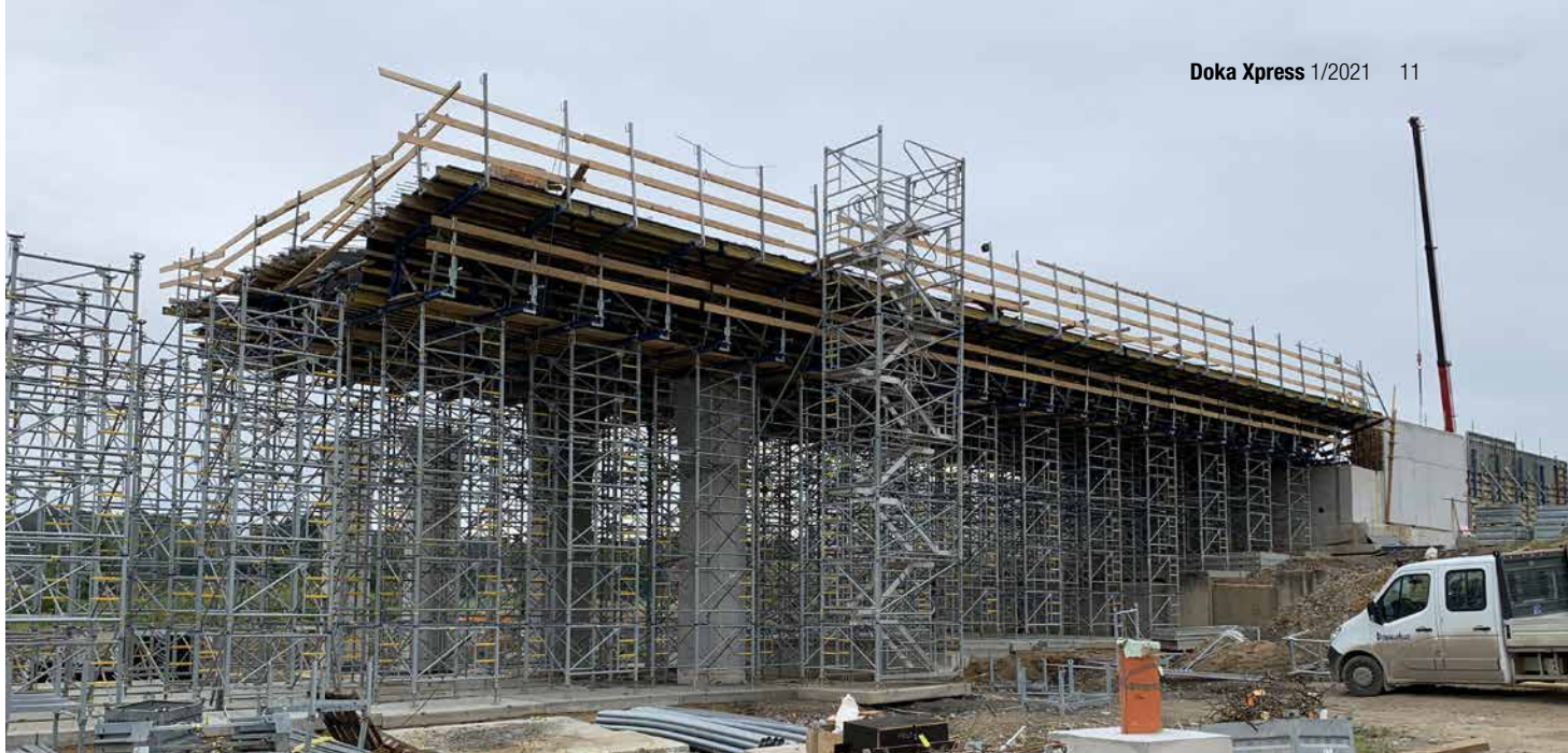
Obr. 2 Realizácia prvého záberu mostovky objektu SO 211 na úseku českej diaľnice R 48 Frýdek-Místek.
