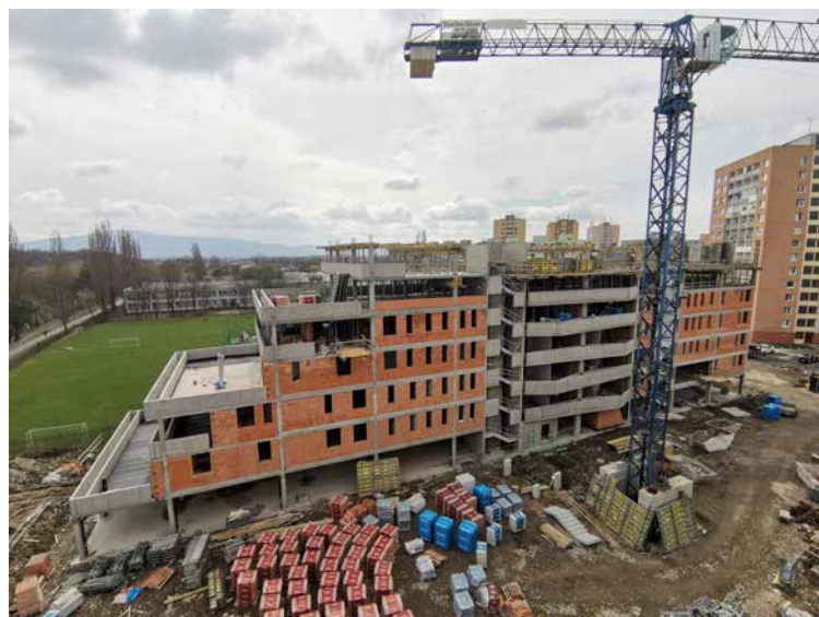
Výstavba druhej etapy projektu „Rezidencia LAGO“ na Galatickej ulici v Košiciach sa realizuje pomocou Doka-systémového debnenia.
