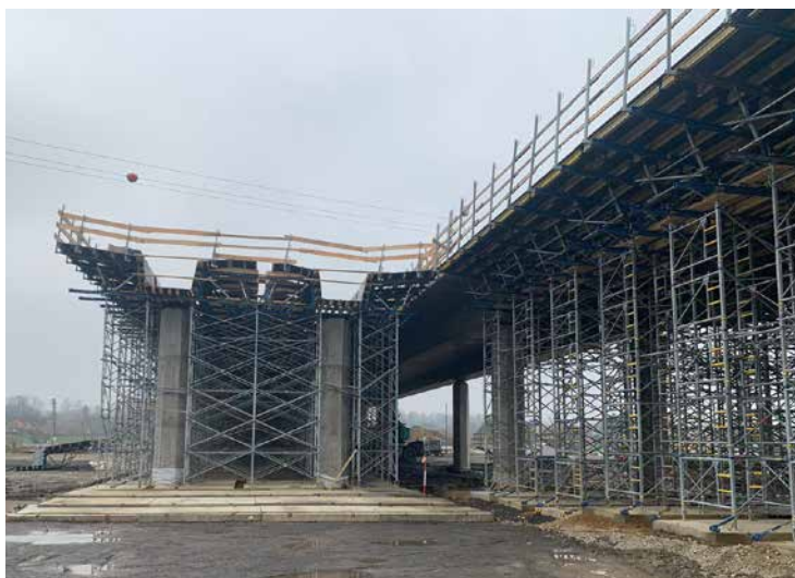
Obr. 3 Súbežná realizácia ľavej a pravej mostovky s časovým posunom o jedno pole.
