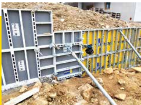
Oporný múr rodinného domu realizovaný súčasným nasadením ručných stenových systémov DokaXlight a Frami Xlife.
