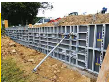
Oporný múr rodinného domu realizovaný súčasným nasadením ručných stenových systémov DokaXlight a Frami Xlife.
