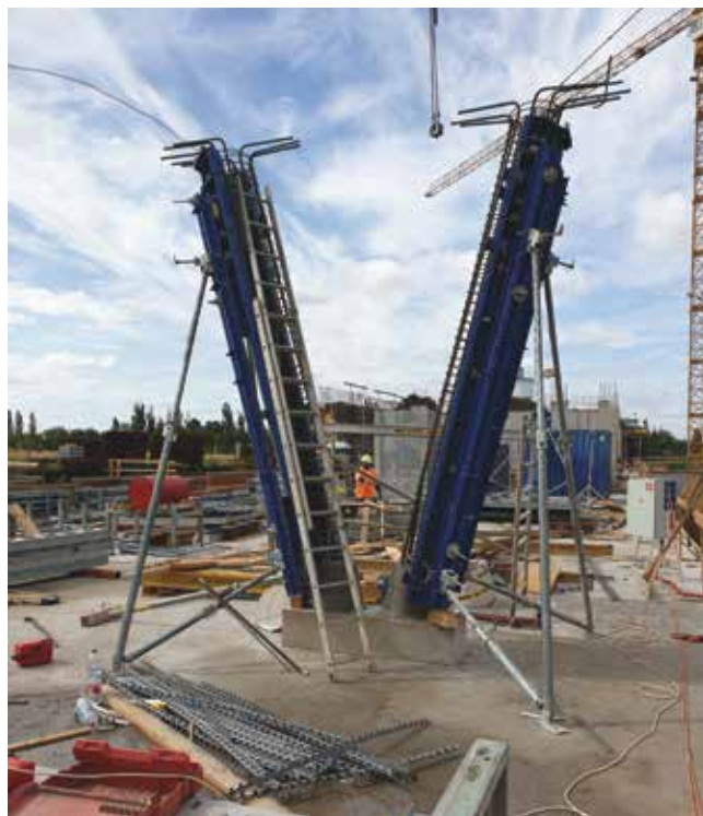
Realizácia stĺpa tvaru „V“ na objekte A01 pomocou stĺpového debnenia RS
