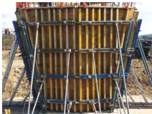
Doka drevené nosníky H20 top P využité v systéme stenového debnenia Top 50
