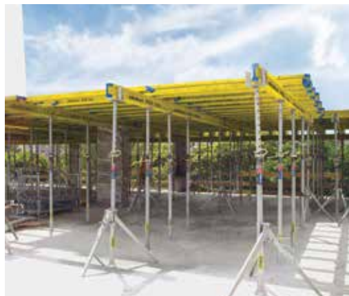
Doka drevené nosníky H20 top P využité pri stropnom debnení Dokaflex
