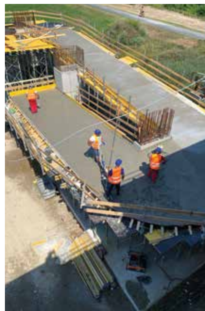
Pohľad na zrealizovaný prvý výškový záber nosnej konštrukcie rampy
