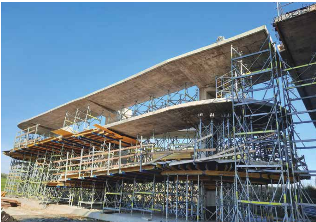
Konštrukcia rampy pri procese oddebňovania
