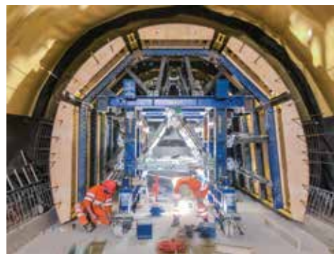
Jeden z tunelových debniacich vozíkov SL-1 bol zhotovený kombináciou podpernej konštrukcie SL-1, drevených ramenátov a debniacej dosky
