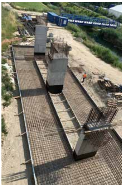
Základová doska a piliere lávky pre peších sa zhotovili pomocou ľahkého stenového systému Frami Xlife
