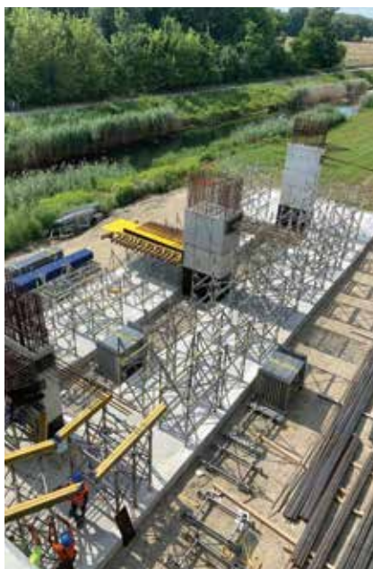
Prebiehajúca výstavba podperných systémov Staxo 40 a Staxo 100
