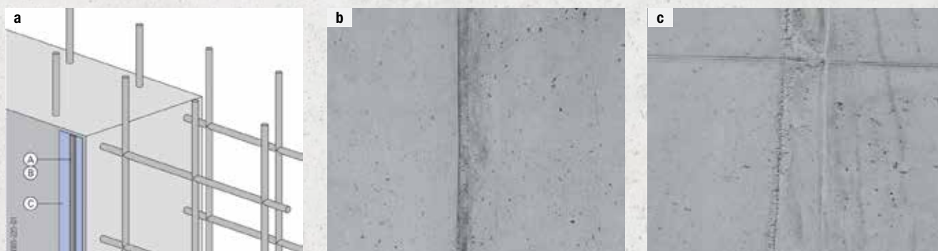
Obr. 9: a) utesnenie vertikálnej špáry, b) pracovná škára s tesniacim pásom, c) pracovná škára bez tesniaceho pásu
