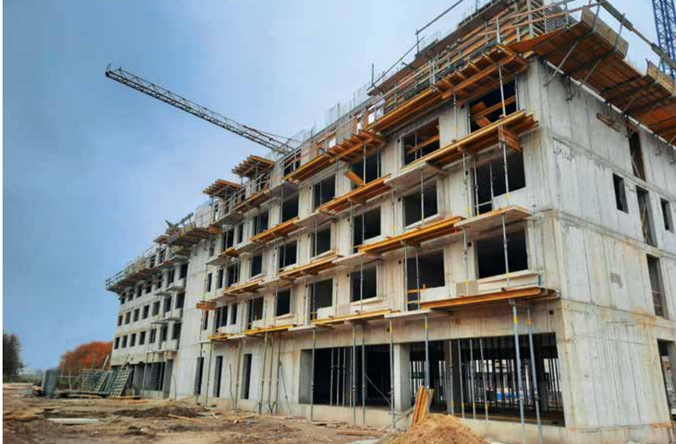
Výstavba bytového domu E komplexu Ovocné sady sa realizuje pomocou Doka-systémového debnenia
