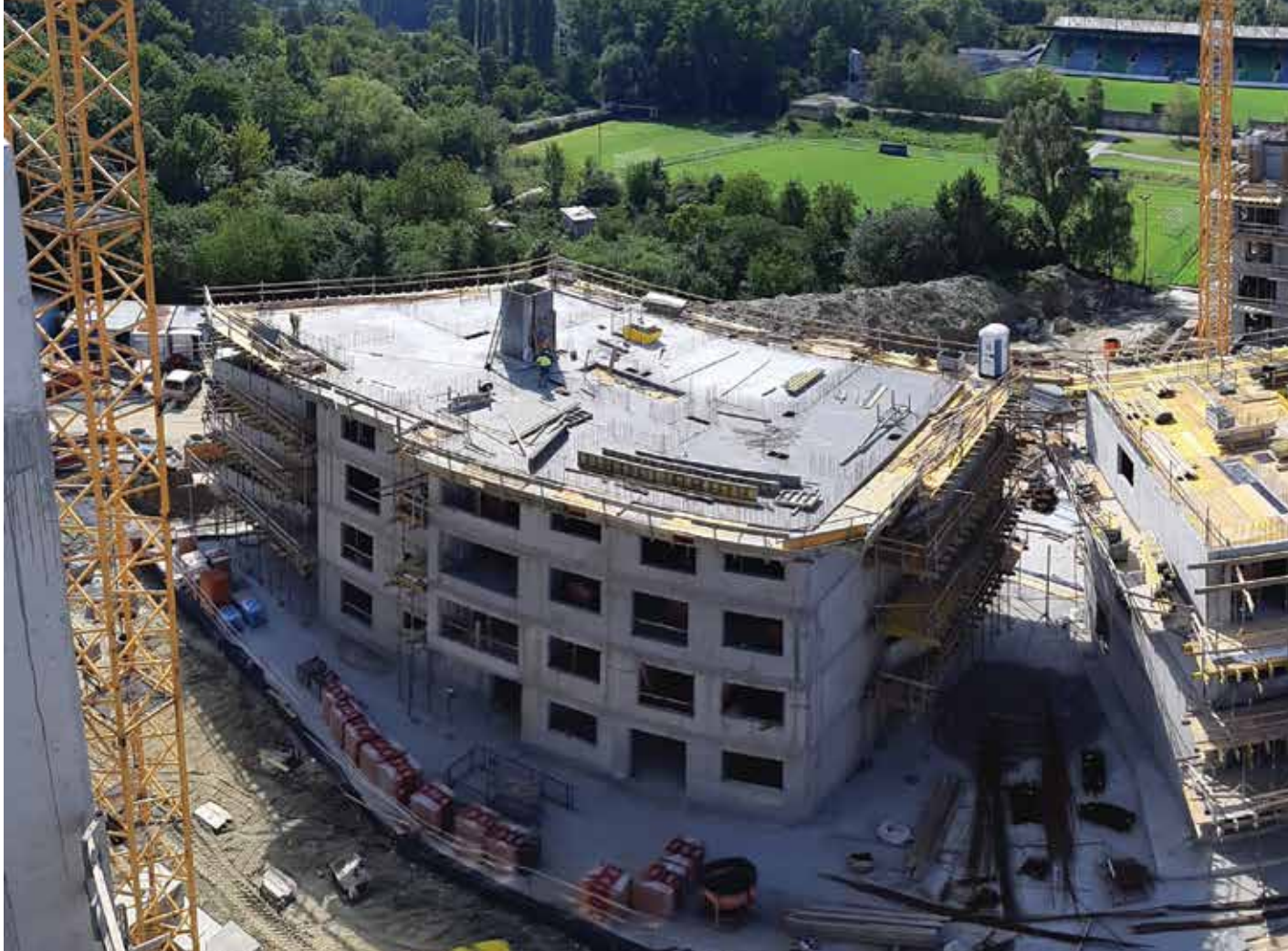
Pohľad na rozostavané objekty L a M bytového komplexu Čerešne 2
