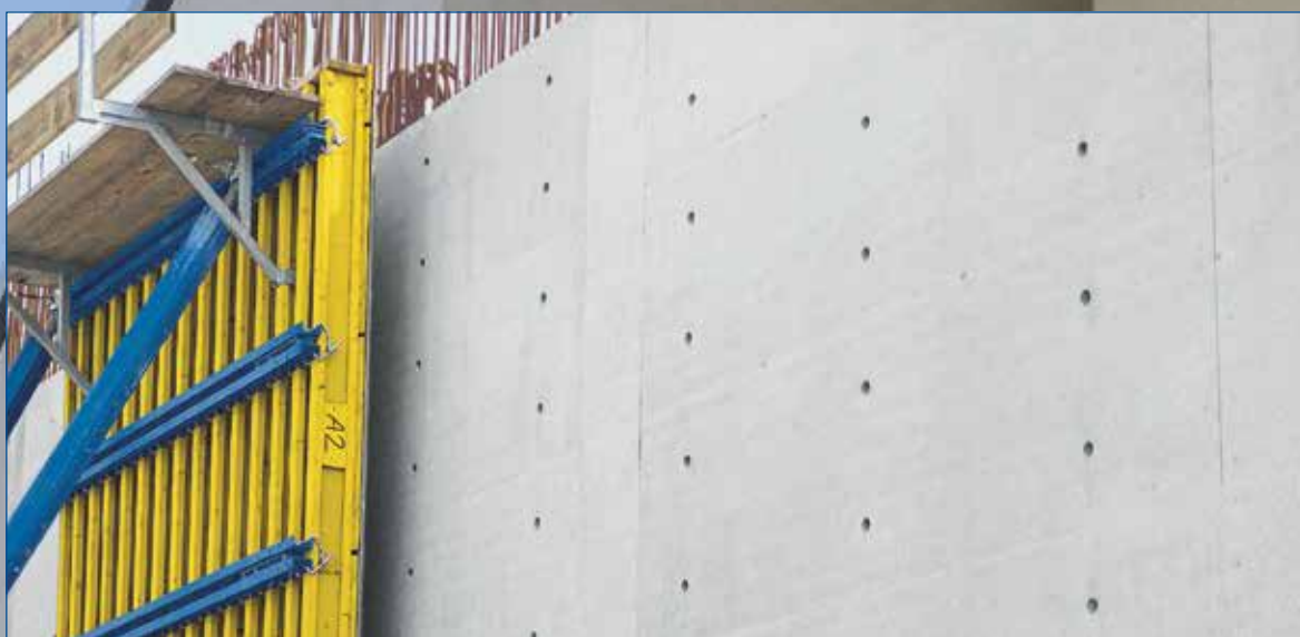
Obr. 1: Pohľadový betón vytvorený pomocou nosníkového debnenia Top 50. Použitá debniaca doska – brezová preglejka s filmom z fenolickej živice.
