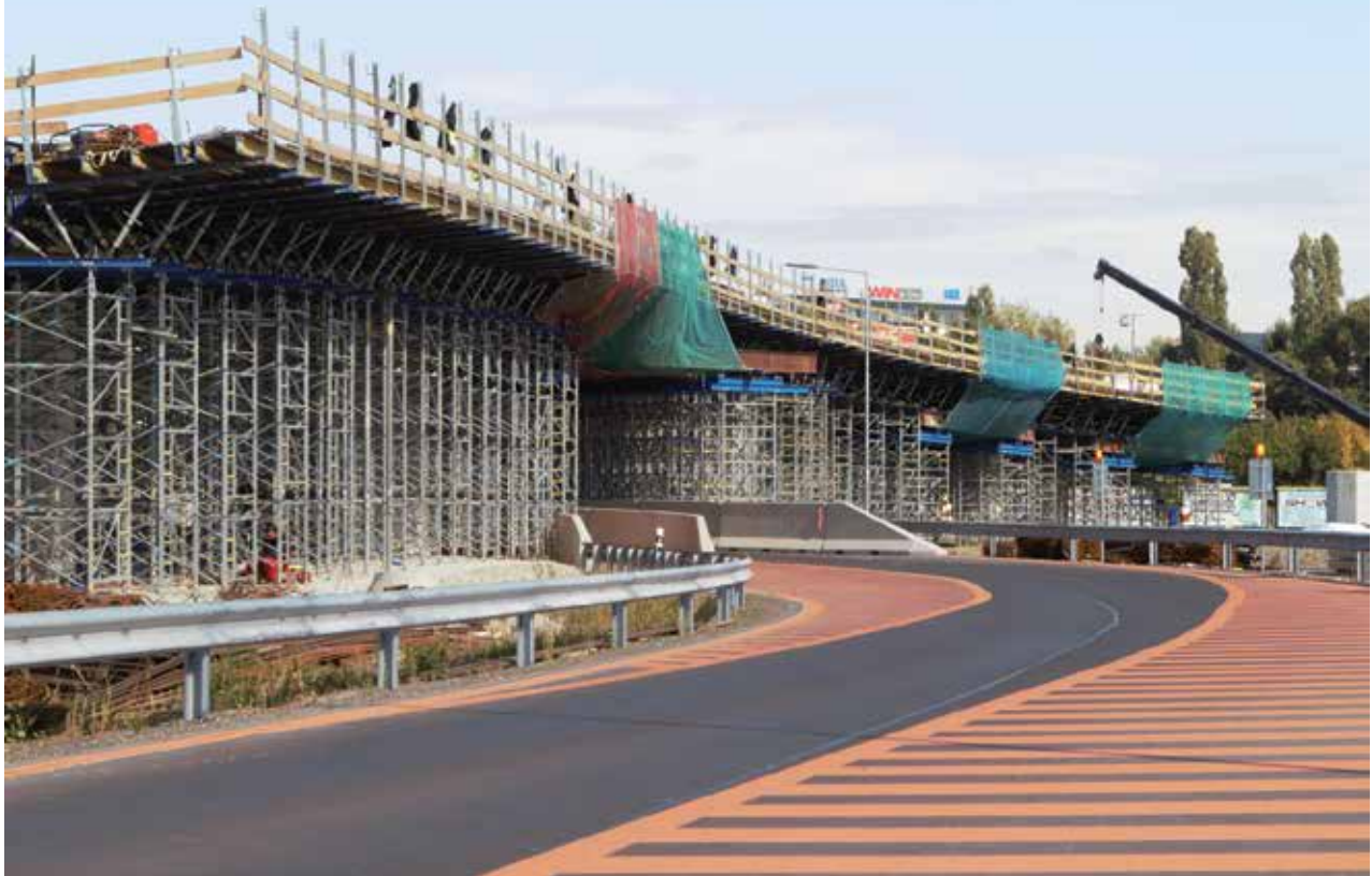
Rozostavaný objekt 201-00. Podopretie nosnej konštrukcie pomocou podperného systému Staxo 100 a nosníkového debnenia Top 50.
