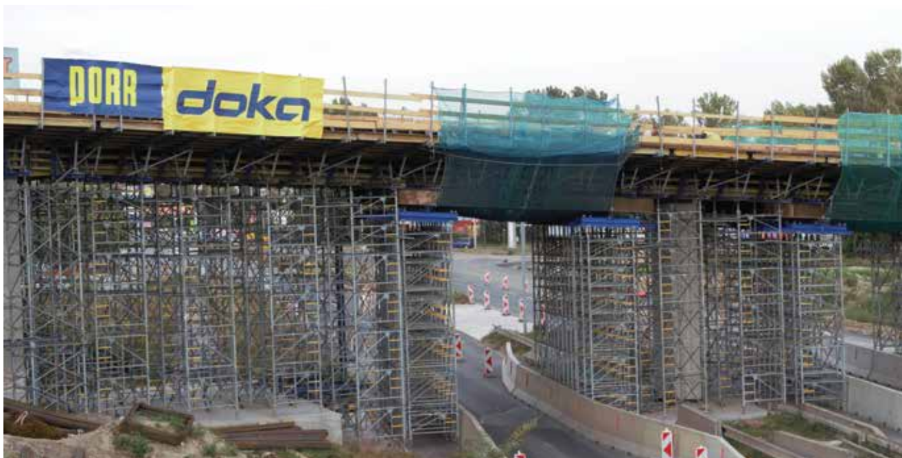
Gabarit ponad jestvujúcu komunikáciu so šírkou prejazdu 3,5 m sa realizoval pomocou podperných veží Staxo 100 a ocelových profilov IPN 500
