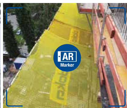
AR-VR: Video – Ukážka praktickej montáže Doka záchytných sietí SNF
