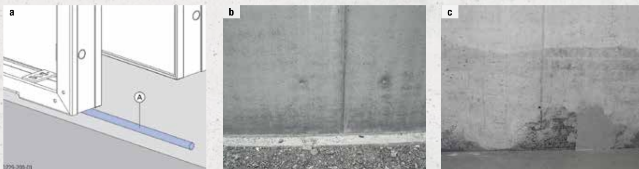
Obr. 8: a) tesniaci povrazec D2, b) stena s tesniacim povrazcom, c) stena bez tesniaceho povrazca
