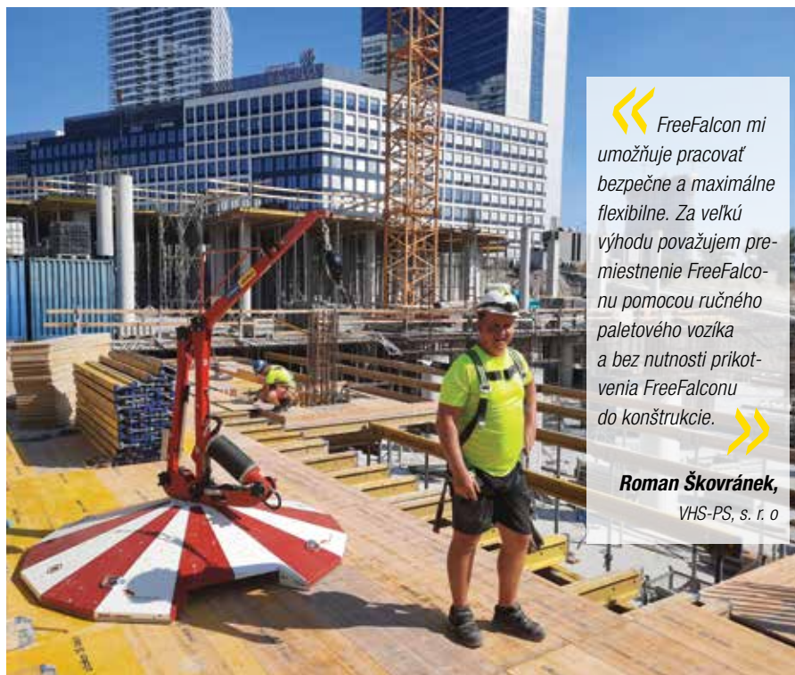
Nasadenie zariadenia FreeFalcon pri montáži stropného debnenia Dokaflex
