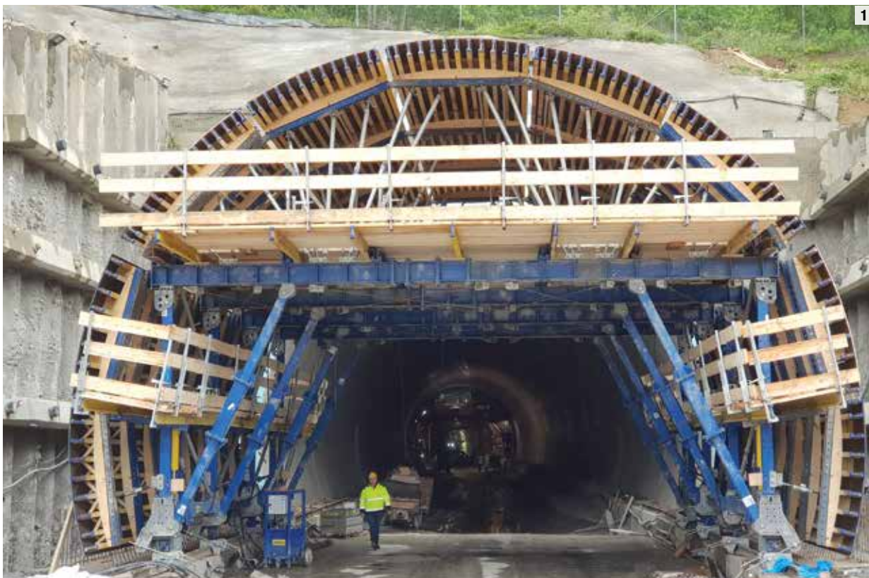
Tunelový systém DokaCC pre výstavbu otvorených tunelov umožňuje rýchly, efektívny a bezpečný postup prác
