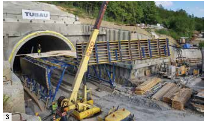
3 Montáž vopred zhotovených vnútorných panelov Top 50 a ich prichytenie na debniaci vozík DokaCC
