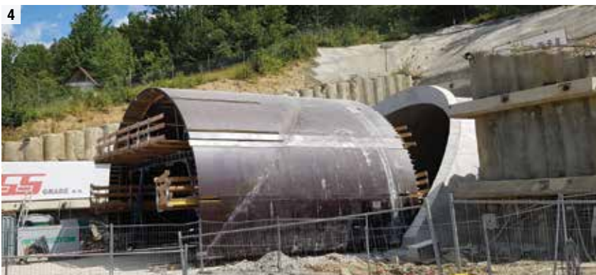
4 Tunelový systém DokaCC je prispôbitelný na pravouhlý, ako aj kruhový prierez tunelového objektu
