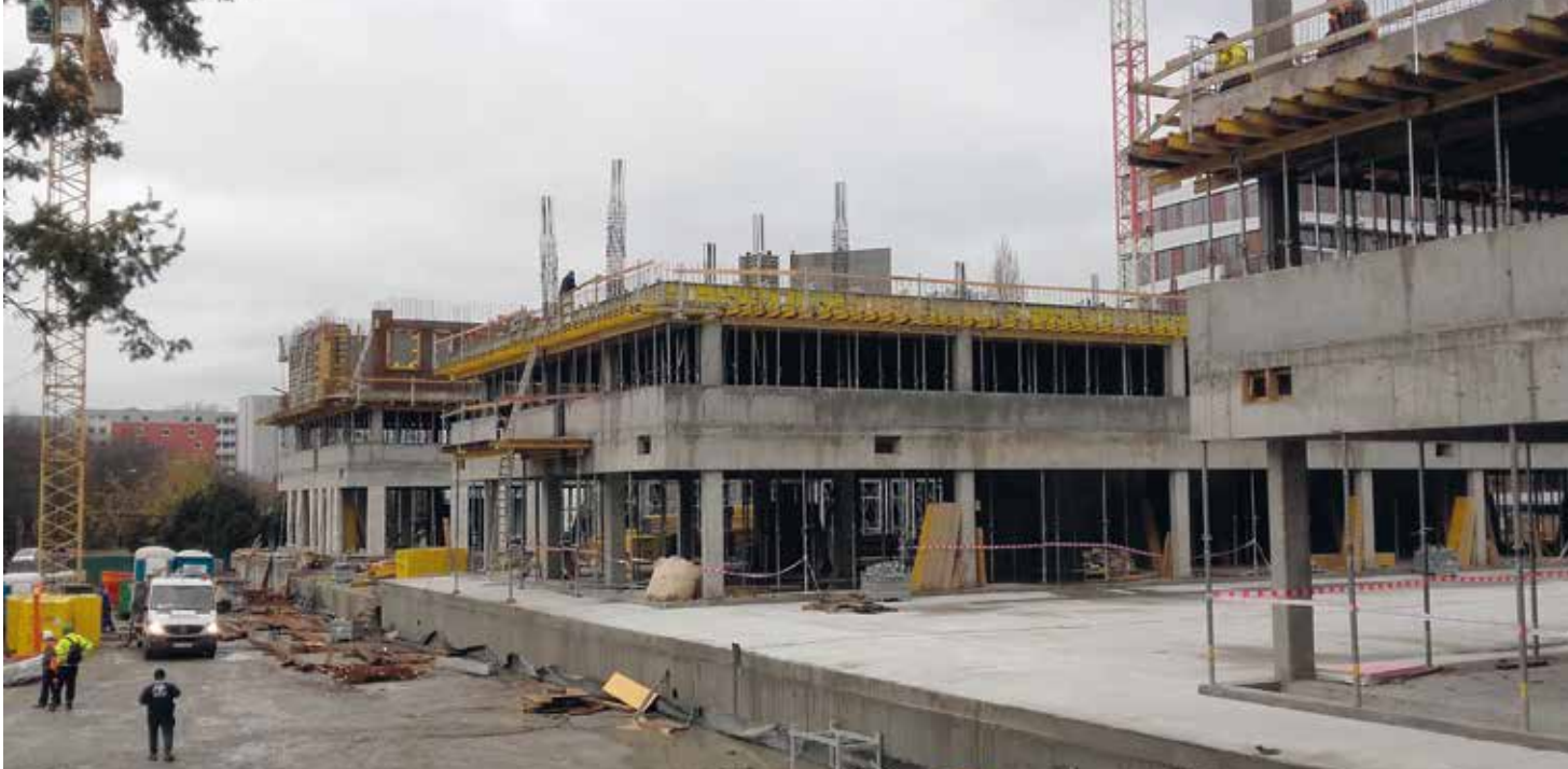
Prebiehajúca výstavba dvoch objektov polyfunkčného projektu Omnia Business Center
