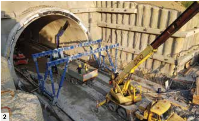
2 Osadzovanie zmontovaných priečnych rámov tunelového systému DokaCC pomocou mobilného žeriava priamo na koľajnicovú dráhu
