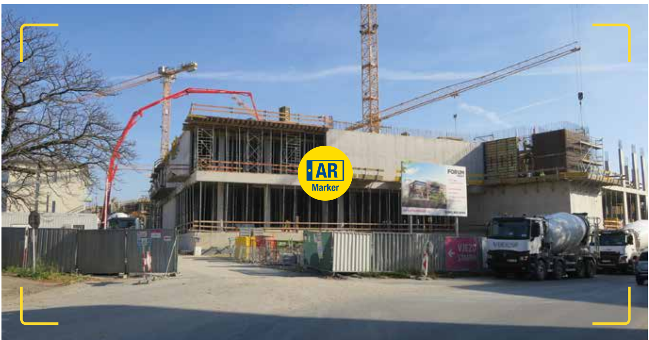
Na rozsiahlom projekte, akým je OC Forum Prešov, sa súběžne pracuje na viacerých častiach a konštrukciách. Na fotografii je vidieť betónáž stropu a vystužovanie stien v rovnakom čase.
