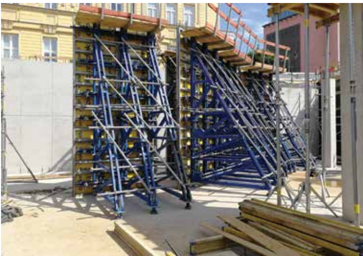
Rámové debnenie Framax Xlife s výškou 5,4 m doplnené opornými kozami Universal F je vhodné riešenie na realizáciu vysokých, jednostranných obvodových stien
