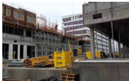
Podopretie balkónov sa realizovalo pomocou podperného systému Staxo 40
