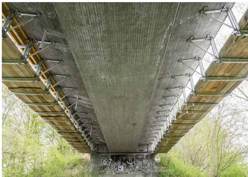
Nasadenie rímsového debnenia NG pri rekonštrukcii mosta.
