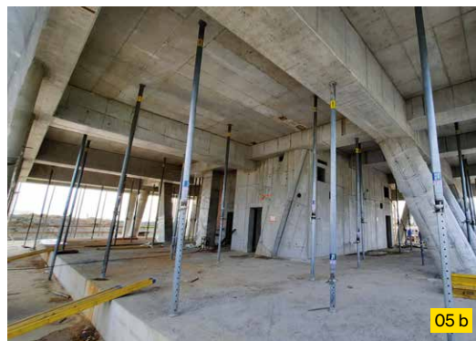
05 a, b Realizácia vysokých prievlakov pomocou podperného systému Staxo 100 a ručného stenového debnenia Frami Xlife.
