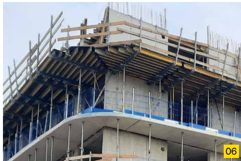
06 Hospodárne riešenie zadebnenia balkónov pomocou stolových panelov Top 50 vytvorených na mieru, ktoré umožňujú bezpečnú prácu na okraji stavby v kombinácii s možnosťou rýchleho presunu na ďalšie podlažie s veľmi malou prácnosťou.
