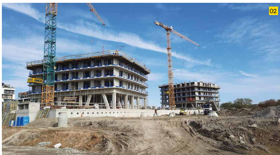
02 Pohľad na vyrastajúce výškové budovy v zóne Slnečnice Nad mestom. Výstavba sa realizuje nasadením systémových debnení Doka.
