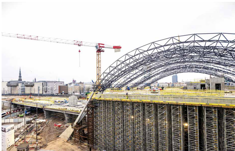
Produkty Doka zohrávajú kľúčovú úlohu pri zhotovení širokorozponovej ocelevej konštrukcie a obrovskej sklenenej strechy hlavnej stanice v Rige.
