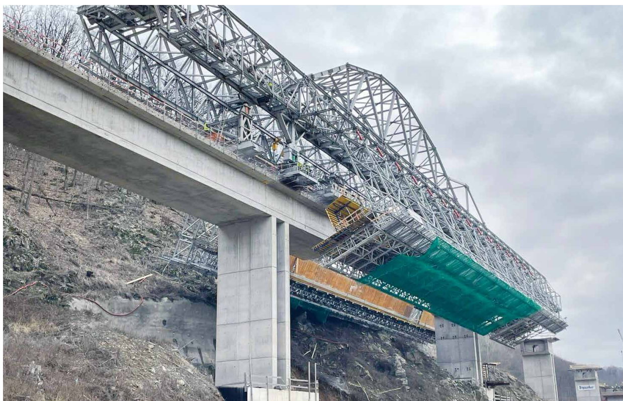
07 Pohľad na výsuvnú skruž Berd v stave presunu do ďalšieho záberu.
