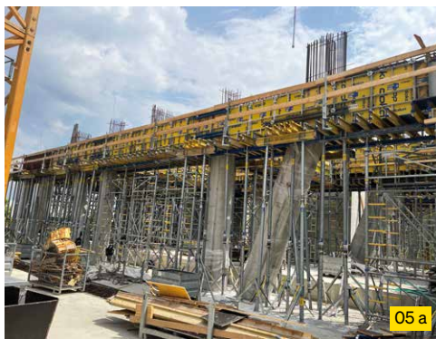
05 a, b Realizácia vysokých prievlakov pomocou podperného systému Staxo 100 a ručného stenového debnenia Frami Xlife.
