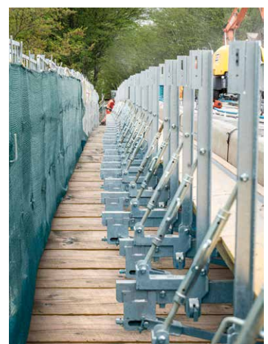
Plne opláštená pracovná plošina zabezpečuje maximálnu ochranu proti pádu osôb a predmetov.
