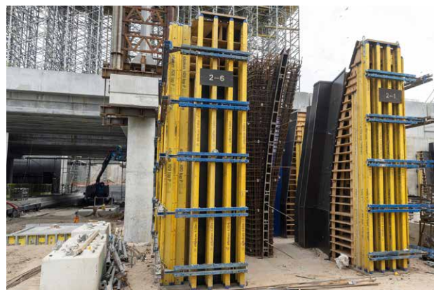
Vďaka debniacim riešeniam na mieru, ktoré zahŕňali 570 predmontovaných panelov Top 50, a dodávkam ďalších 50 kamiónov prvkov pevných skruží, sa podarilo úspešne splniť náročné požiadavky projektu.
