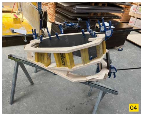
04 Na mieru vyrobená základňa pre šikmé stĺpy v našom servise predmontáže debnenia.
