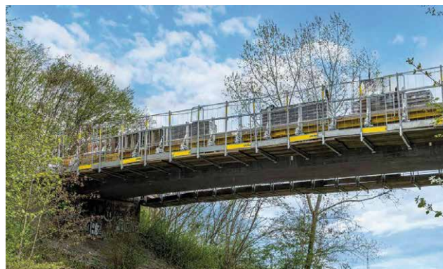
Nasadenie rímsového debnenia NG pri rekonštrukcii mosta.
